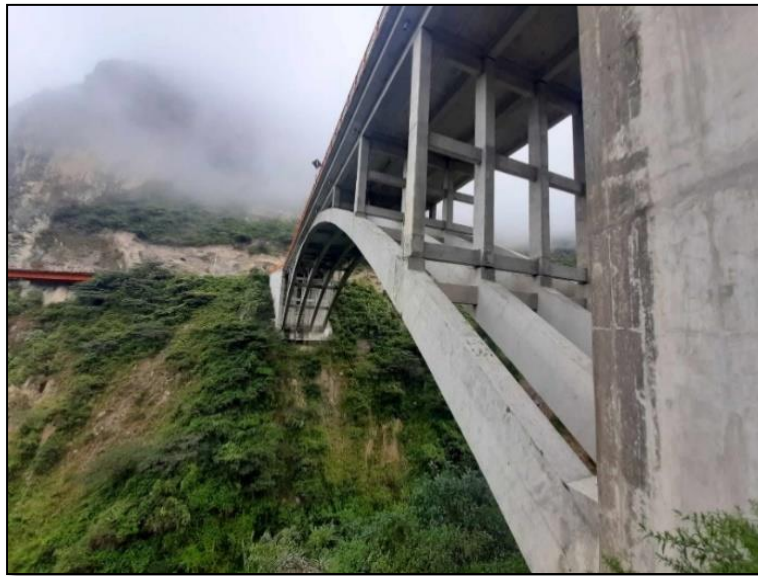
Figura N° 18: Vista de las estructuras del puente
