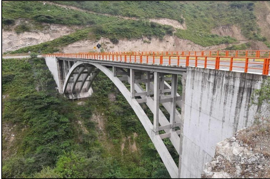
Figura N°15: Vista panorámica del puente El Tingo
