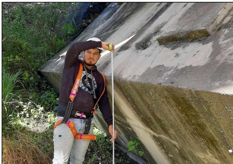
Figura N° 16: Mediciones de la estructura
