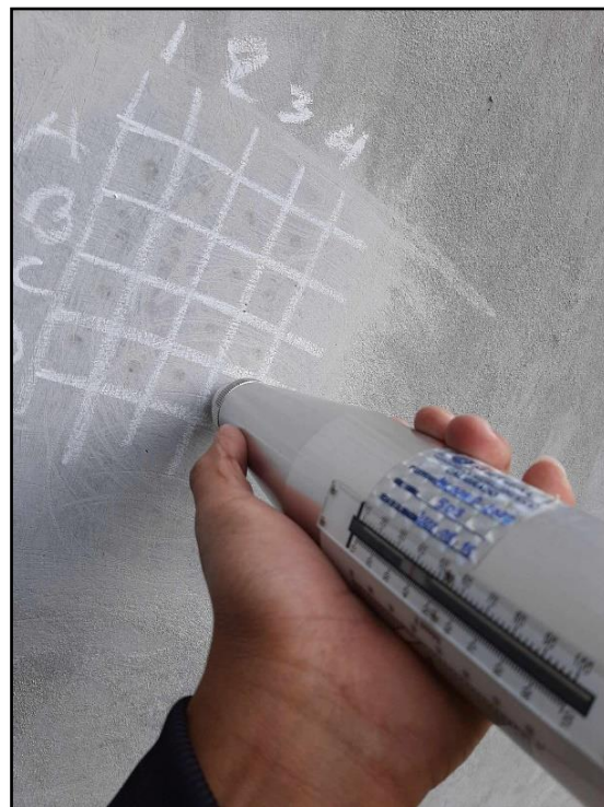
Figura N° 29: Vista cuadrícula dibujada en la estructura para toma de lectura
