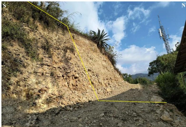
**Foto 32:** Talud de suelo arcillo-limoso y bloques de roca caliza marga
