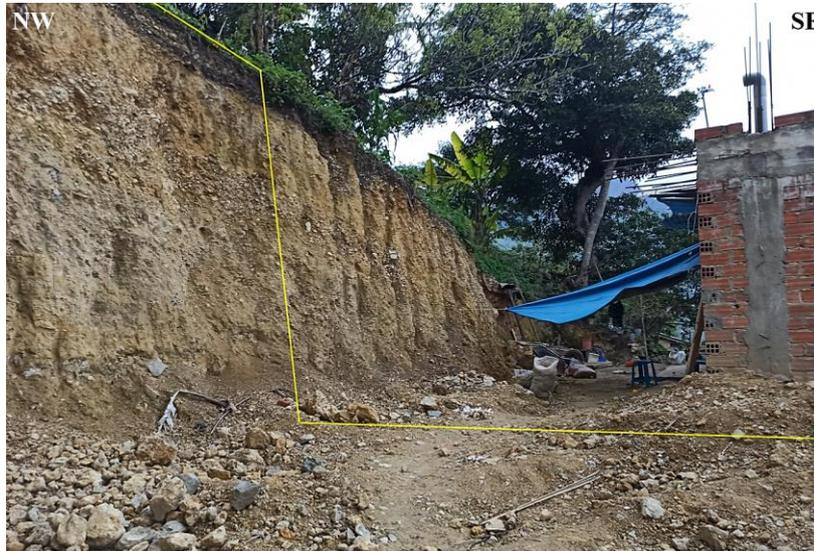
**Foto 28:** Talud de suelo limo-arcilloso y fragmentos de roca caliza
