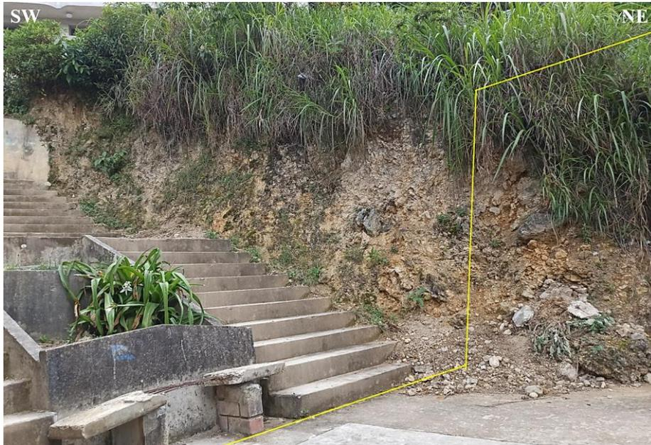
**Foto 30:** Talud de suelo limo-arcilloso
