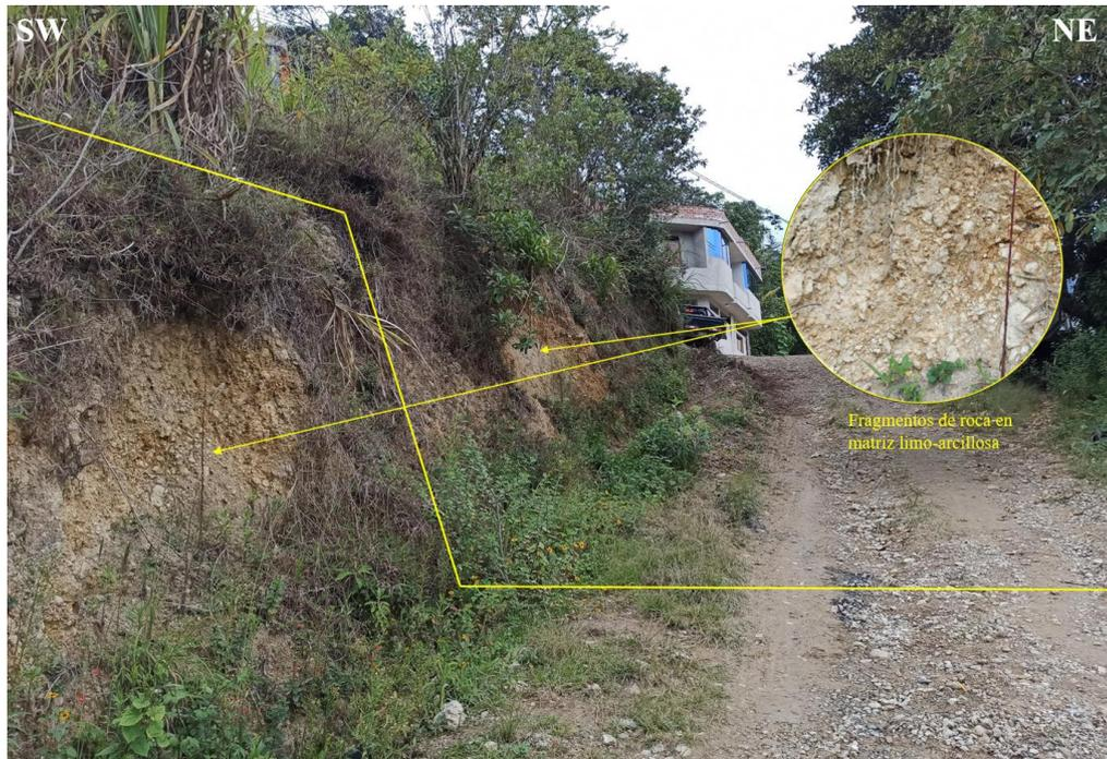
**Foto 29:** Talud de suelo limo-arcilloso
