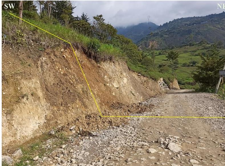
**Foto 20:** Talud de suelo conformado principalmente de material arcilloso
