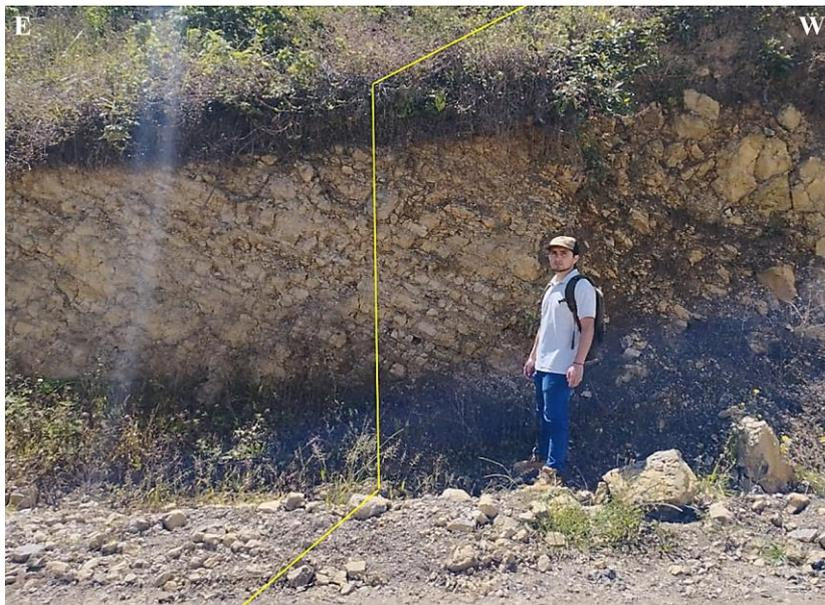
**Foto 33:** Calizas nodulares y una capa de suelo limoso en la corona del Talud 16
