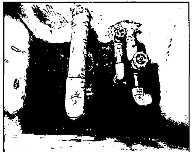
**Foto 1.6.** Reservorio del Caserío El Cerrillo presenta un cerco de protección en mal estado, caja de válvulas con accesorios oxidados y fallas en la operación.
