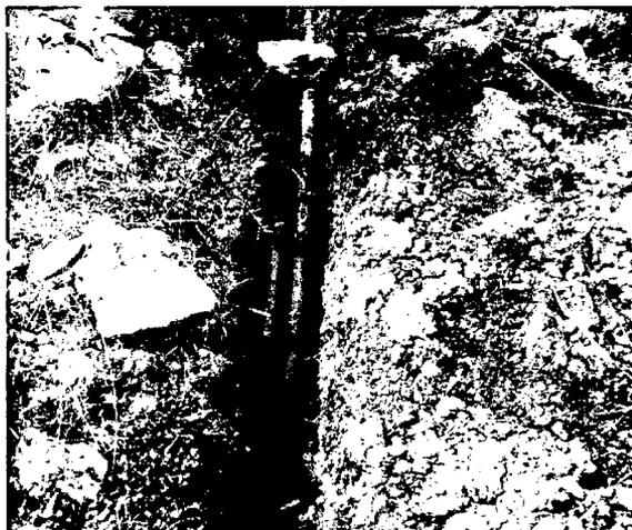
**Foto 2.4.** Tubería del sistema de agua potable del caserío Quinuapata no está enterrada en su totalidad.
