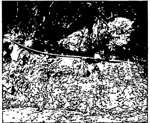
**Foto 1.5.** Tuberías en línea de conducción del Caserío EL Cerrillo sin enterrarlas en su totalidad y expuestas a los deslizamientos.
