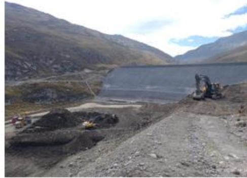
Conformación de talud y banqueta N°4 de la presa
