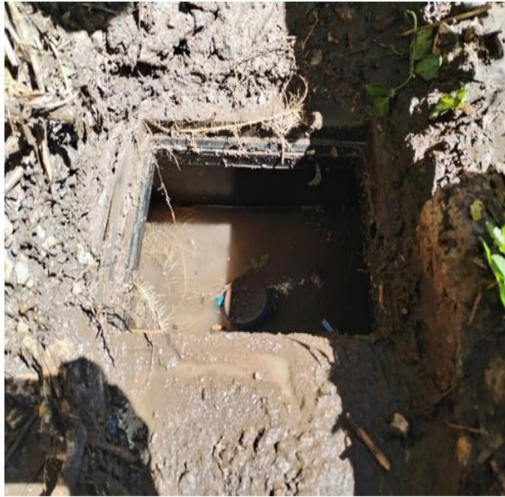
Cambio de color de agua por ruptura de tuberías
