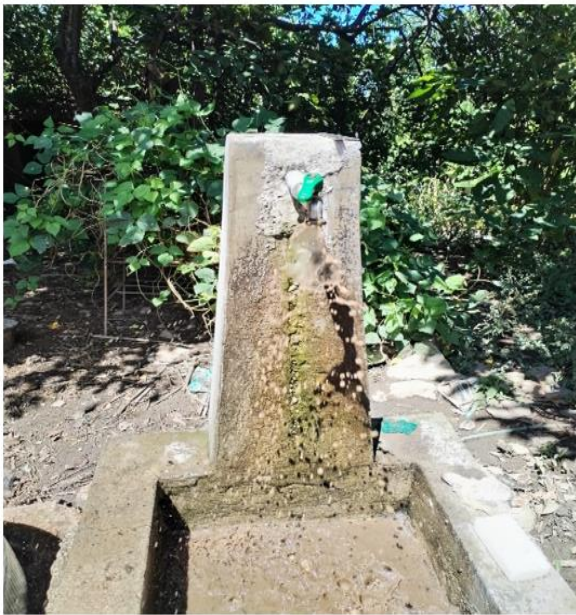
Cambio de color de agua por ruptura de tuberías
