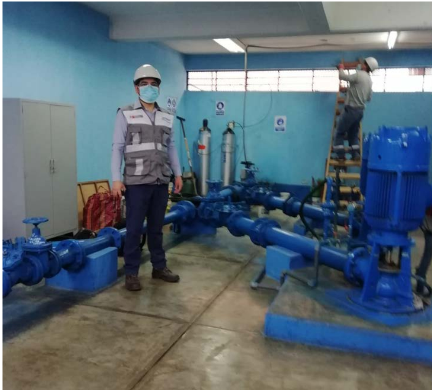
Figura 3 Panorámica del interior de la Cisterna CR-146
