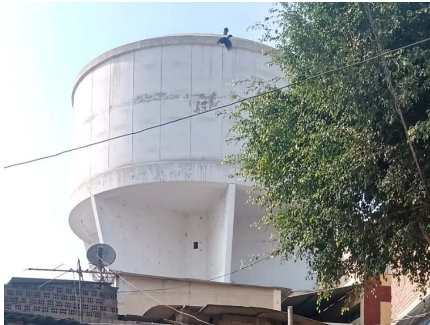
Figura 20 Ubicación de junta anular de construcción
