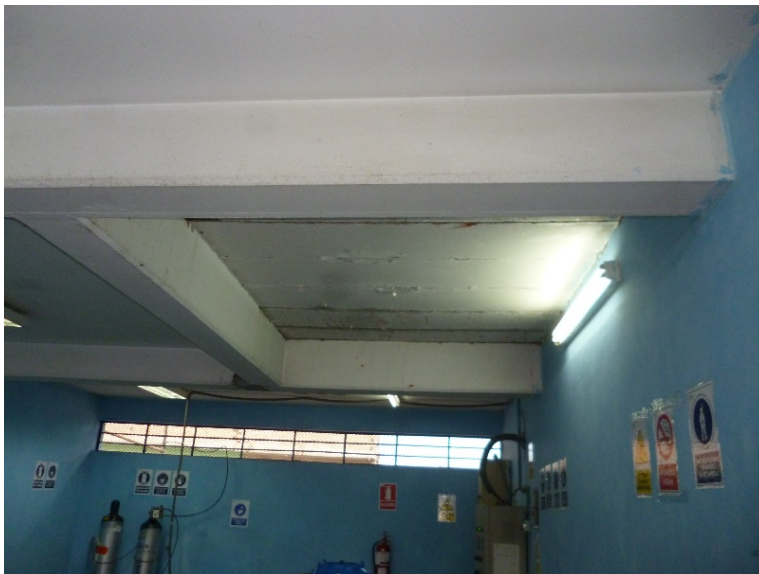
Figura 11 Techo de la Cisterna
