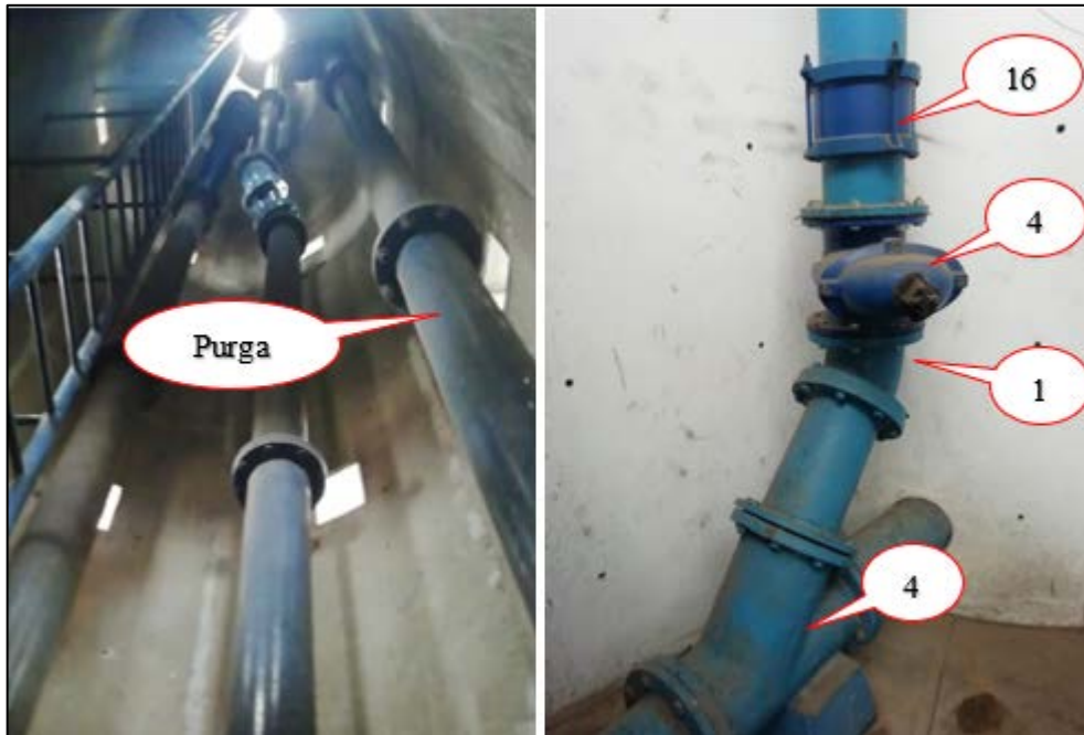
Figura 19 Accesorios de Línea de Limpia y Rebose
