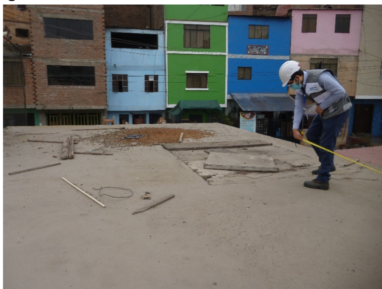
Figura 13 Exterior de la losa removible de la Cisterna
