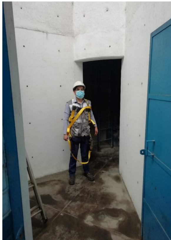
Figura 16 Vista del ingreso hacia la cuba del Reservorio Elevado R-401
