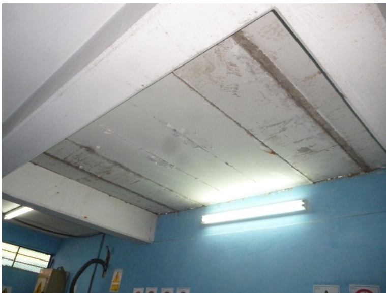
Figura 12 Losa removible de la caseta de válvulas
