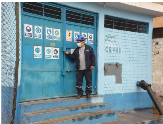
Figura 10 Exterior de la Cisterna, se muestra la parte frontal
