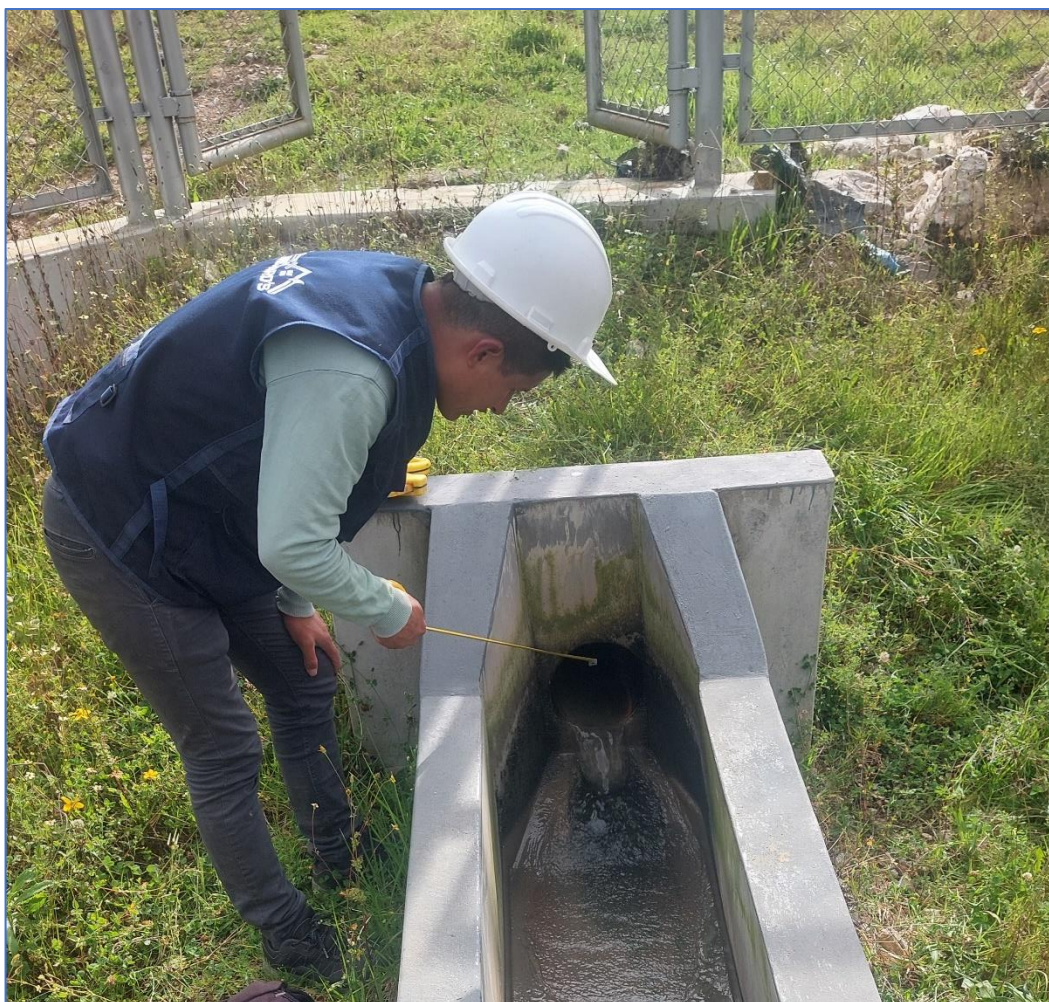
Figura 25. Llegada del afluente a la PTAR
