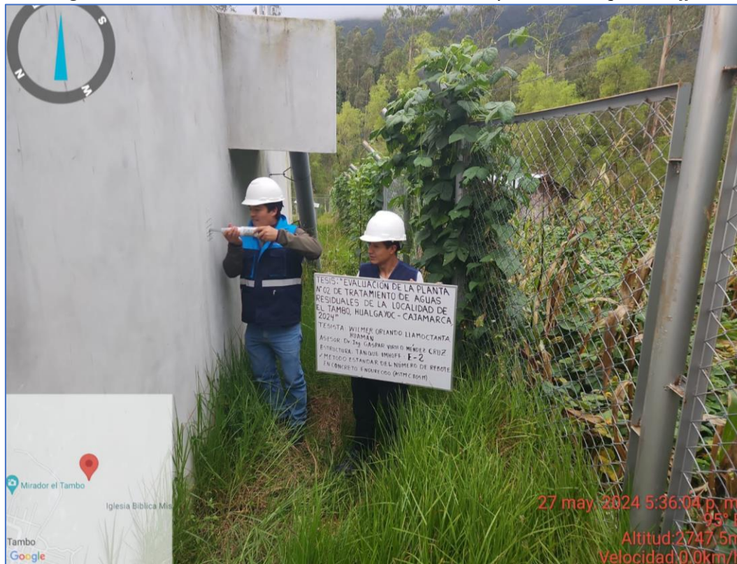
Figura 59. Uso horizontal del esclerómetro en el ensayo 02 del tanque Imhoff
