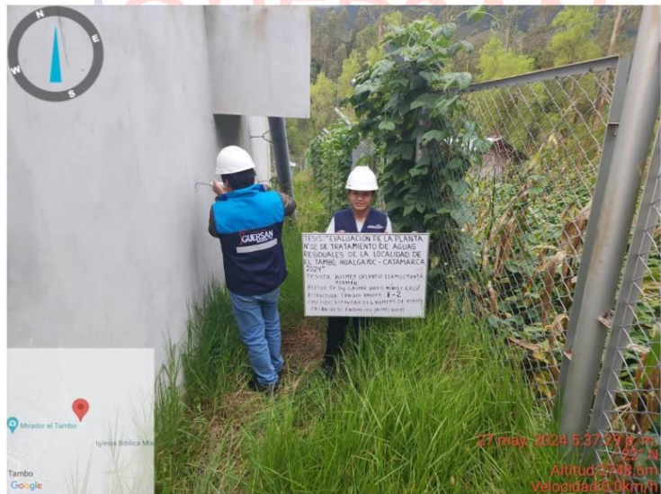
Fotografía N° 4 Ensayo E-2: TANQUE IMHOFF
