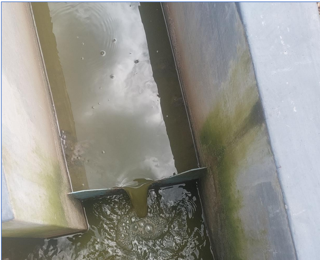
Figura 66. Tirante y ancho hidráulico en el vertedero triangular del desarenador
