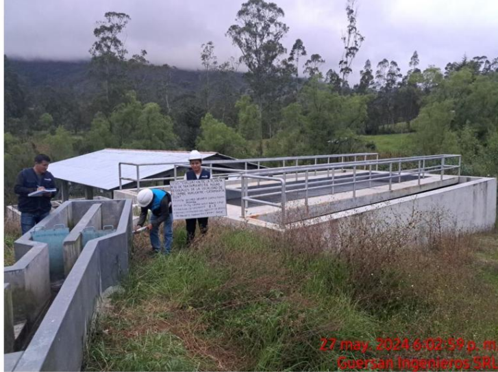
Fotografía N° 13 Ensayo E-7: DESARENADOR
