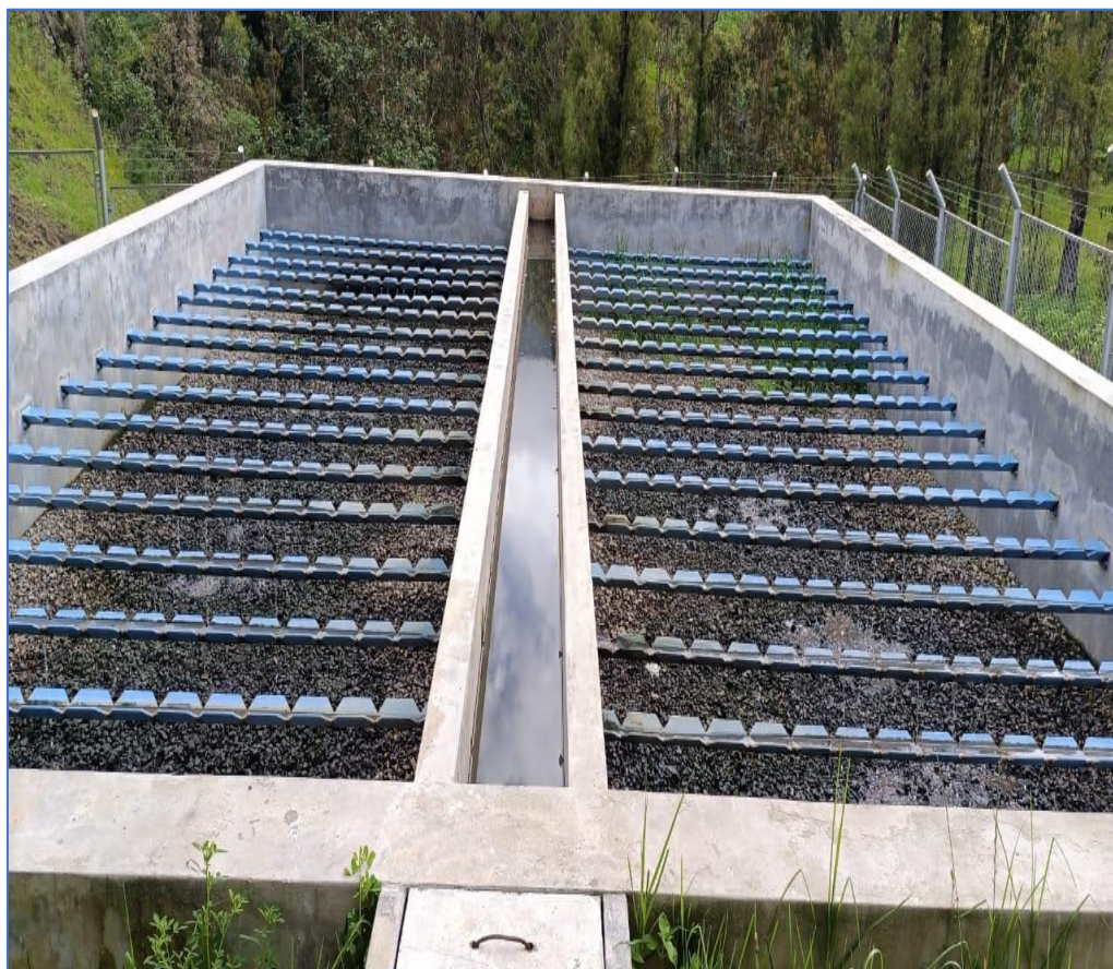
A22. Componentes del tratamiento secundario – Filtro biológico PTAR N°02 Tambo
