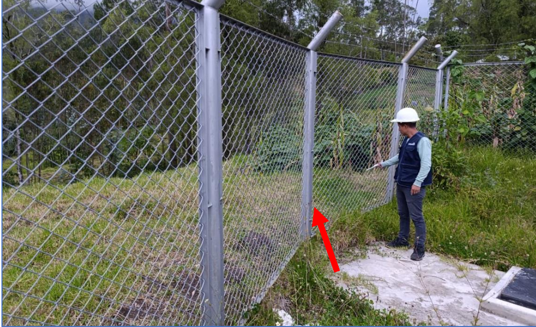
Figura 46. Salida del efluente de la unidad de cloración
