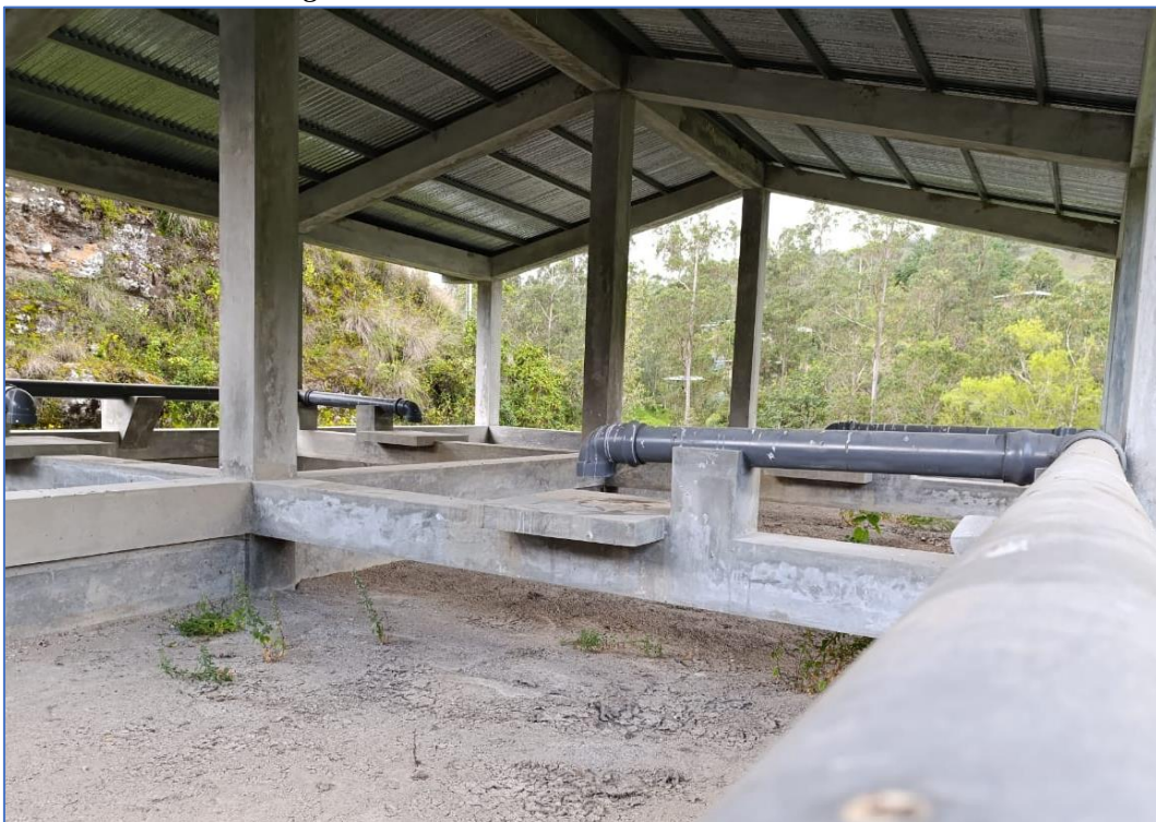
Figura 54. Cobertura del techo del lecho de secado
