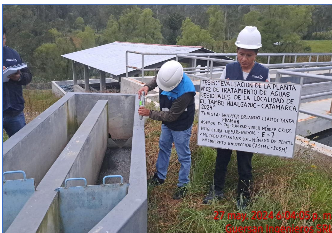
Figura 57. Uso vertical del esclerómetro en el desarenador
