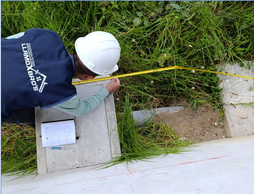
Figura 38. Cajas de control que llega el caudal del lecho de secado
