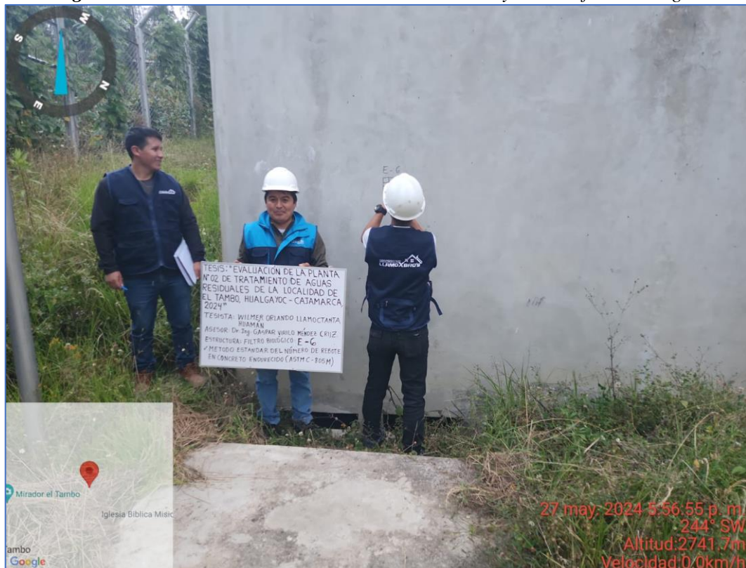
Figura 63. Uso horizontal del esclerómetro en el ensayo 02 del filtro biológico
