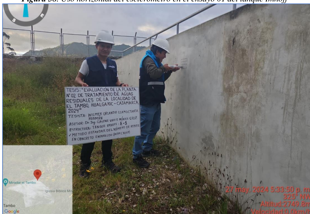
Figura 58. Uso horizontal del esclerómetro en el ensayo 01 del tanque Imhoff
