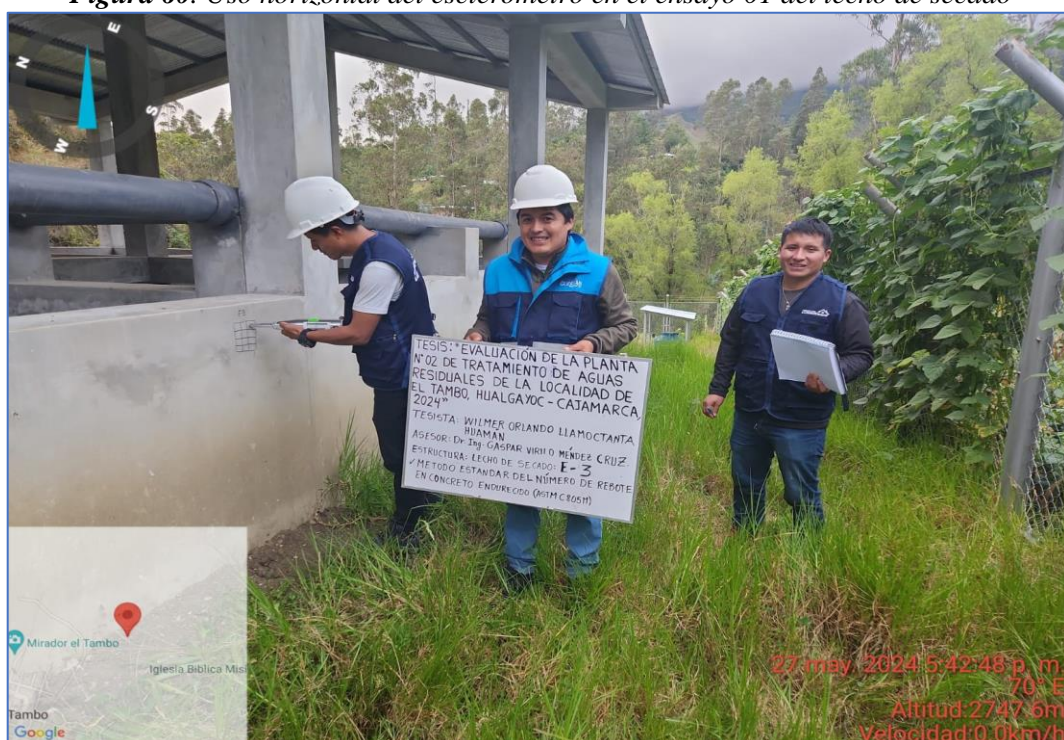
Figura 60. Uso horizontal del esclerómetro en el ensayo 01 del lecho de secado
