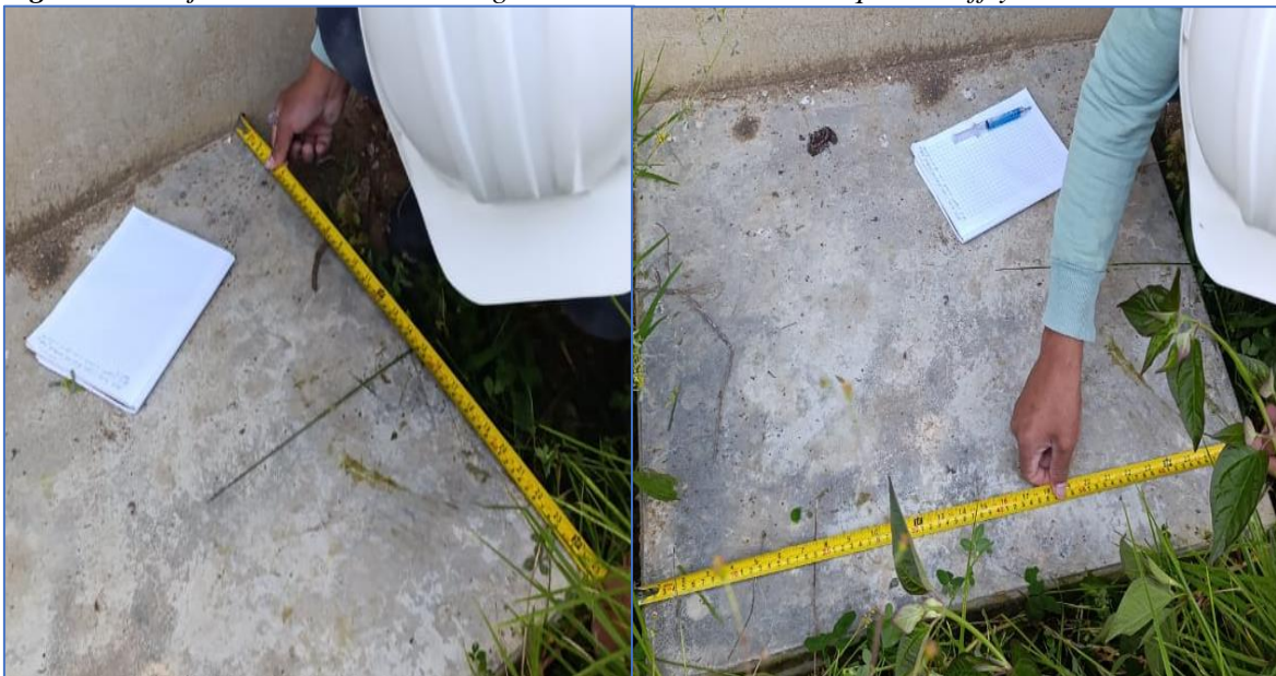
Figura 39. Cajas de control donde ingresan los caudales del tanque Imhoff y del lecho de secado
