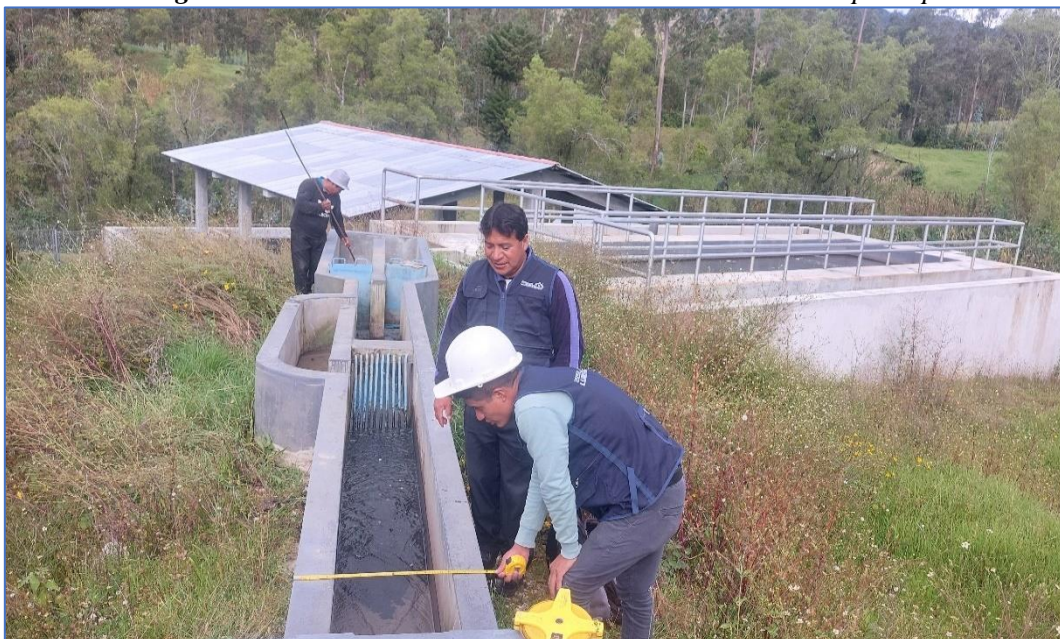
Figura 27. Dimensión del ancho del canal de alimentación principal
