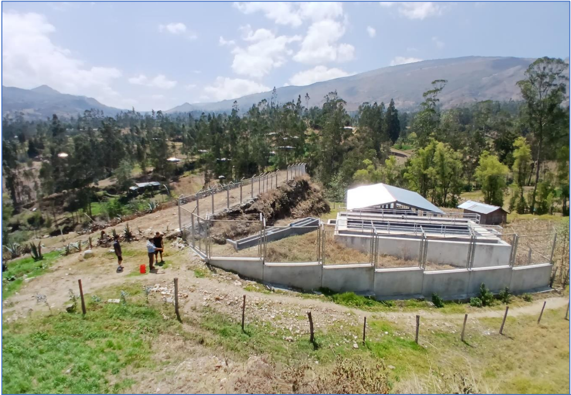
Figura 24. Ubicación de la PTAR N°02 El Portachuelo en la ciudad de El Tambo
