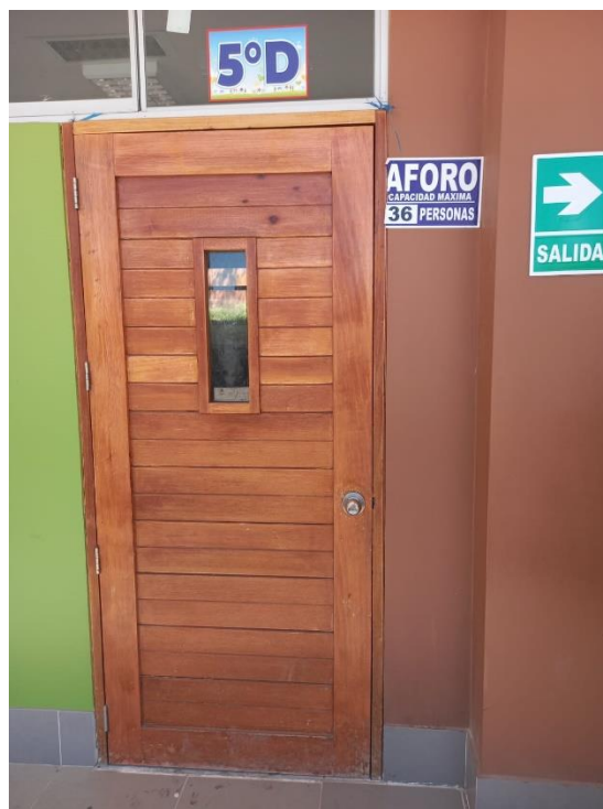
Figura 33. Las puertas de la IE Juan Ugaz cuenta con elementos que permiten visualizar el interior de los ambientes.
