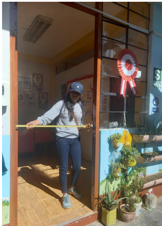
Figura 12. Medición del ancho del vano de las puertas de la IE N° 418.
