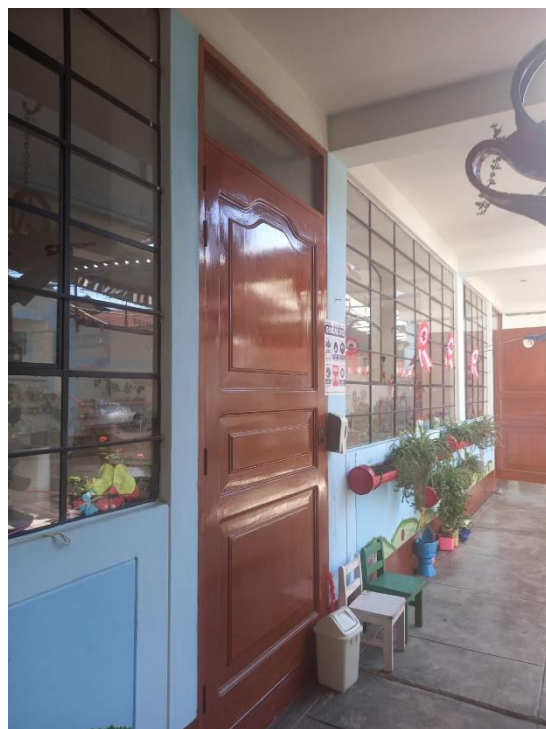
Figura 13. Las puertas de la IE N° 418 no cuentan con ningún elemento que permita visualizar el interior de los ambientes.
