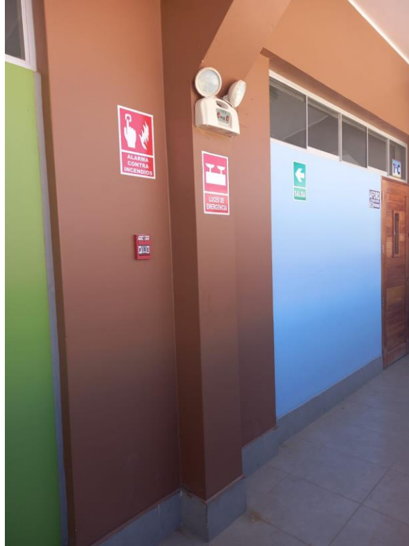
Figura 36. La IE Juan Ugaz esta implementada con carteles de seguridad.
