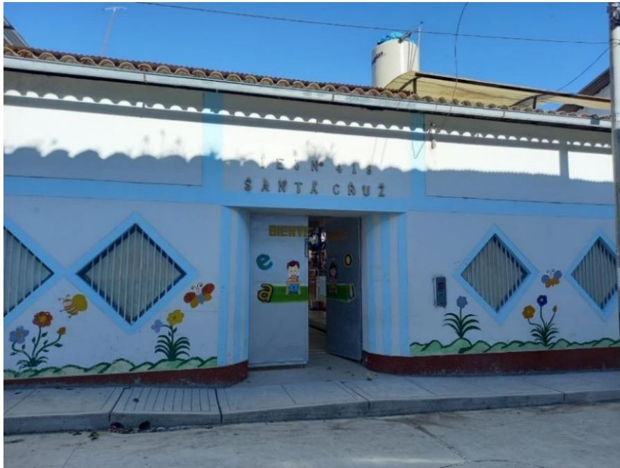
Figura 6. Fachada de la IE N° 518 del nivel inicial.
