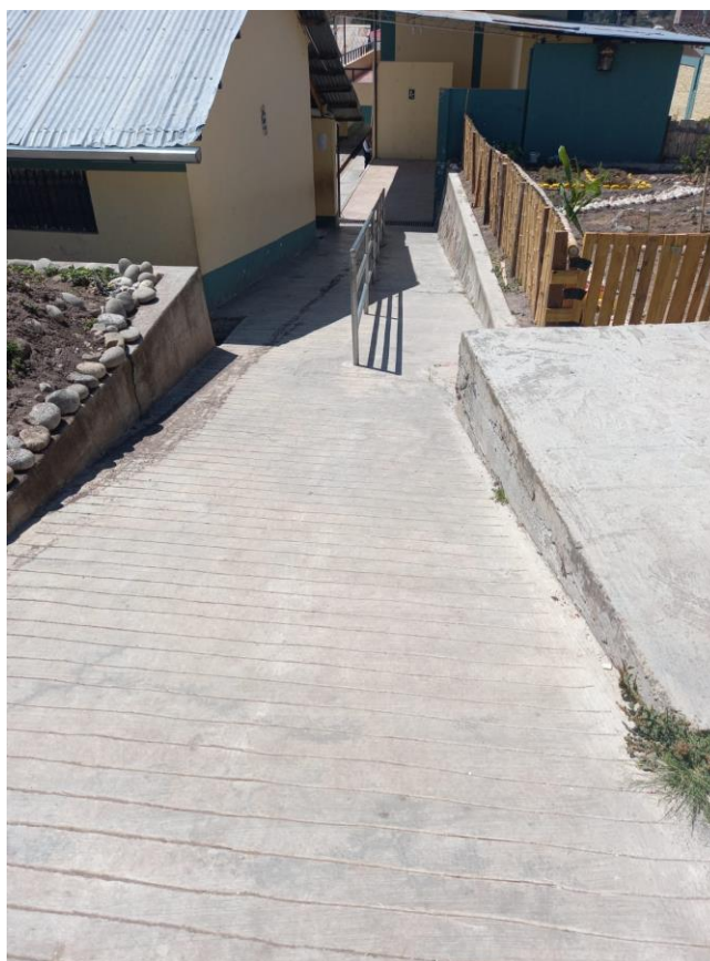
Figura 27. Las rampas de la IE N° 10603 superan la pendiente máxima permitida de 12%.
