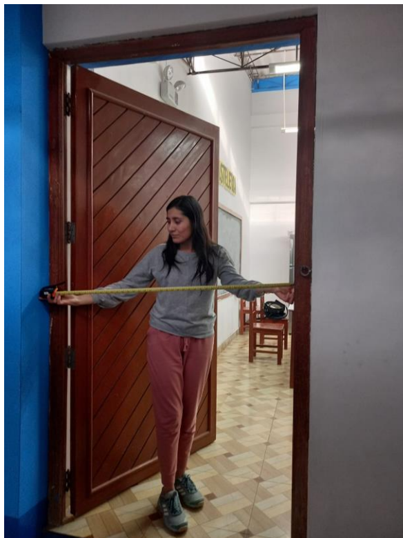
Figura 40. Las puertas del CETPRO no cuentan con ningún elemento que permita visualizar el interior de los ambientes.
