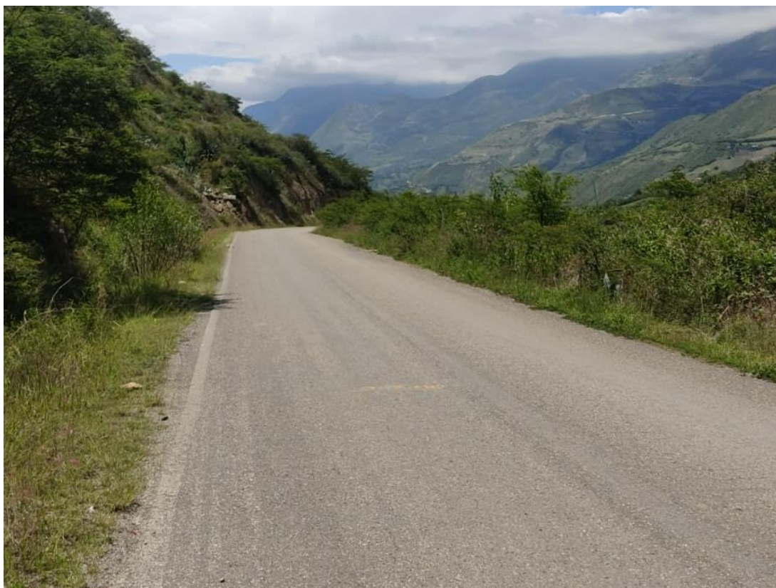
Fotografía N° 04: Tramo recto seguido de curva a la derecha.
