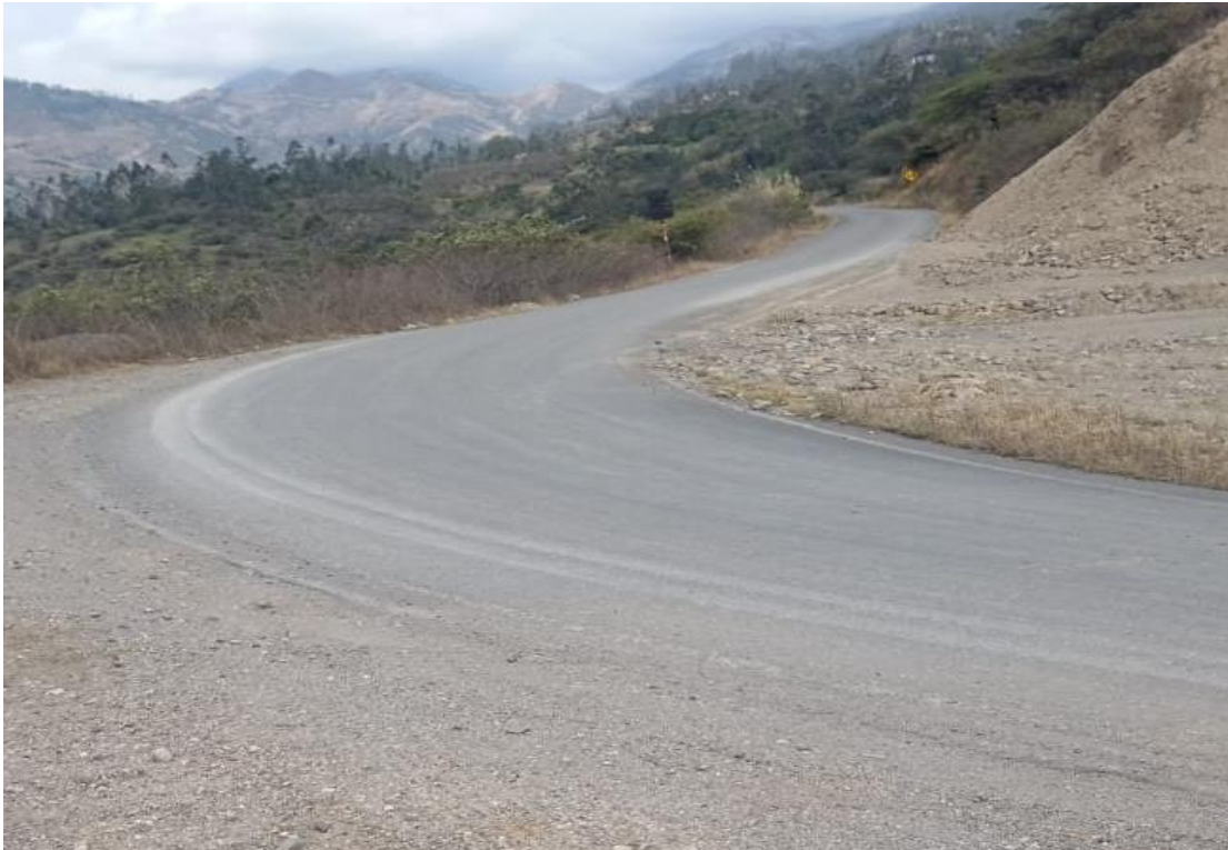
Fotografía N° 05: Curva y contracurva.
