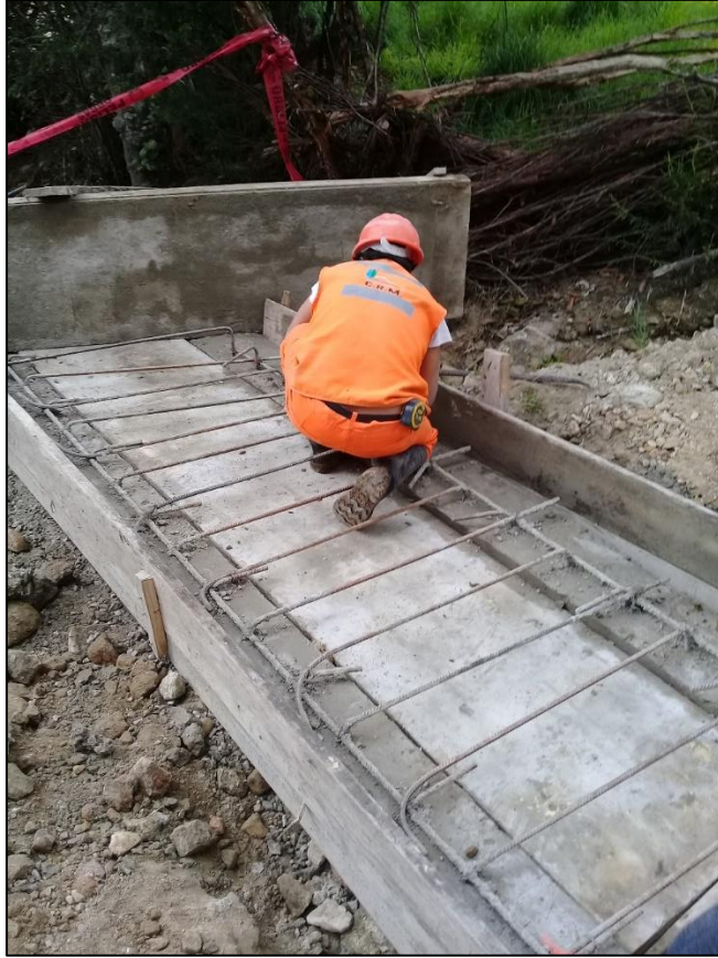
Fotografía N°23: Vista de trabajos de la partida de Concreto Simple en alcantarillas.
