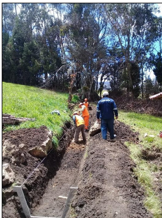
Fotografía N°07: Excavación de canal de material suelto
