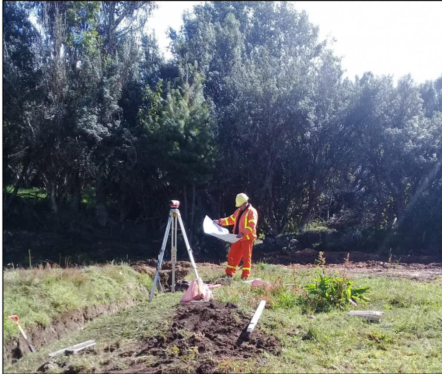
Fotografía N°05: Trazo, nivelación y replanteo de canales
