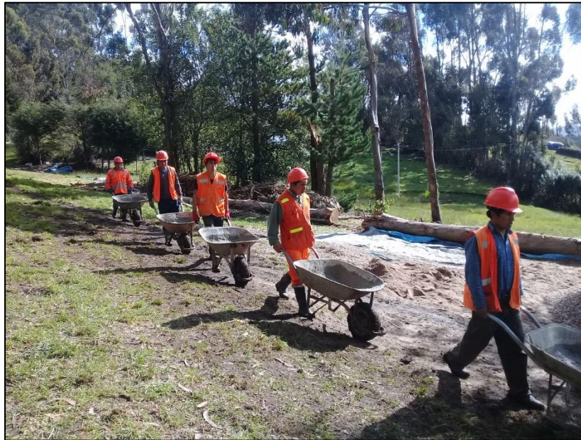
Fotografía N°24: Concreto f'c=140 kg/cm 2 en alcantarillas.
