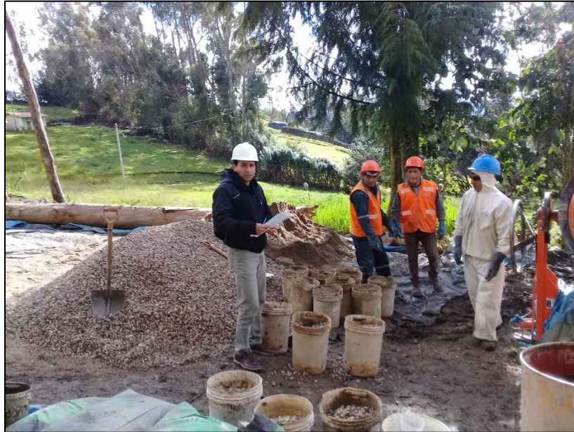
Fotografía N°25: Toma de datos con los formatos de Cartas Balance para la mano de obra en la partida de concreto f'c=140 \text{ kg/cm}^2
