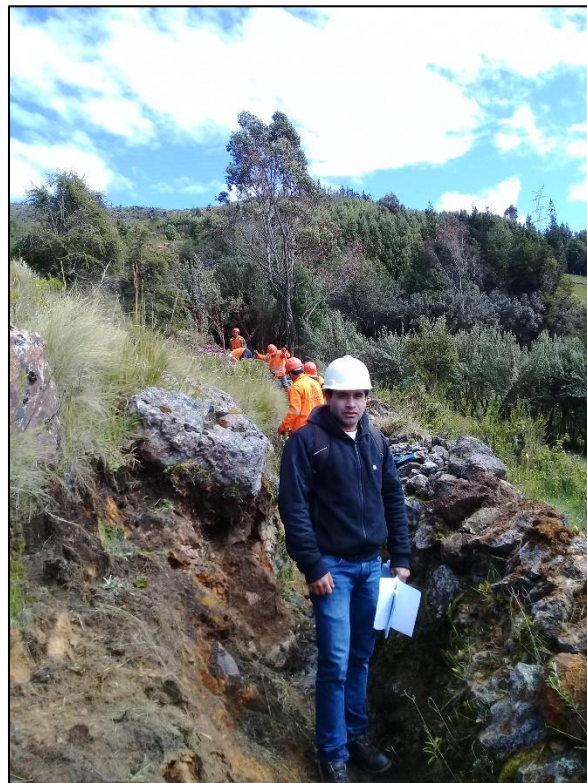
Fotografía N°04: Trazo, nivelación y replanteo de canales
