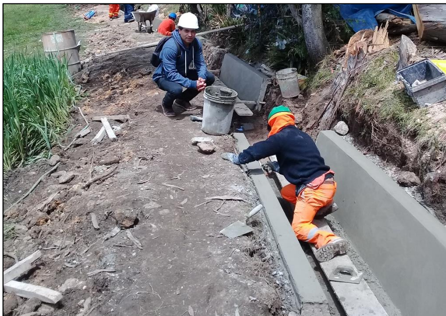
Fotografía N°18: Toma de datos con el formato de Cartas Balance de la partida de tarrajeo en muros de canal.
