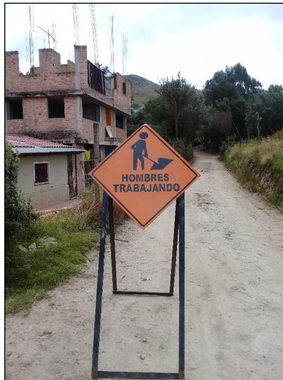
Fotografía N°02: Señalización de seguridad en obra.
