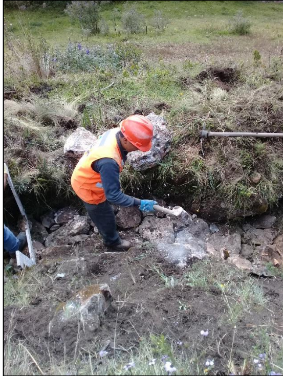
Fotografía N°09: Excavación de canal de material roca suelta
