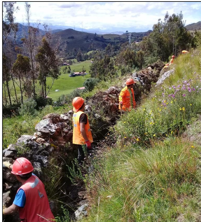
Fotografía N°06: Limpieza de terreno manual.
