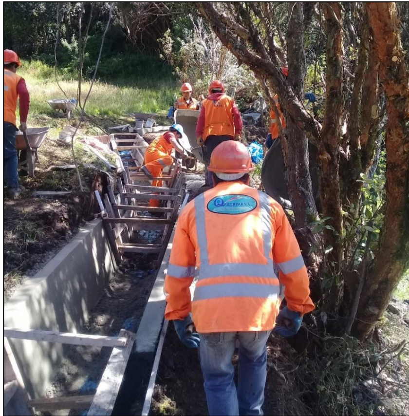
Fotografía N°17: Concreto f'c=140 kg/cm 2 en canales.
