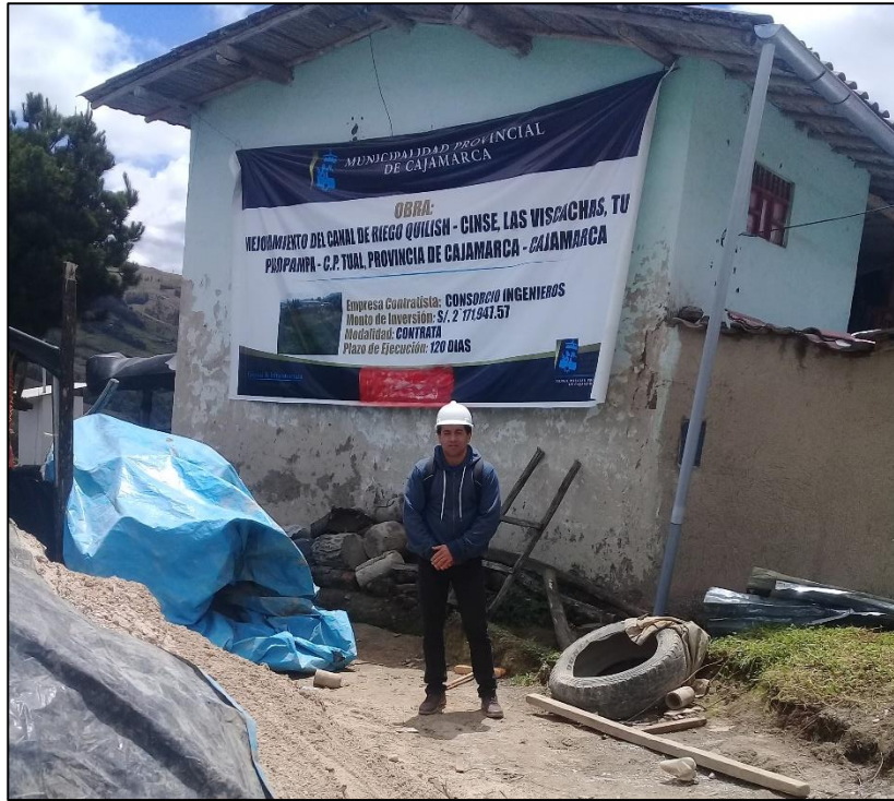
Fotografía N°01: Vista de cartel de obra en campo.
