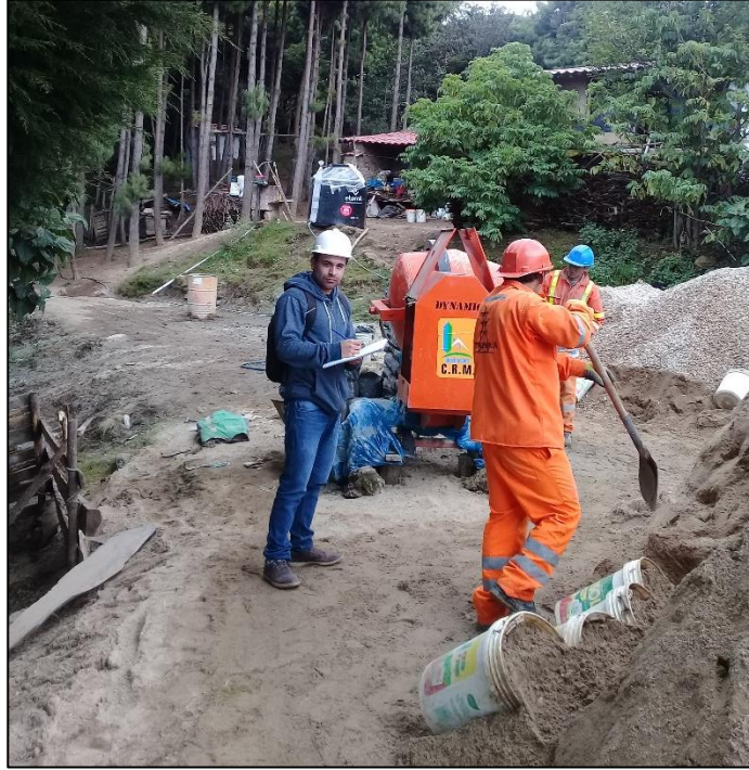
Fotografía N°15: Toma de datos con los formatos de Cartas Balance para la mano de obra en la partida de concreto f'c=140 \text{ kg/cm}^2
