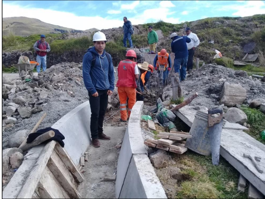
Fotografía N°21: Toma de datos con el formato de Cartas Balance de la partida de Movimiento de tierras de las partidas de alcantarillas.
