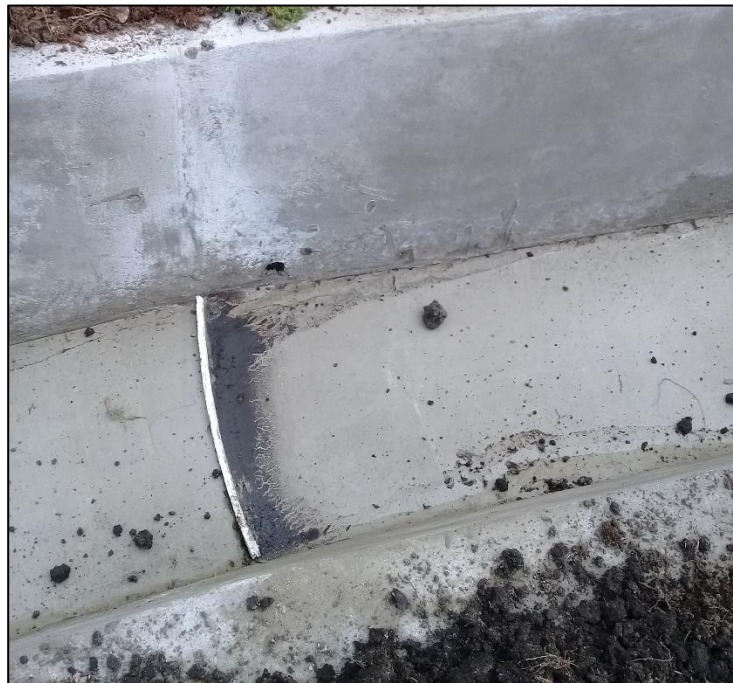
Fotografía N°20: Juntas de dilatación.
