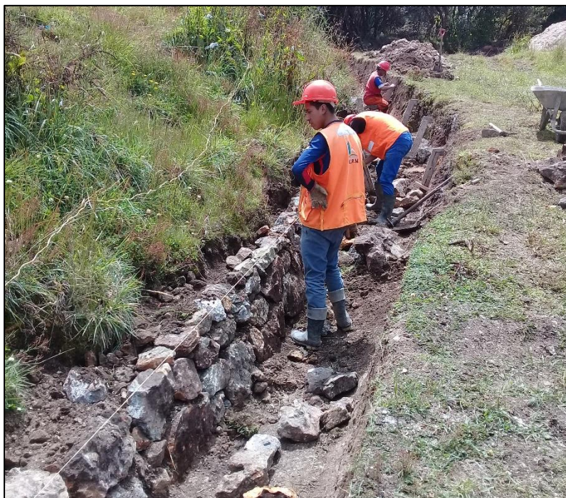
Fotografía N°13: Refine y nivelación de canal.
