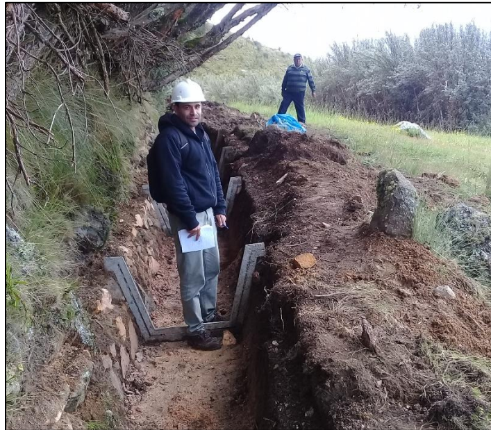
Fotografía N°12: Toma de datos con el formato de Cartas Balance de la partida refine y nivelación de canal.
