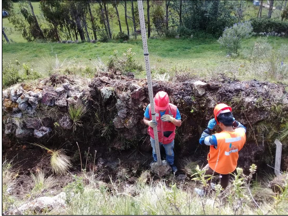
Fotografía N°03: Trazo, nivelación y replanteo de canales
