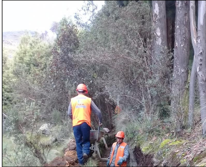
Fotografía N°11: Eliminación de material excedente
