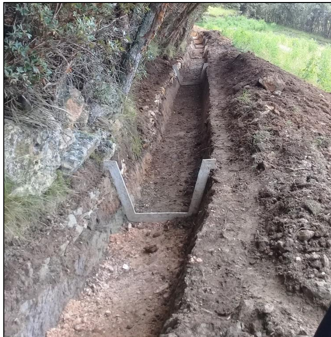
Fotografía N°10: Relleno compactado con material de préstamo
