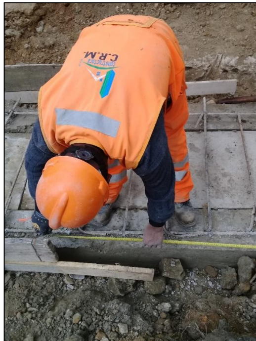
Fotografía N°22: Vista de trabajos de la partida de Concreto Simple en alcantarillas.
