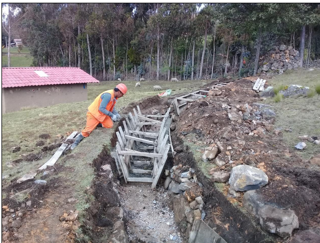
Fotografía N°14: Encofrado y desencofrado para muros de canal.
