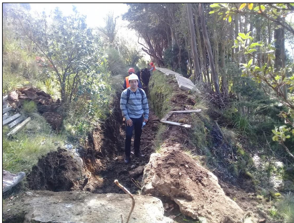
Fotografía N°08: Medición con el formato de Cartas Balance de la partida de excavación de canal de material suelto
