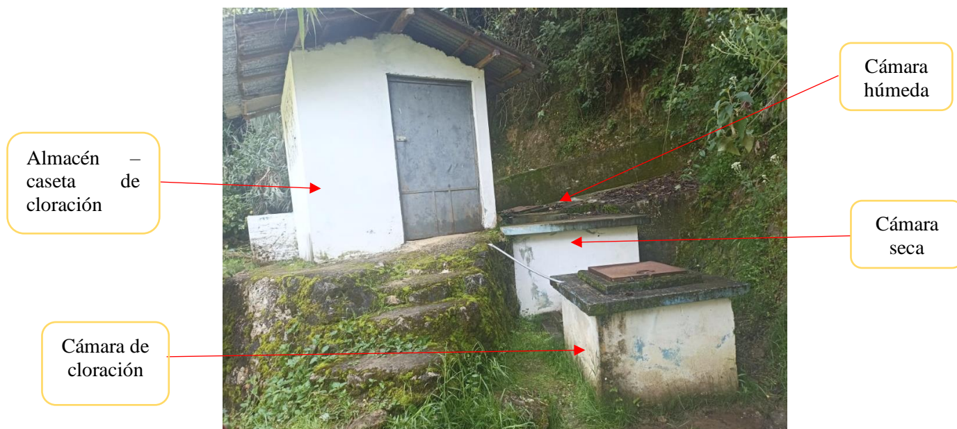
Captación de ladera La Pacchana
