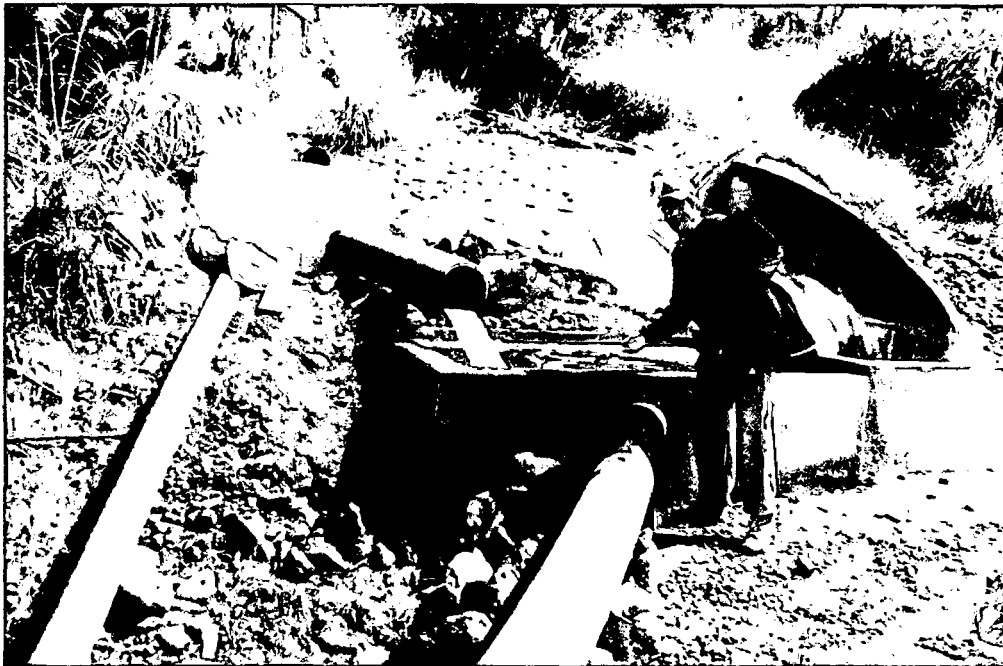
Fotografía 5 Conducción de Agua de los Depósitos de Desmonte 1 y 3 Mina SIPAN.
