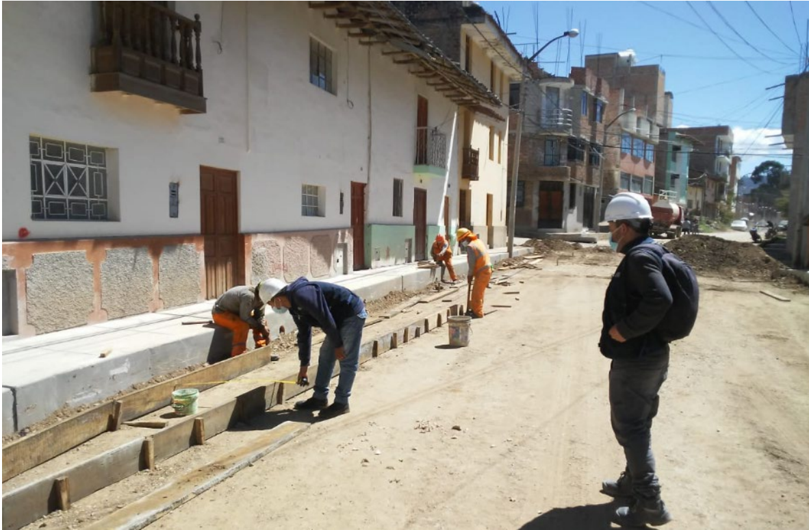
Imagen 09 – Encofrado para losa de concreto
