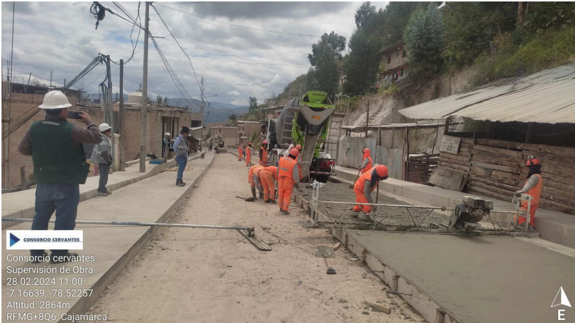
Imagen 07 – Vaciado de concreto en calzada
