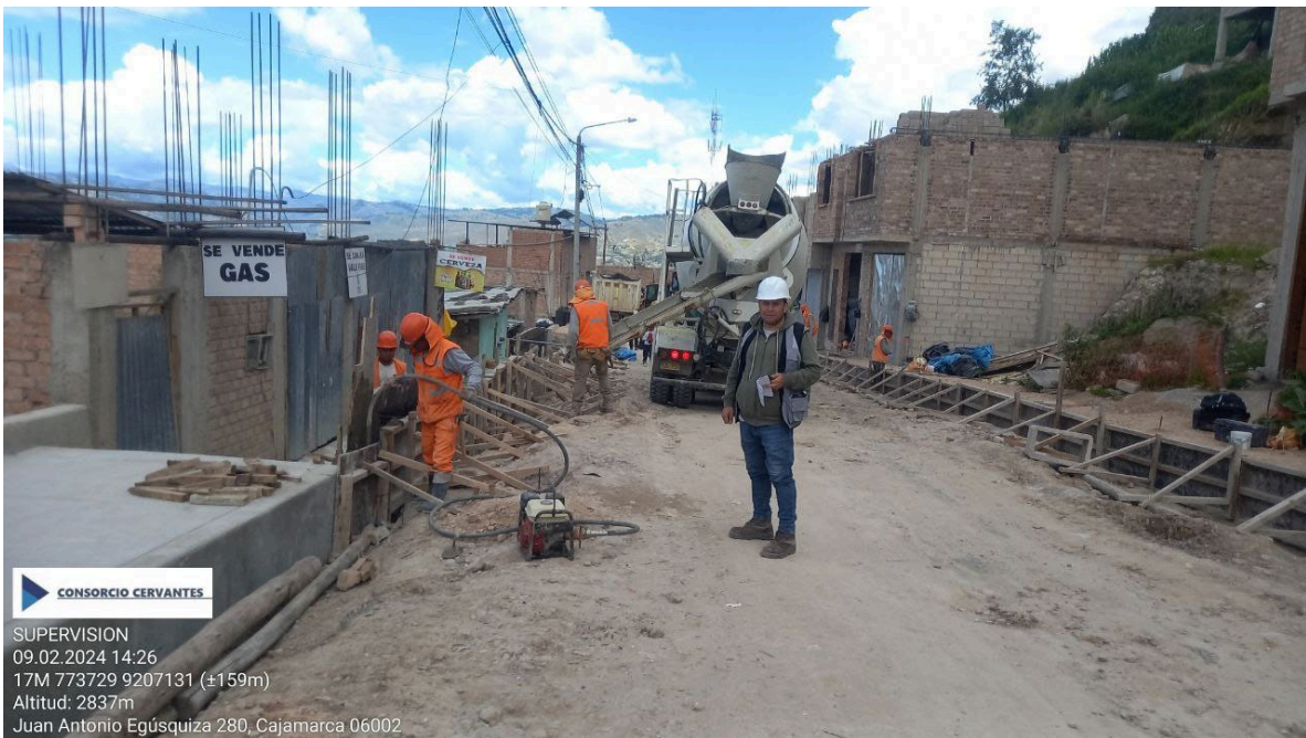
Imagen 02 – Vaciado de concreto en sardinel
