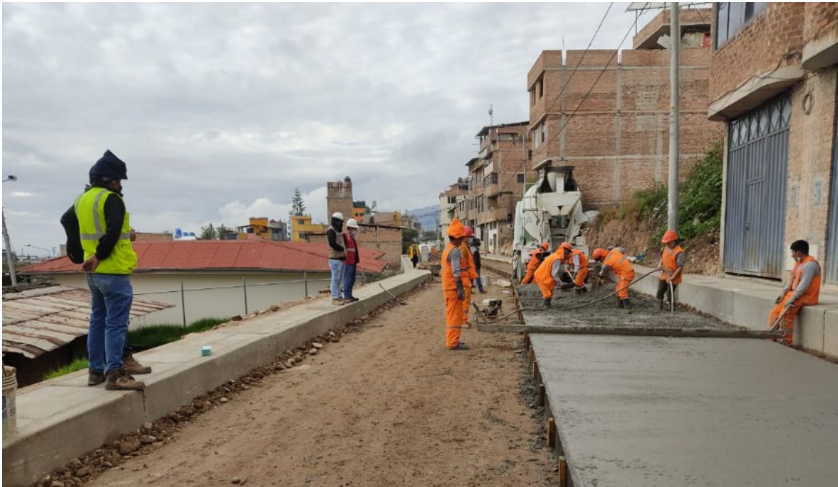
Imagen 10 – Vaciado de concreto en calzada
