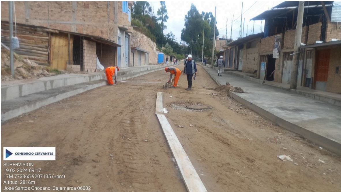
Imagen 03 – Encofrado para losa de concreto
