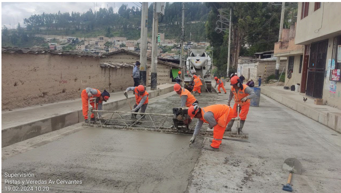
Imagen 06 – Vaciado de concreto en calzada
