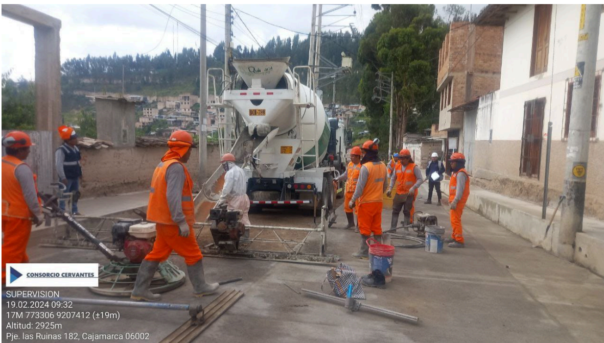
Imagen 04 – Vaciado de concreto en calzada
