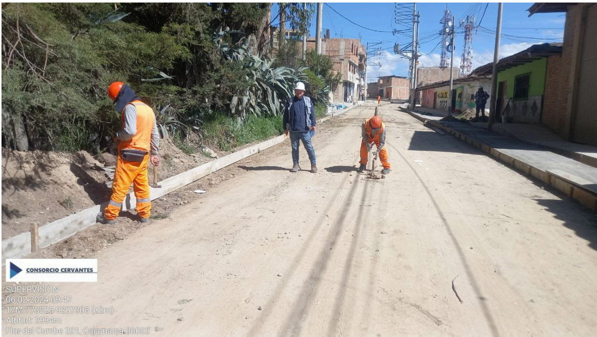
Imagen 01 - Encofrado para losa de concreto
