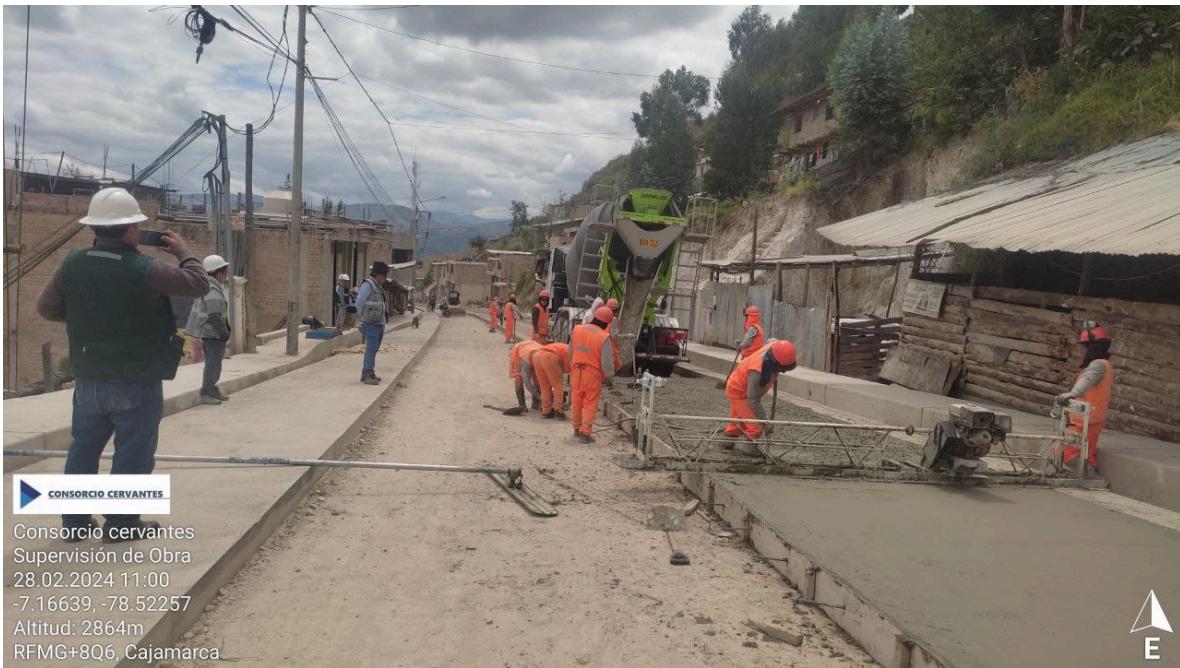
Imagen 05 – Vaciado de concreto en calzada
