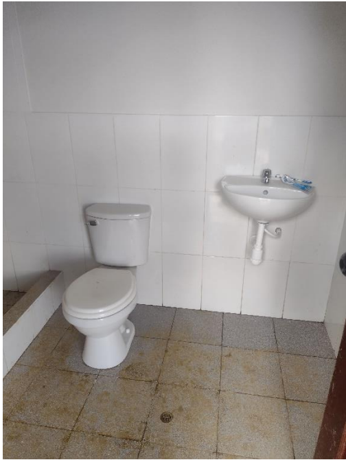
COLOCACION APARATOS SANITARIOS
