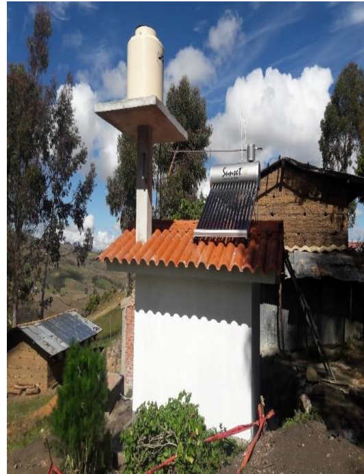
UBS EQUIPADO CON THERMA Y TANQUE ELEVADO
