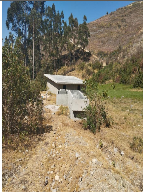
PLANTA TRATAMIENTO AGUA POTABLE
