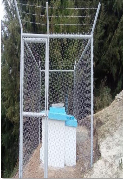
CERCO EN CRPT7-PEROLILLO
