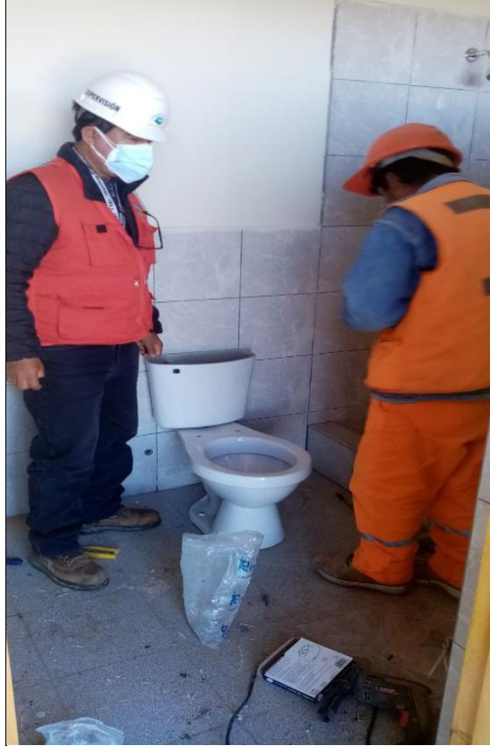
INSTALACIÓN APARATOS SANITARIOS
