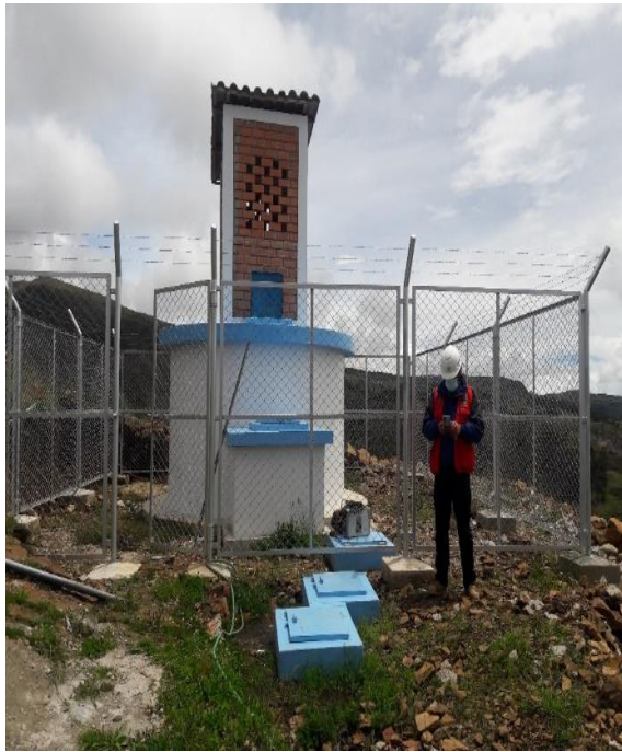
RESERVORIO CON CASETA DE CLORACIÓN
