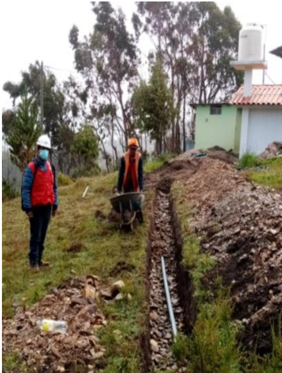
ZANJAS DE DRENAJE CON TUBERIA PERFORADA
