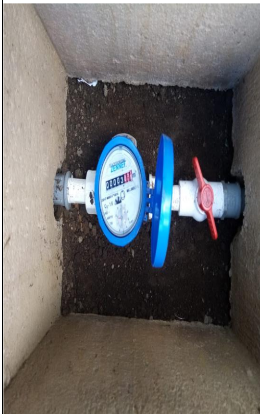
CONEXIÓN DOMICILIARIA DESMONTABLE
