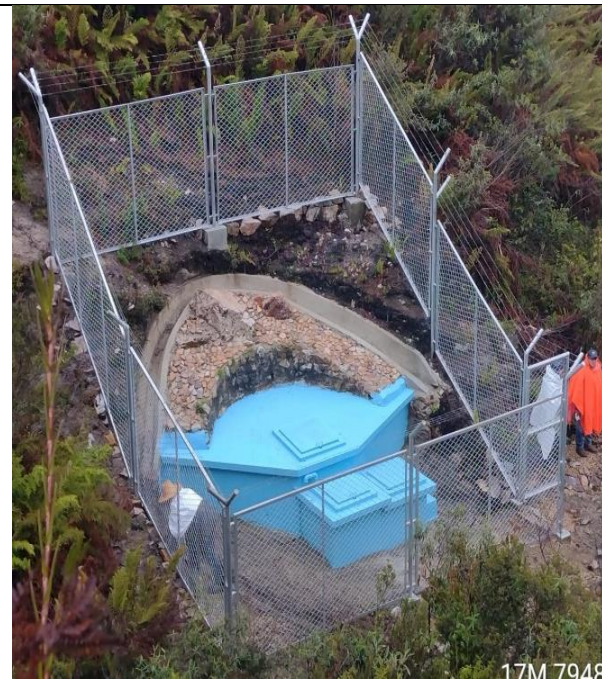
CAPTACIÓN Y CERCO PERIMÉTRICO
