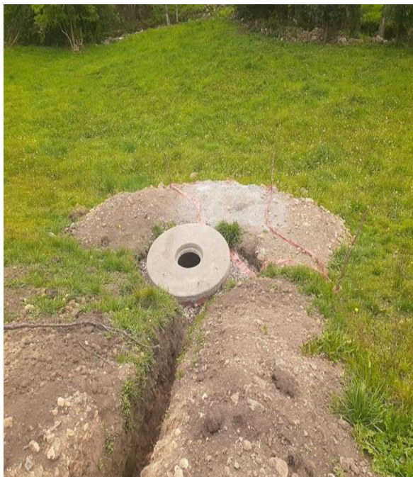
POZO PERCOLADOR TERMINADO
