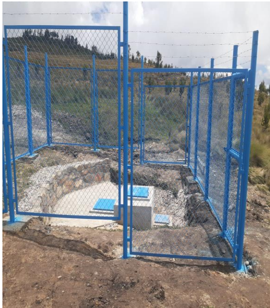
CERCO PERIMETRICO CAPTACIÓN
