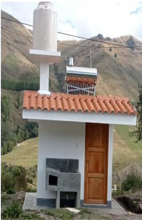
MODULO UBS TERMINADO
