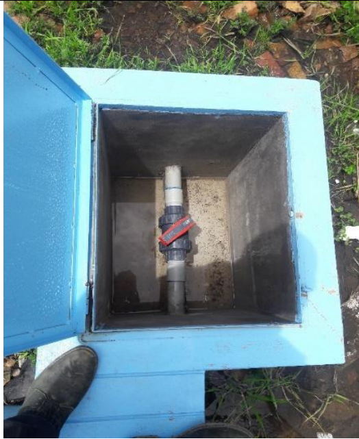
RESERVORIO CON CASETA DE CLORACIÓN
