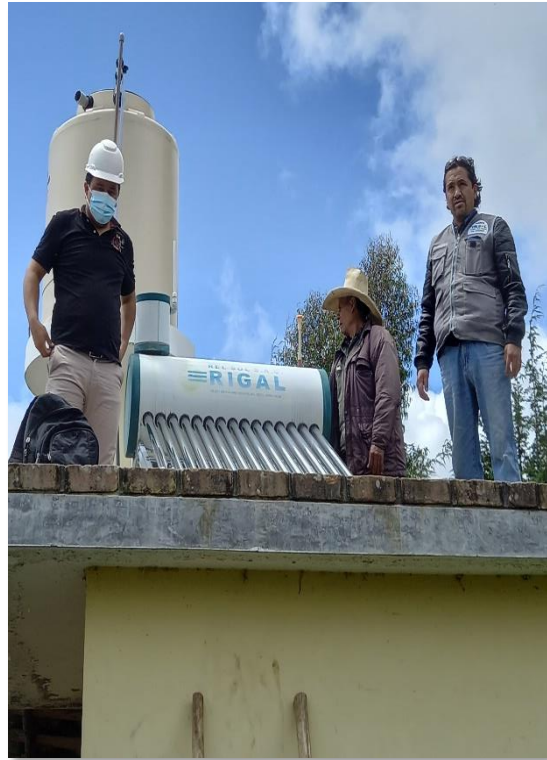
TANQUE Y TERMA SOLAR UBS
