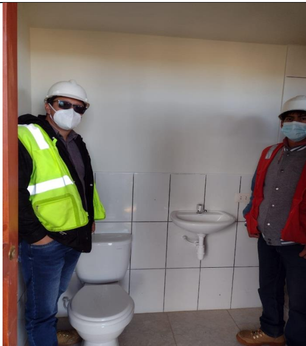
APARATOS SANITARIOS UBS
