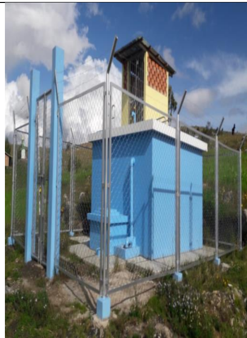
RESERVORIO CON CASETA DE CLORACIÓN
