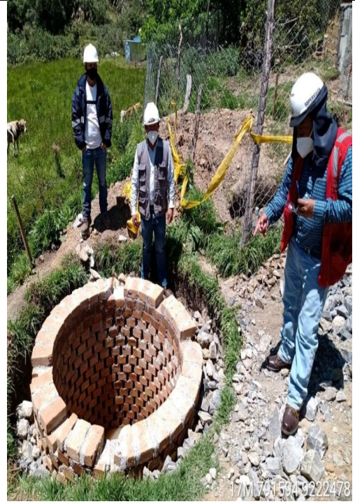
ESTRUCTURA POZO DE PERCOLACIÓN
