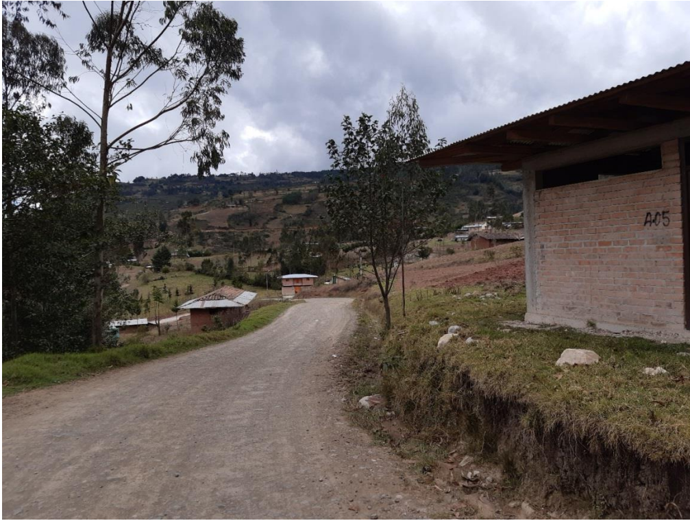
Fotografía 13. Ancho irregular de calzadas y bermas en tramos en tangente.
