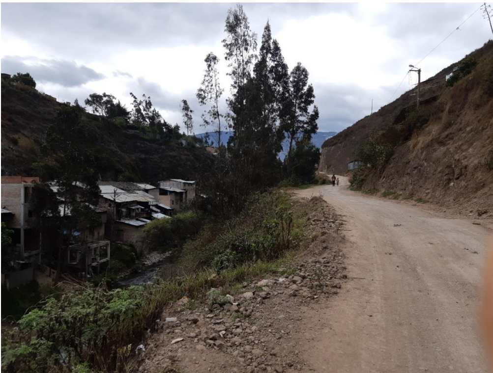
Fotografía 2. Vista de la sección de calzada km 0+300.
