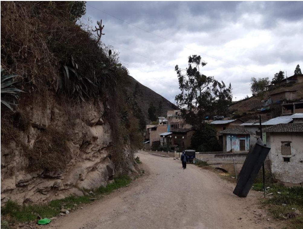
Fotografía 1. Inicio de tramo en estudio y estación de conteo vehicular- Puente Corellama.
