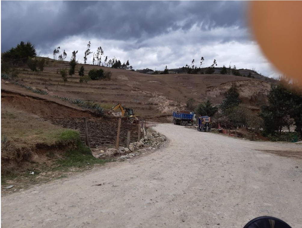
Fotografía 9. Vista de un camión C3 circulando por la vía en estudio.
