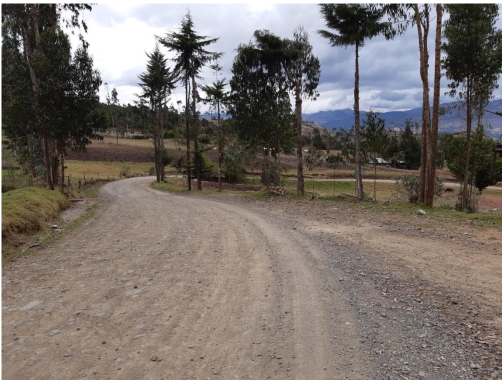
Fotografía 12. Sobre ancho en curvas horizontales.
