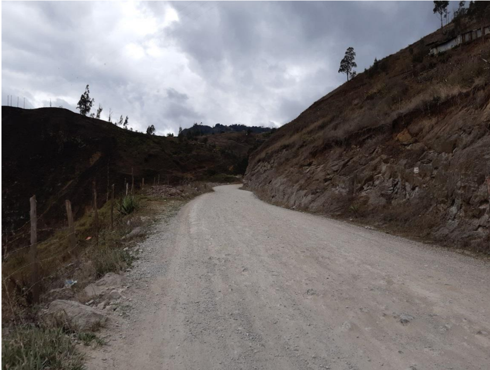
Fotografía 3. Vista de la sección de calzada y bermas km 0+800.
