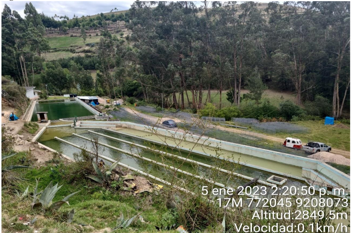
Figura 11: Planta de Tratamiento de Agua Potable El Ronquillo
