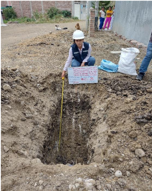
Fotografía 03: Ejecución de la calicata 03, al lado izquierdo de la Av. Inmaculada, a 1.50m de profundidad.
