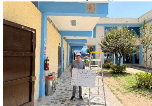
Fotografía N°10 Punto de ensayo - Viga
