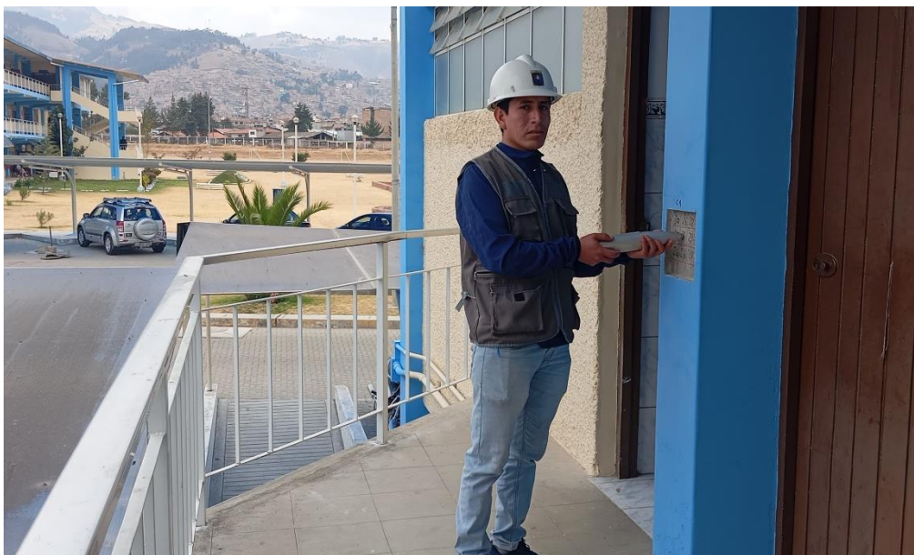
Fotografía N° 10: Realizando el ensayo de esclerometría en una de las columnas del segundo nivel.
