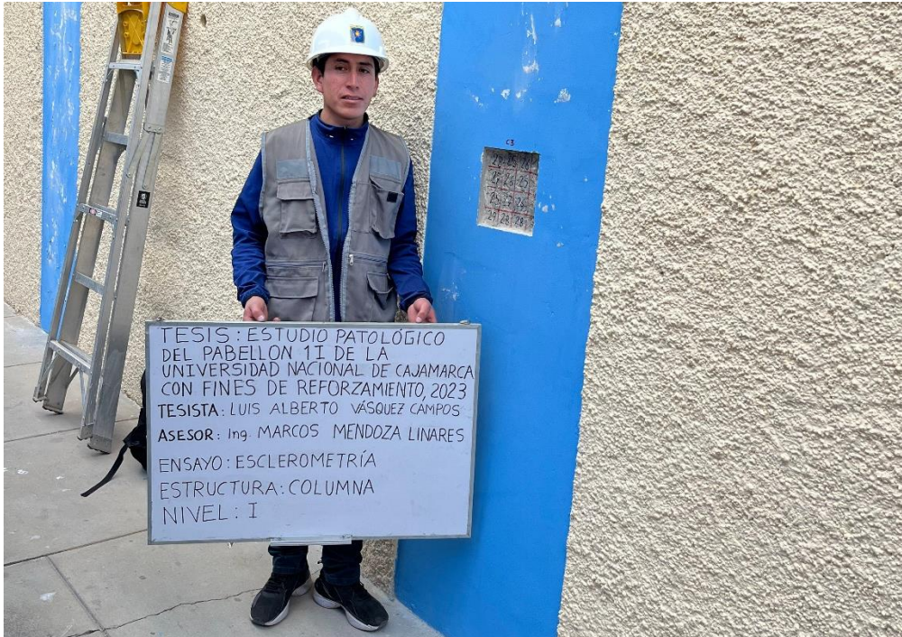
Fotografía N° 13: Ensayo de esclerometría en columna C3 del primer nivel
