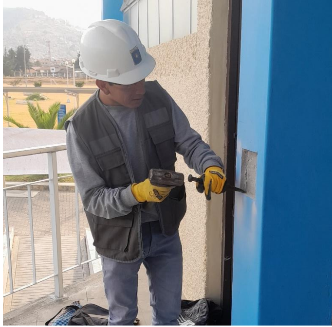
Fotografía N° 7: Uso de herramientas manuales para quitar el recubrimiento de uno de los elementos estructurales (columna).
