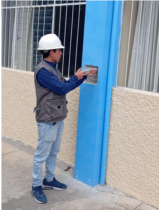
Fotografía N° 9: Realizando el ensayo de esclerometría en una de las columnas del primer nivel.
