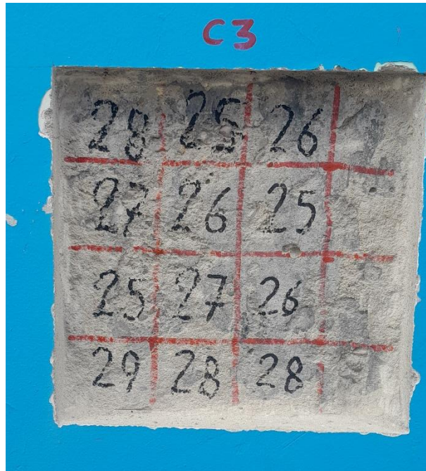
Fotografía N° 11: Resultados de los rebotes obtenidos en el ensayo de esclerometría en una de las columnas del primer nivel.
