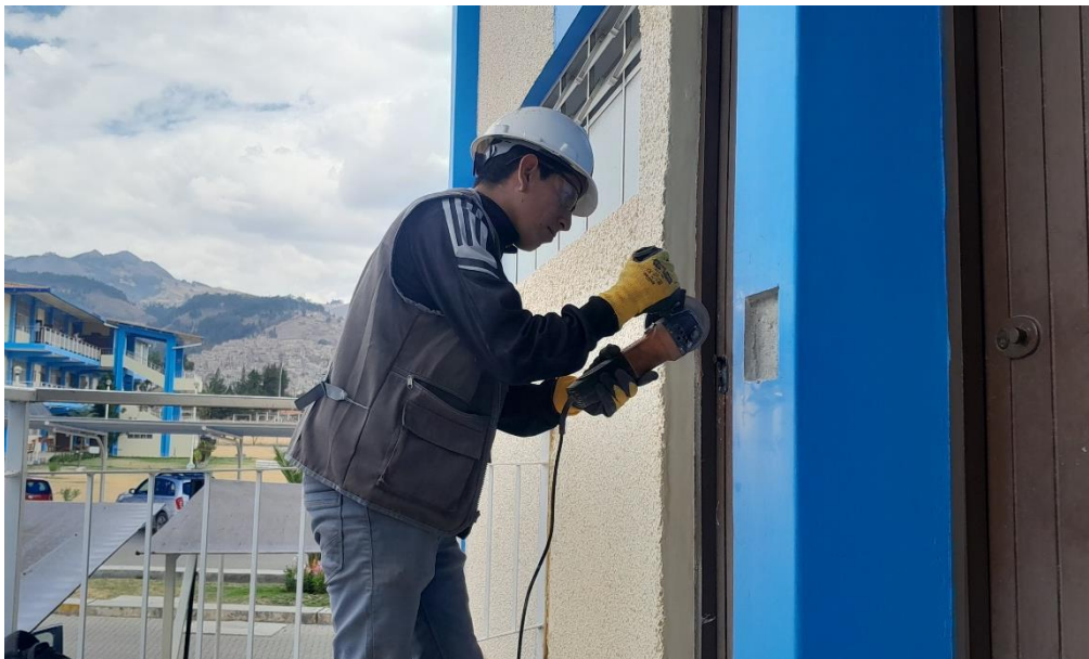
Fotografía N° 6: Retirando el recubrimiento de uno de los elementos estructurales (columna).
