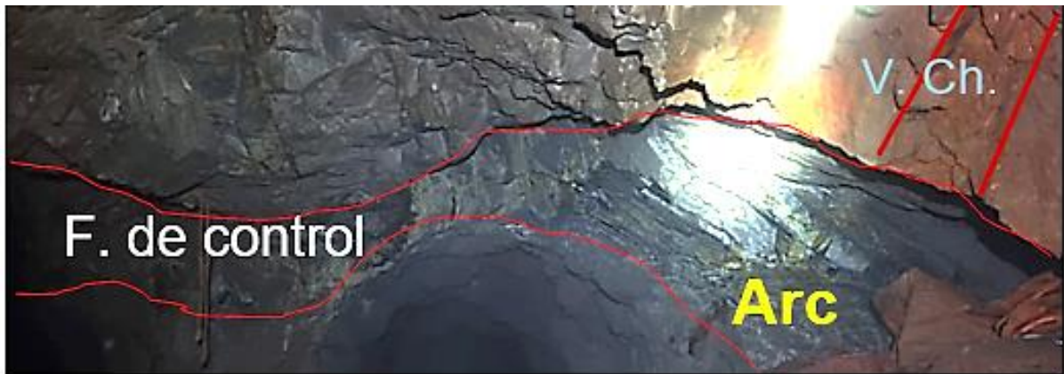
Foto N°5: Falla Dominga, controla la veta chibola esta presenta una dirección NW-SE con buzamiento de 55°SW
