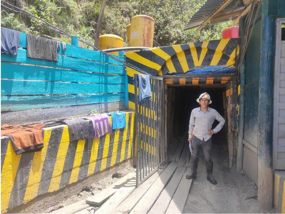
Figura 41. Bocamina del Nivel 4 – Mina Gutu.
