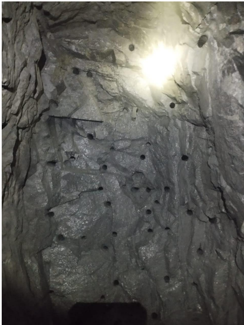
Figura 31. Malla actual de perforación y voladura
