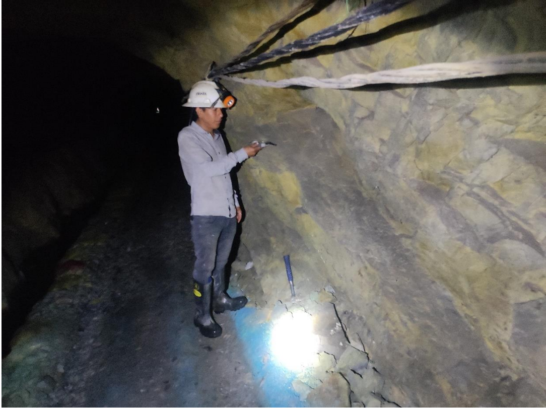
Figura 43. Medición de rumbo y buzamiento.
