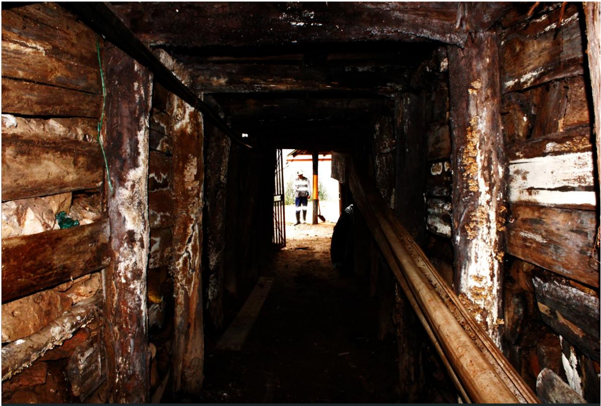
5. Cuadros de madera cerca al sector de la bocamina de la Mina Trinidad
