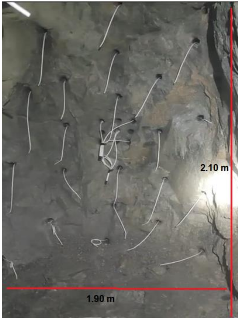
10. Aplicando la nueva malla de perforación, taladros ya cargados.
