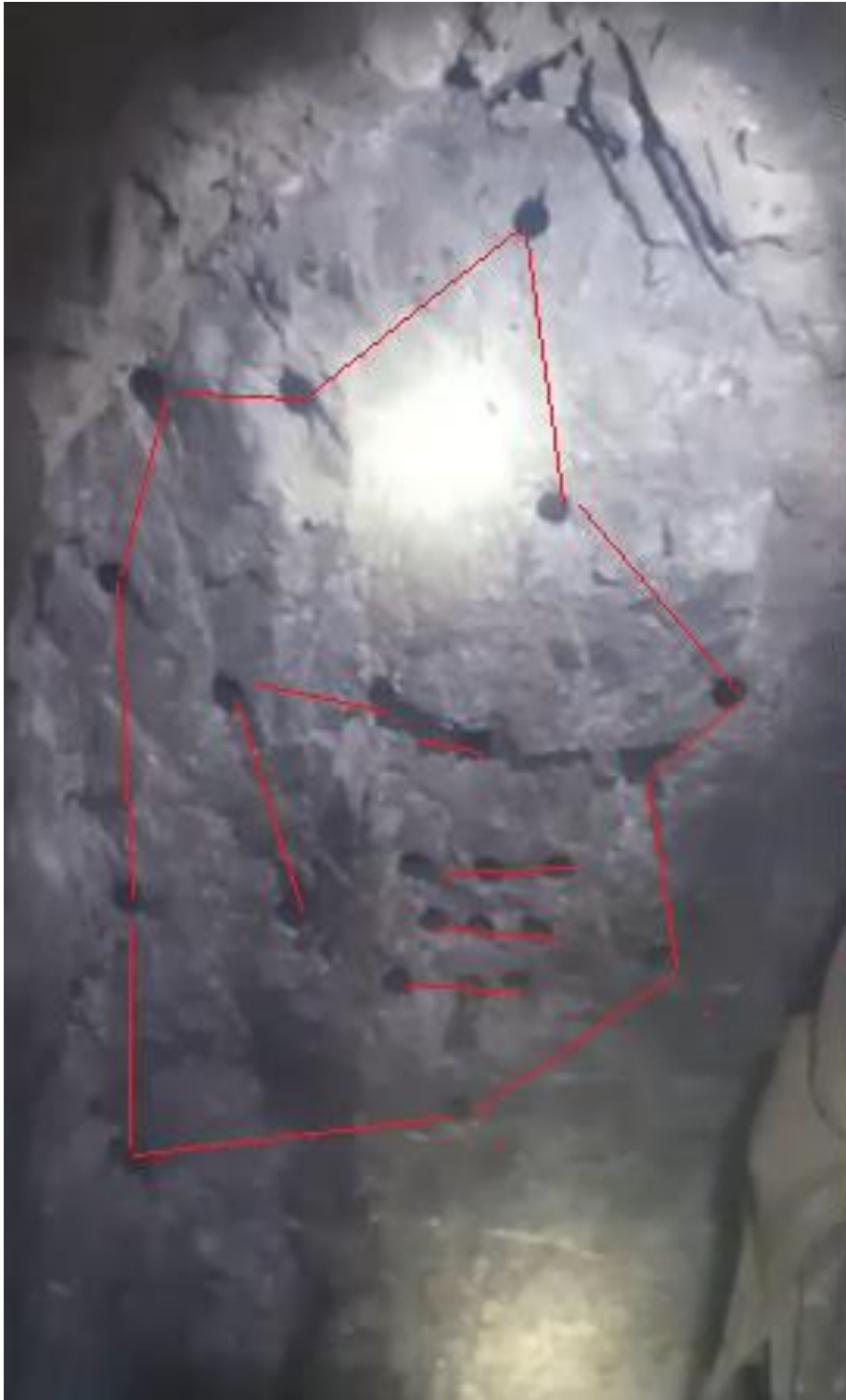
7. Malla de perforación en forma artesanal.
