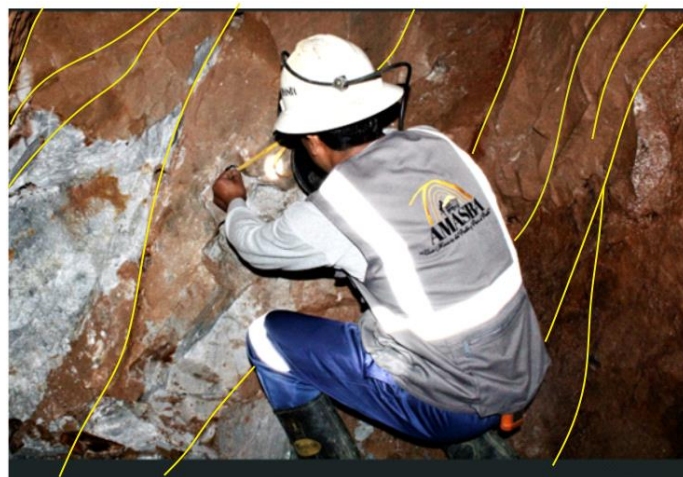
Figura 10 Las fracturas determinadas en la Estacion EGP- 01. Estas fracturas estan orientadas en una sola direccion. Foto tomada en el frente de avance en la Galeria N°3 de la mina Trinidad II.
