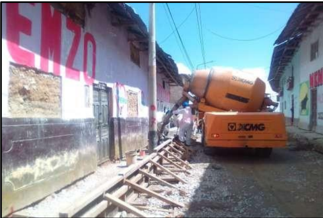
Figura 36: Vaciado de concreto f'c=175 \text{ kg/cm}^2 en vereda, e=0.10\text{m} , con
