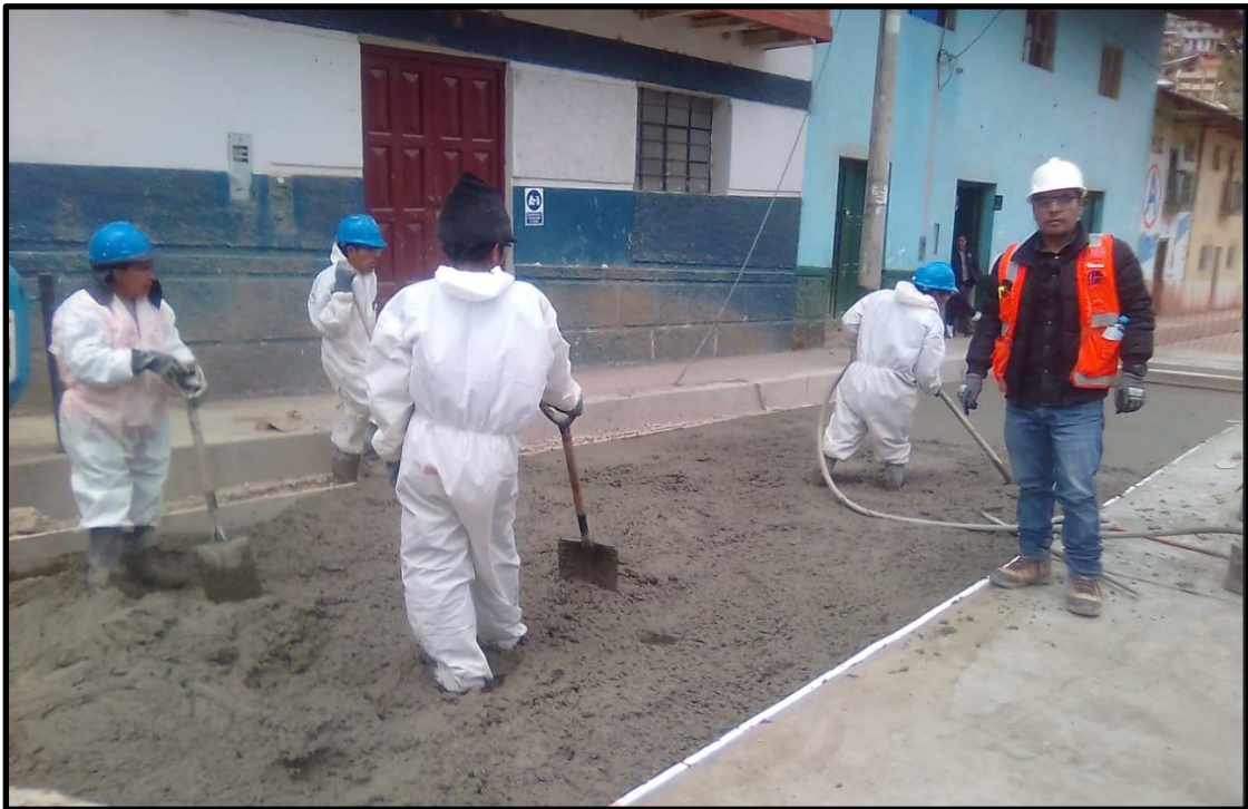
Figura 32: Actividad pavimentación de concreto f'_c=175\text{kg/cm}^2 , e=0.20\text{m}
