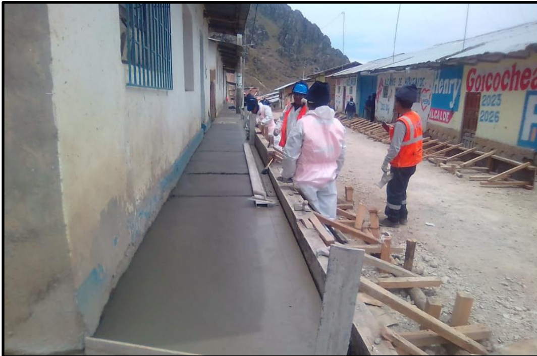
Figura 38: Actividad concreto f'c=175\text{kg/cm}^2 en cuneta de pavimento rígido
