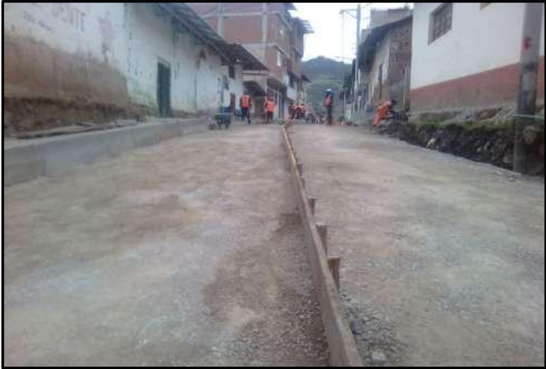
Figura 32: Actividad pavimentación de concreto f'_c=175\text{kg/cm}^2 , e=0.20\text{m}
