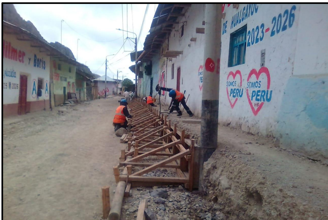
Figura 34: Se observa la actividad de vereda- encofrado
