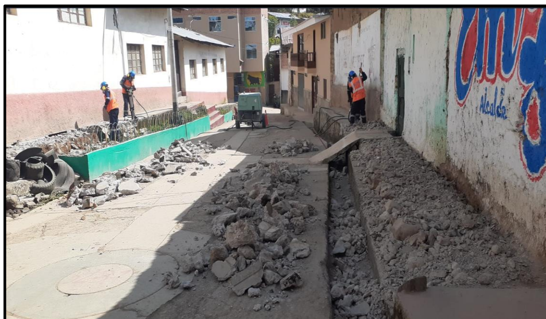
Figura 30: Se puede observar actividad demolición de veredas de concreto 02 operador equipo liviano+02 peones
