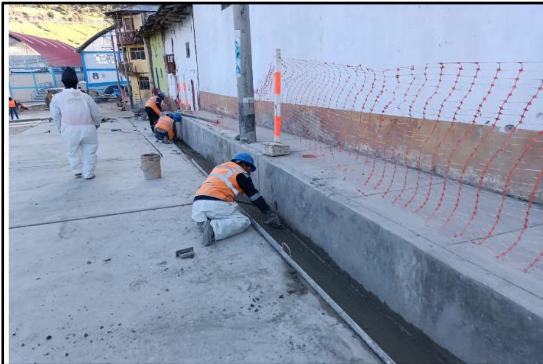
Figura 38: Actividad concreto f'c=175\text{kg/cm}^2 en cuneta de pavimento rígido
