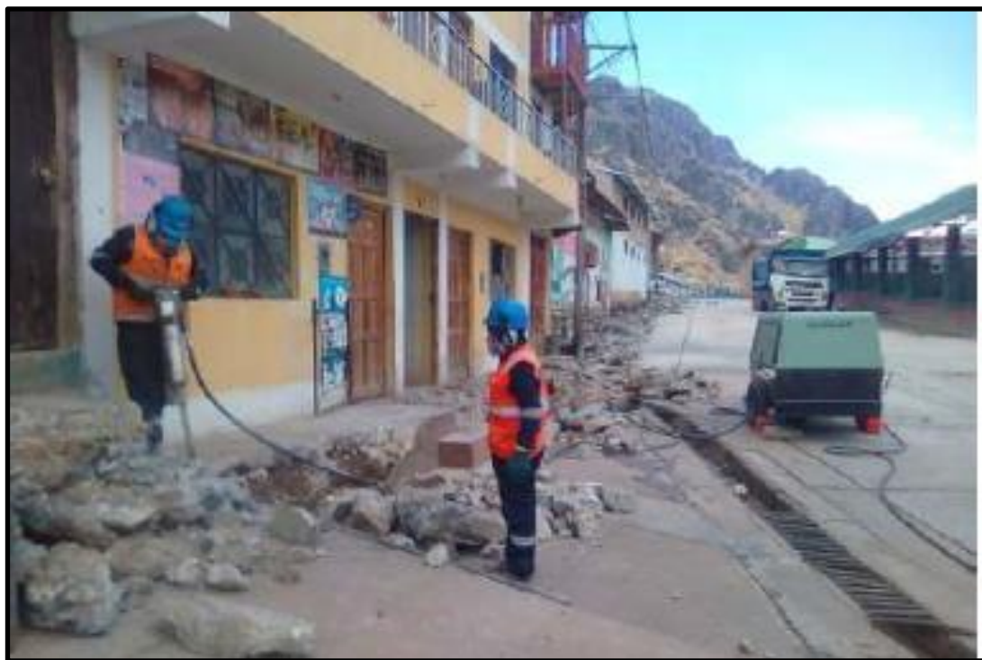
Figura 30: Se puede observar actividad demolición de veredas de concreto 02 operador equipo liviano+02 peones
