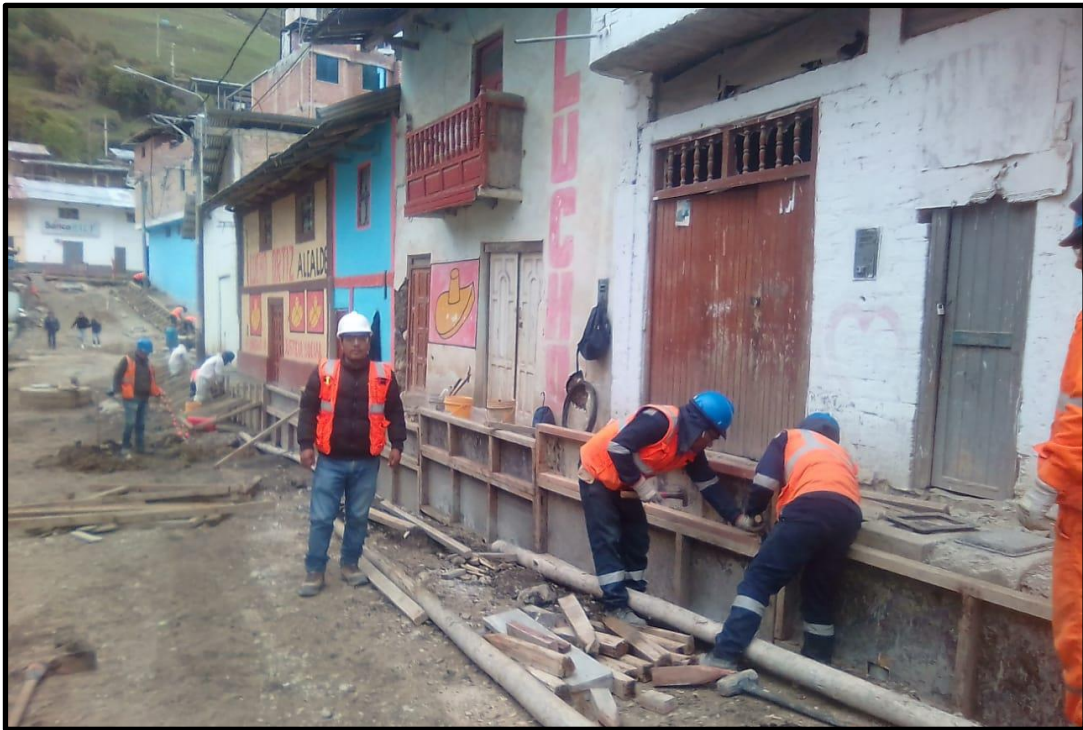
Figura 36: Vaciado de concreto f'c=175 \text{ kg/cm}^2 en vereda, e=0.10\text{m} , con
