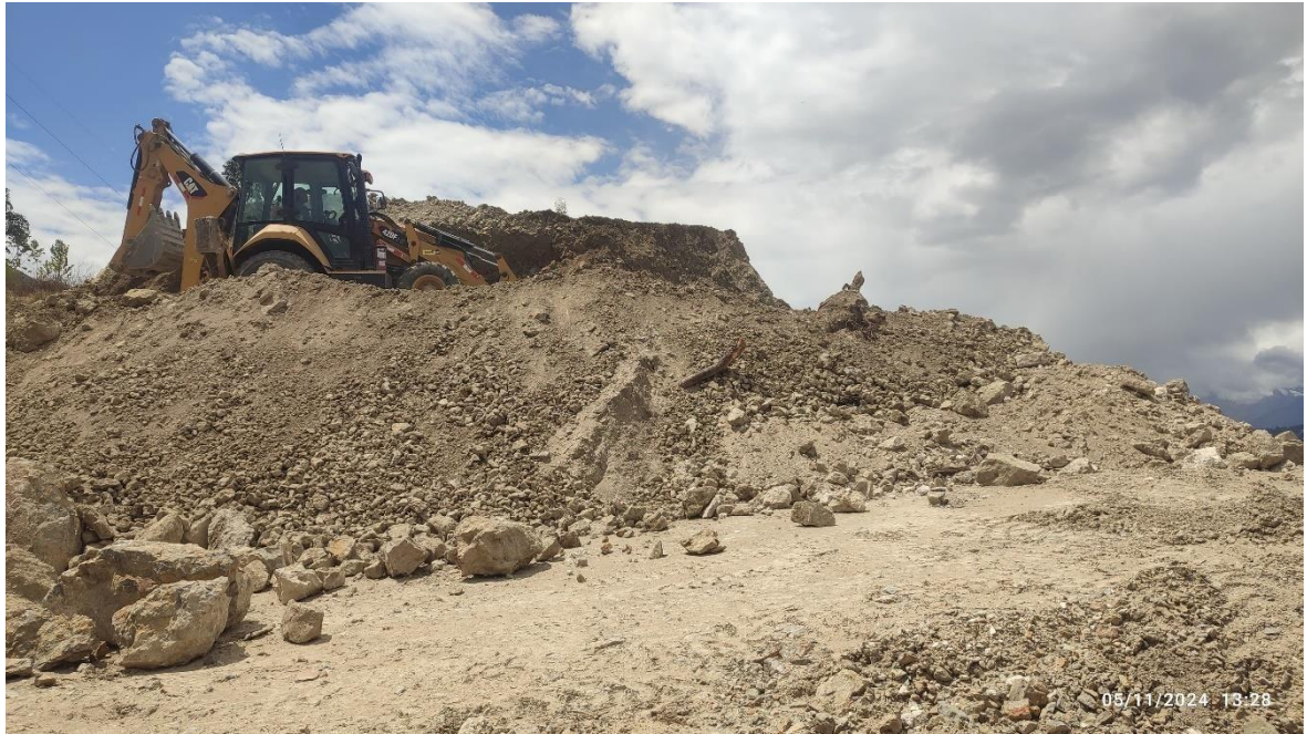
FOTO 5: Retroexcavadora liberando cobertura cuaternaria demostrando el espesor de 5.25m
