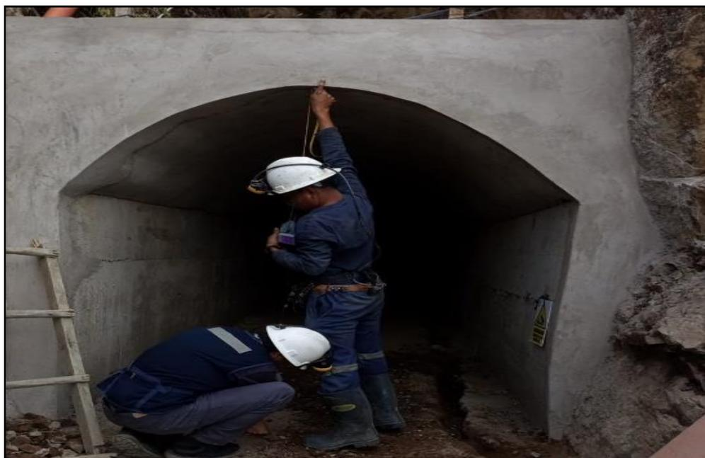
**Figura 13:** Toma de medidas de la Bocamina.
