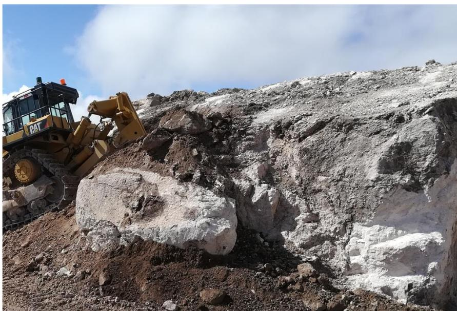
Foto 2. Corte por Dozer-Push en roca volcánica de la Formación Huambos.
