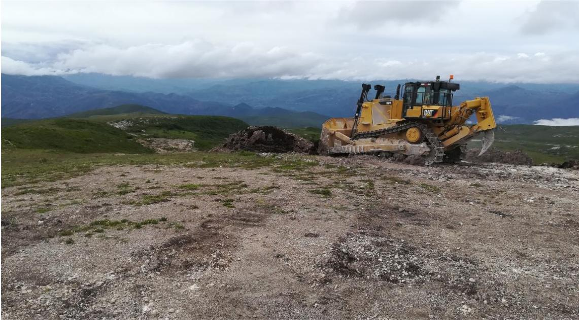
Foto 3. Limpieza del terreno superficial topsoil con tractor.
