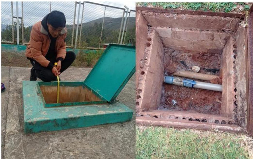
Nota: Medición de altura antes la apertura del servicio (fotografía izquierda). Apertura de la válvula de control del reservorio (fotografía derecha).
