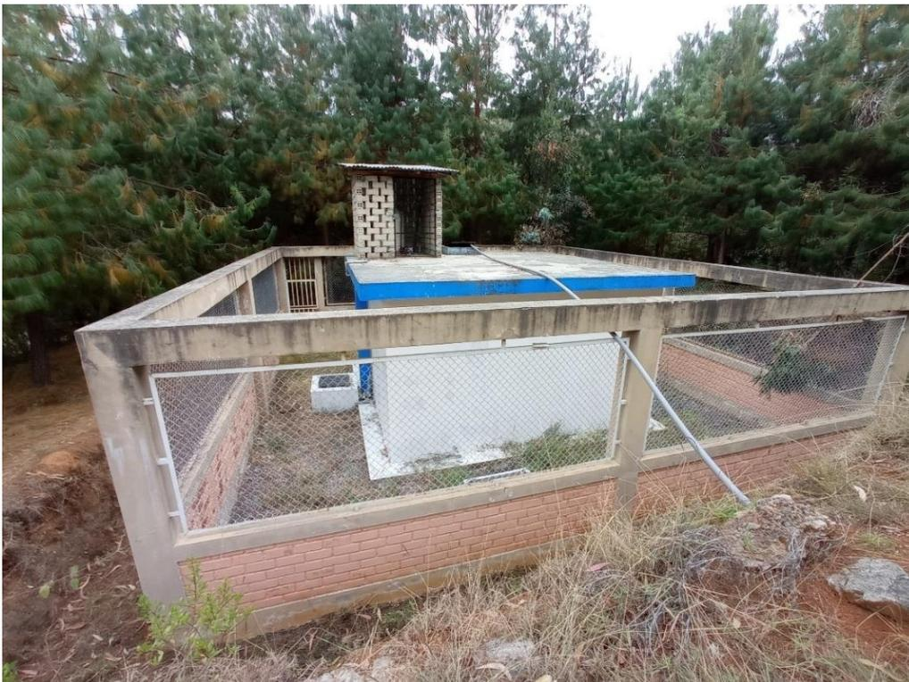
Nota: Se observa el ingreso de una tubería por la tapa sanitaria del reservorio, por ella ingresan el agua proveniente de las captaciones Cashmillap y La Cortadera.
