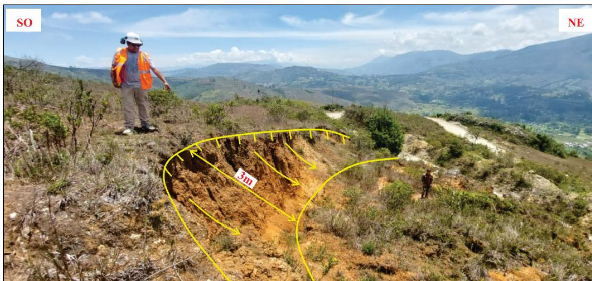
Fotografía 10 Zona de arranque del deslizamiento, presencia de escarpe y grietas. Foto tomada en la margen izquierda de la carretera Lomas del Indio Km 10+20
