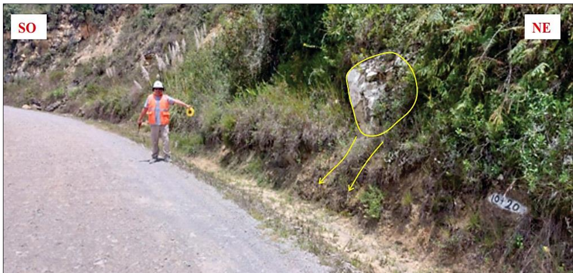
Fotografía 7 Caída de rocas. Bloque de roca de 1 metro aproximadamente de diámetro (caliza), identificado en la margen izquierda de la carretera Lomas del Indio en el Km 10+20
