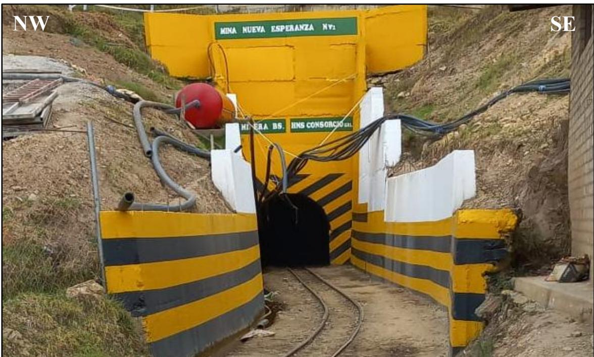
Foto 2. Vista de la Bocamina Nv. 3060. por donde sale el aire viciado de las labores de trabajo, tiene una longitud de 1500 metros hasta la zona Sur y cuenta con rieles al centro para el tránsito de las vagonetas.
