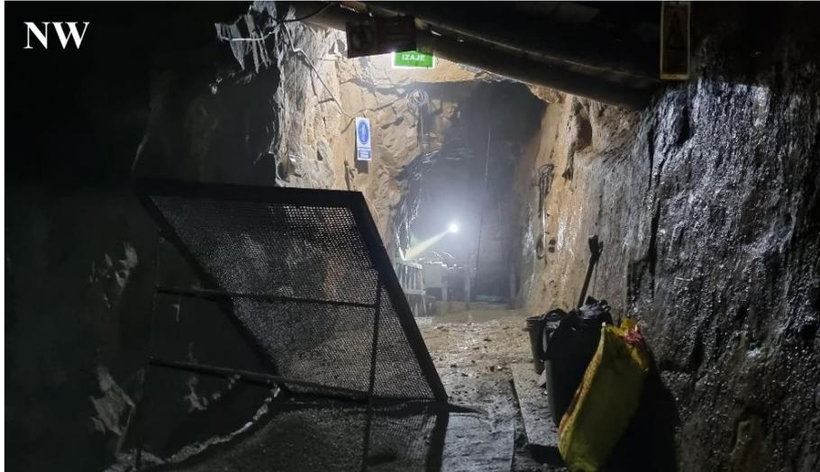
Foto 21. Veta Victoria ubicada en la zona Centro, con dirección NW - SE y cota 3010 m.s.n.m; cuenta con 3 frentes de trabajo.
