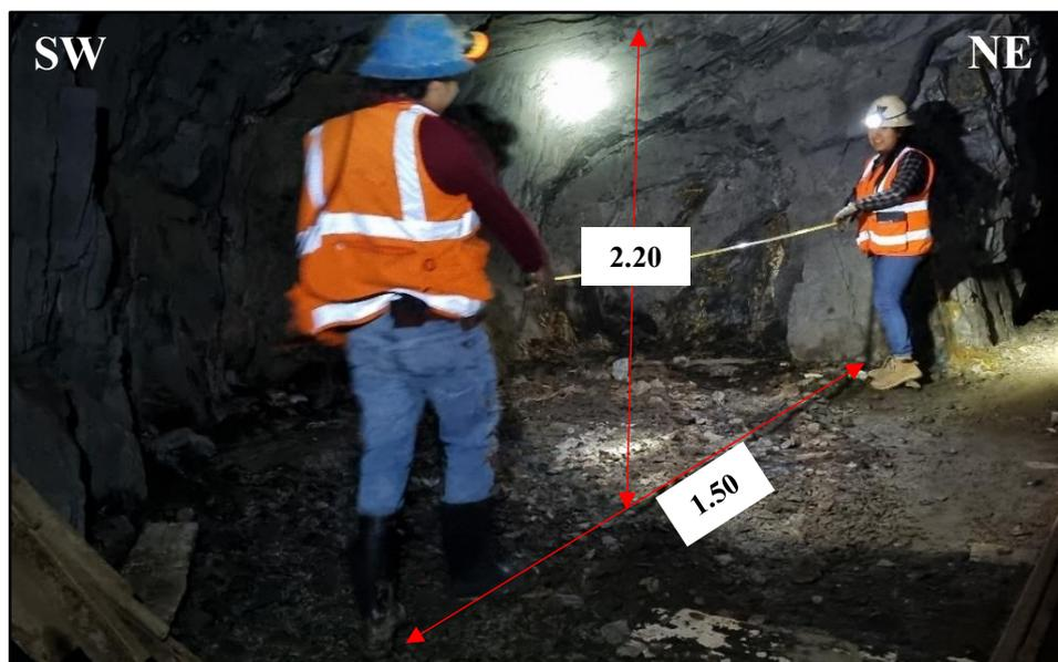
Foto 30. Cámara de salvataje 2: Ubicada en la zona Centro, tiene altura de 2.20 m y ancho 1.50m; el macizo rocoso es areniscas cuarzosas de buena calidad geomecánica (RMR<sub>89</sub> 72).
