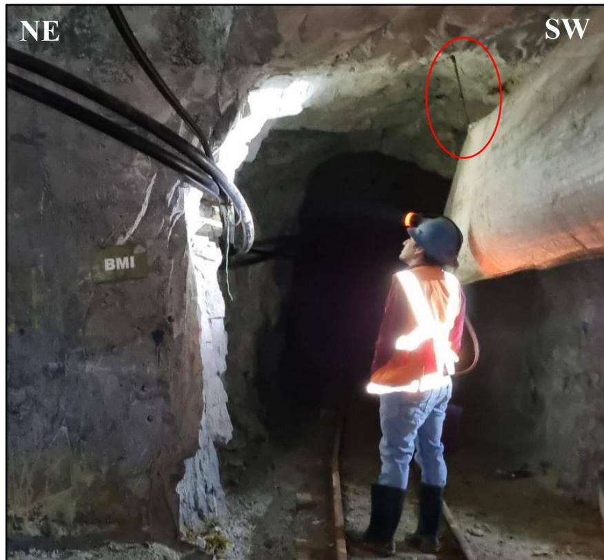
Foto 12. Alcayatas para colocar las mangas de ventilación de Nylon al costado de la parte superior de las galerías.
