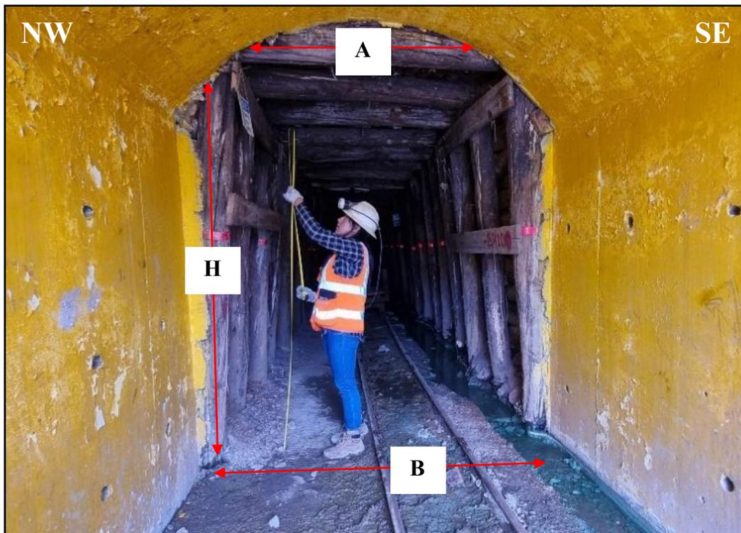
Foto 13. Cálculo del área de la bocamina Nv. 2880 por donde ingresa el aire limpio.
