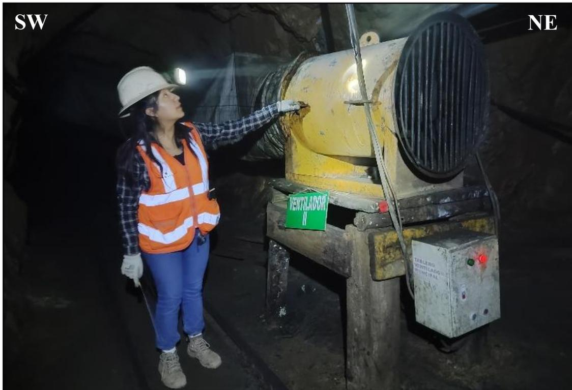
Foto 24. Ventilador tipo Aspirante instalado sobre una plataforma de madera con un tablero eléctrico para su funcionamiento.
