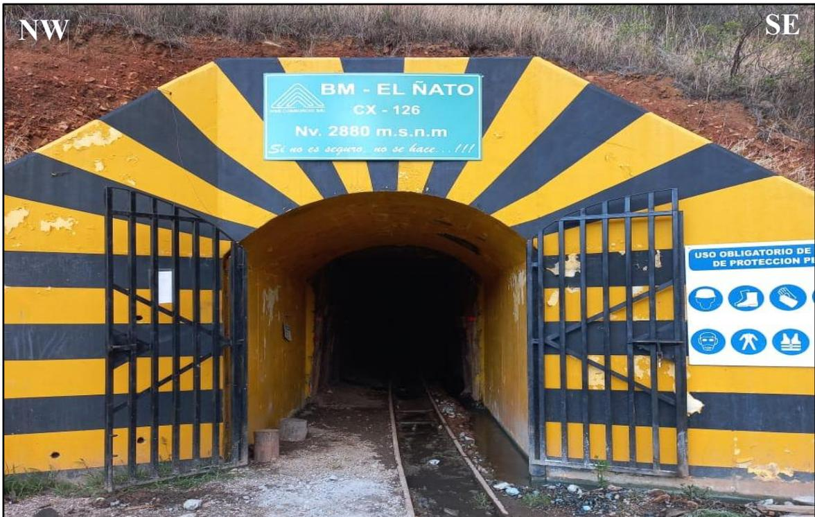
Foto 1. Vista de la Bocamina Nv. 2880 por donde ingresa el aire limpio a las labores de trabajo, tiene una longitud de 800 metros y cuenta con rieles al costado para el tránsito de las vagonetas.
