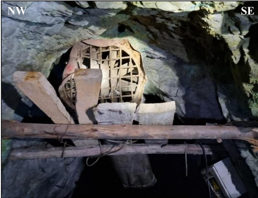
Foto 26. Ventilador en mal estado; chancado y deteriorado en la zona Sur. Ubicado en la parte superior de la galería sobre palos de madera.
