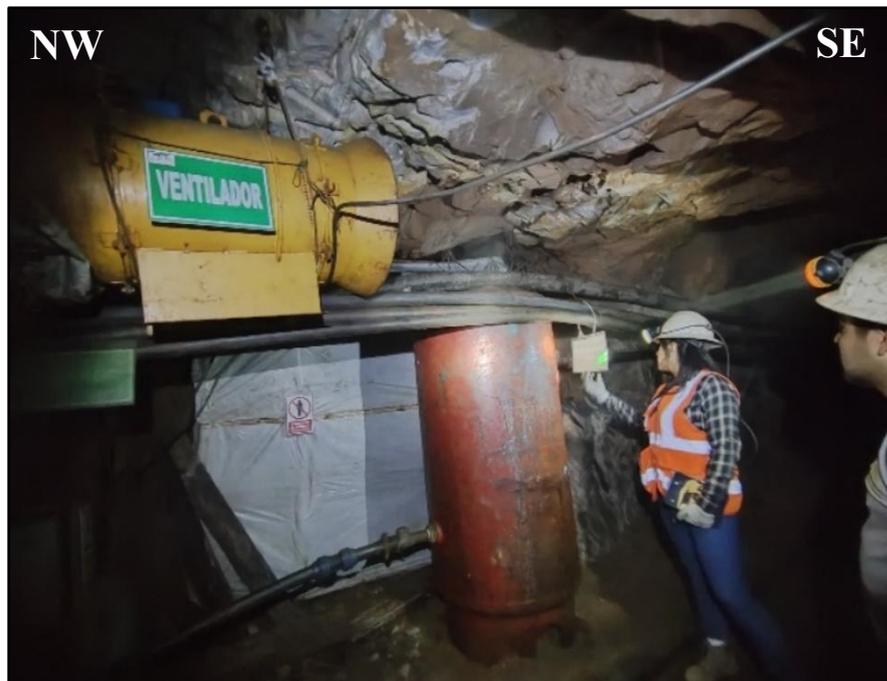
Foto 7. Ventilador Impelente de 20 HP, colgado en la parte superior con pernos de anclaje y cable acerado a presión.
