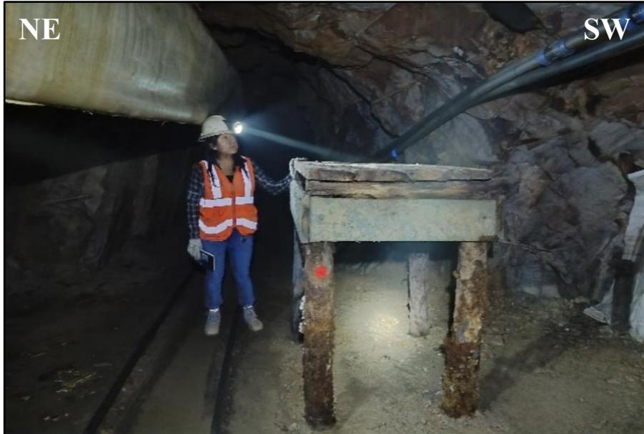
Foto 8. Plataformas de soporte de madera que sirven para sostener, asegurar, facilitar la instalación y el mantenimiento de los ventiladores.
