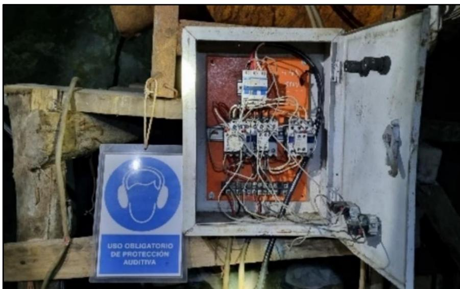
Foto 9. Tablero eléctrico para el control y distribución de energía de un ventilador.
