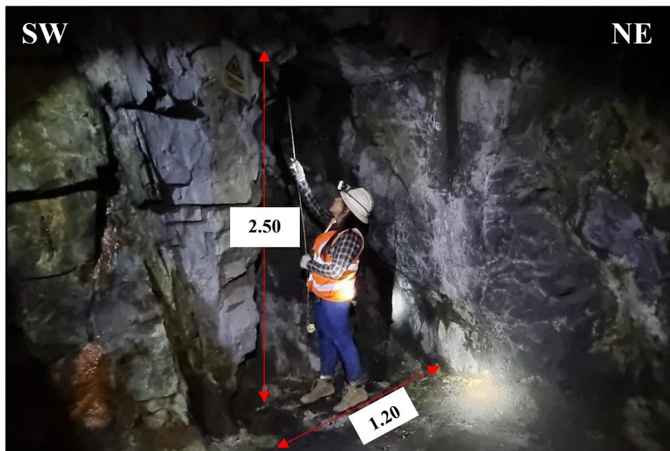
Foto 29. Cámara de salvataje 1: Ubicada en la zona Norte, tiene altura de 2.50 m y ancho 1.20m; el macizo rocoso es areniscas cuarzosas de buena calidad geomecánica (RMR<sub>89</sub> 69).
