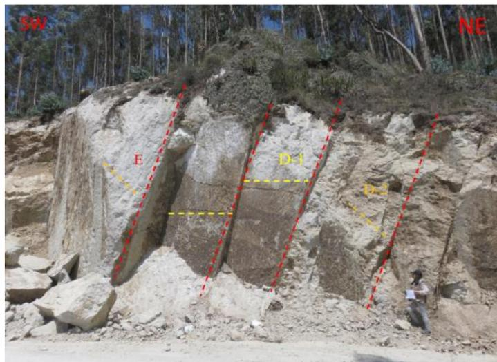
Foto 12. Roca volcánica Dacita, ubicada en el flanco derecho de la carretera Santa Apolonia – Cumbe Mayo, en la progresiva km 5+000, constituida por tres discontinuidades definiendo medio discontinuo, que conforman el macizo rocoso del talud.
