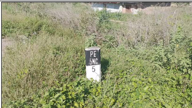
Foto N°15. Hito Kilométrico falto de limpieza y parcialmente oculto
