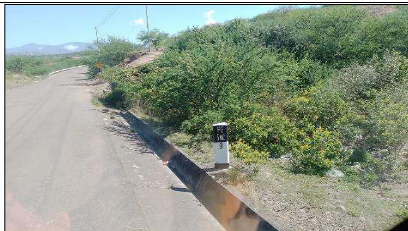
Foto N°16. Hito Kilométrico en regular a buen estado de conservación visible
