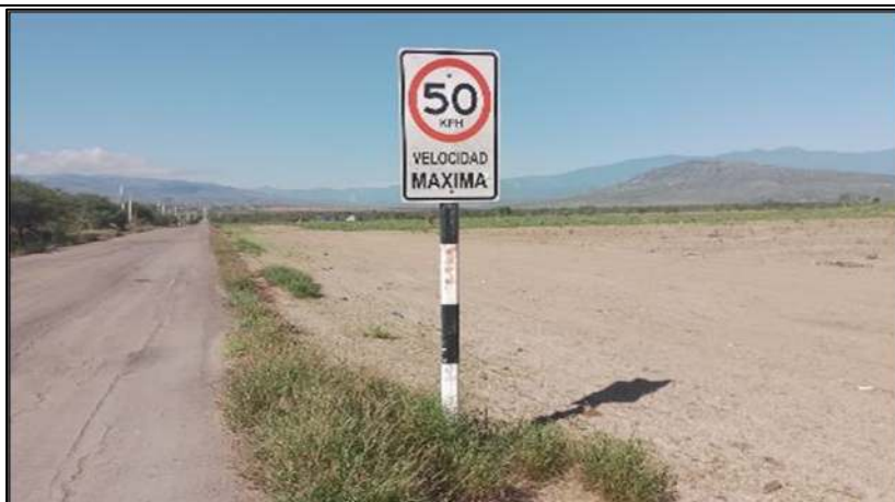
Foto N°07. Señal R-30 legible en regular estado de conservación
