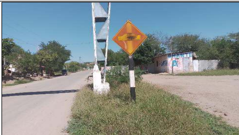
Foto N°09. Señal P-33A poco visible en mal estado de conservación
