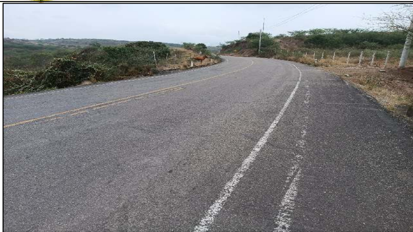
Foto N°13. Marca en el Pavimento (Lateral y Central) en regular estado de conservación – Doble marcación lateral
