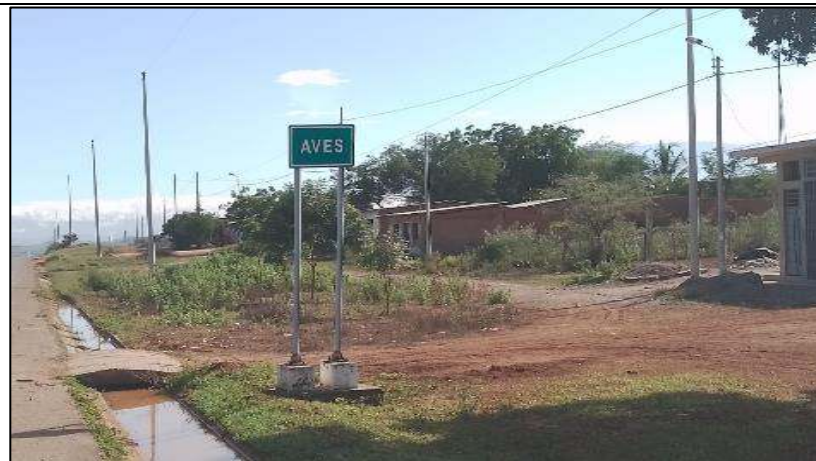
Foto N°10. Señal I-Aves visible en buen estado de conservación
