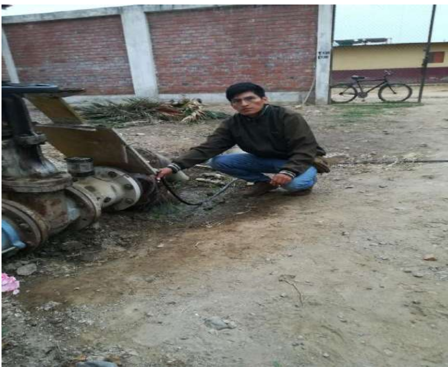
Toma de muestra de cloro residual libre Reservorio N°01 – (600 m3).
