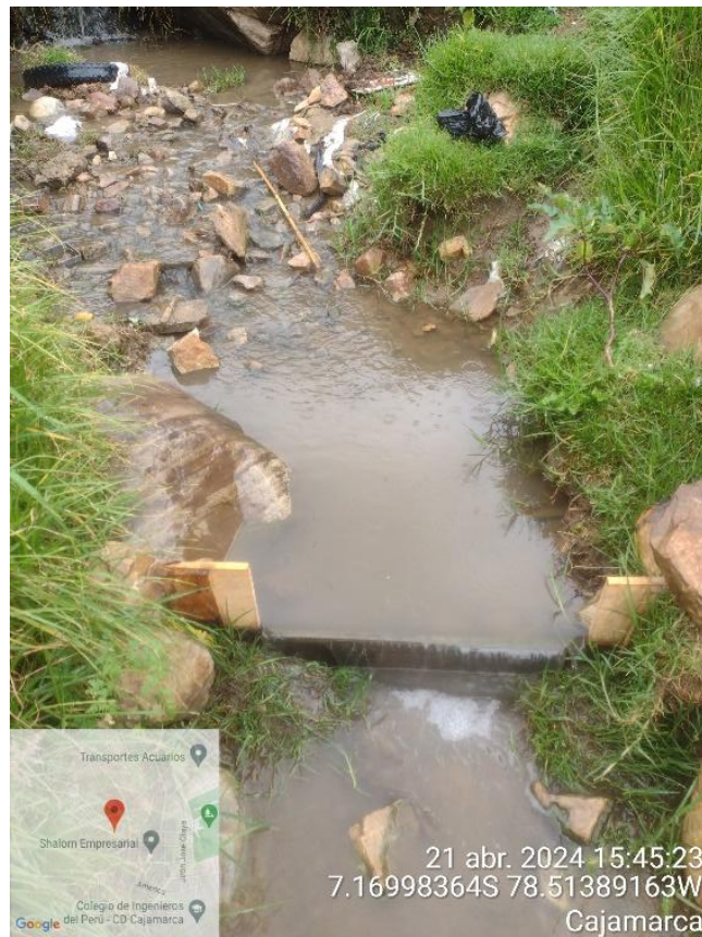
Figura 39: Instalación del vertedero
