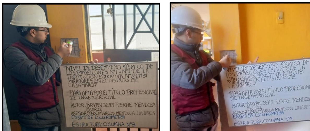
*Nota.* Fotografías tomadas realizando ensayo de esclerometría en columnas del pab. N°1, 2025.
