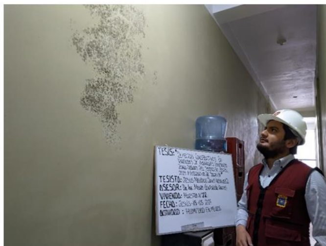
Foto 17 Eflorescencia en muros
