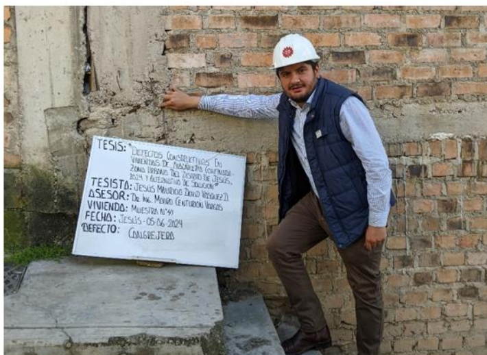
Foto 9 Cangrejeras en elementos estructurales
