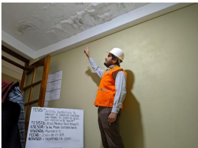
Foto 15 Humedad en losas
