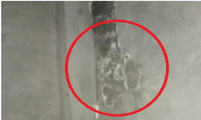
b) Humedad en muros o losas
