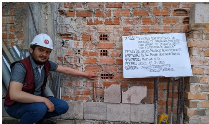
Foto 5 Muros sin viga solera
