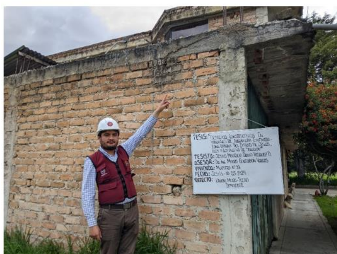
Foto 12 Unión muro – techo deficiente
