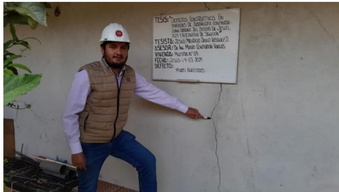
Foto 14 Ladrillos de baja calidad
