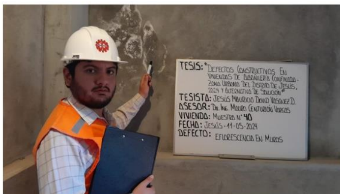
Foto 17 Eflorescencia en muros
