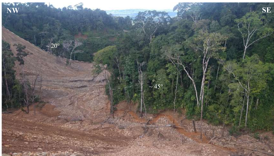
Fotografía 7: Taludes considerablemente inclinados, están propensos a la erosión, sobre todo aquellos que no tienen cobertura vegetal.
