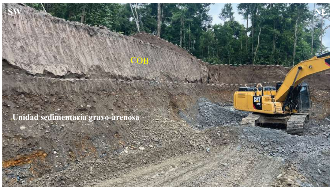
Fotografía 13: Capa superior de sobrecarga o material estéril, compuesto por limos y arcillas, espesor aproximado de 2.5 metros, en contacto directo con una unidad sedimentaria gravo-arenosa subyacente. El perfil litoestratigráfico corresponde a un banco ubicado al margen derecho del río Colorado (aguas abajo).
