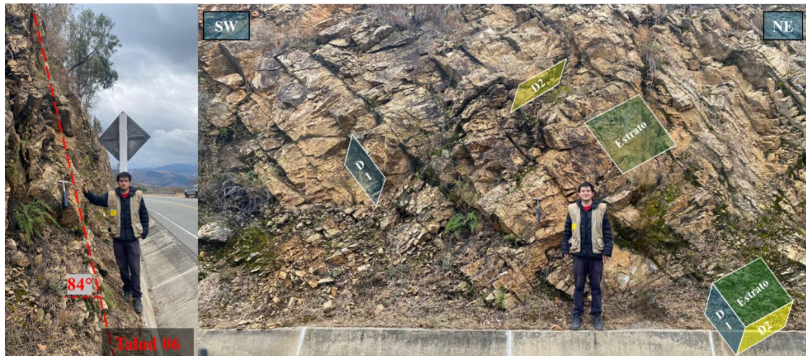
Foto 14: Geometría del talud SM-06(a). Familias del talud SM-06(b).
