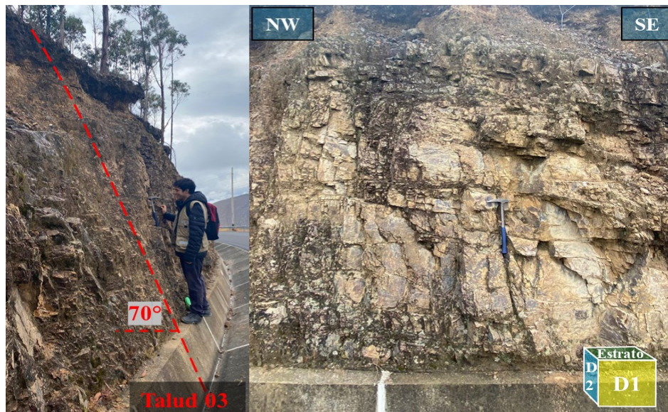
Foto 11: Geometría del talud SM-03(a). Familias del talud SM-03(b).
