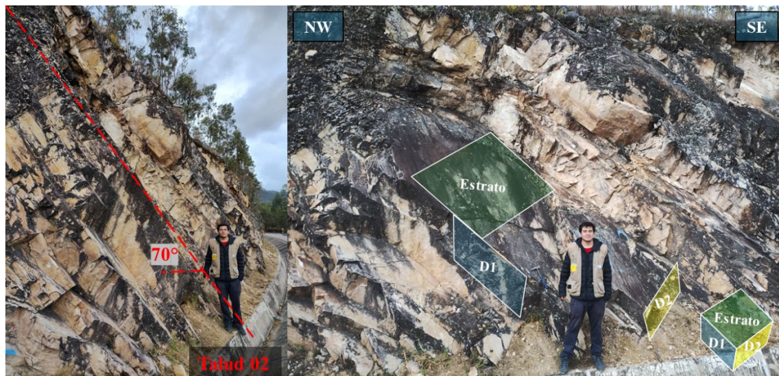
Foto 10: Geometría del talud SM-02(a). Familias del talud SM-02(b).
