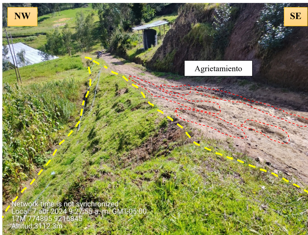
Fotografía 23. Agrietamientos en vía principal. Coordenadas: E: 774805 N: 9216845 C: 3112 m.s.n.m.
