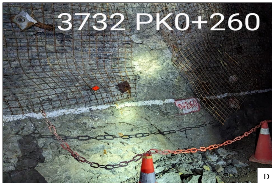
Figura 7. En el hastial izquierdo de la PK0+260 en la GA 179 NW del nivel 3732 se puede observar que la malla electrosoldada y el Split set se encuentran corroídos, se presume que están así debido a la composición sulfurosa en el macizo rocoso. Fuente: Turner, 2023
