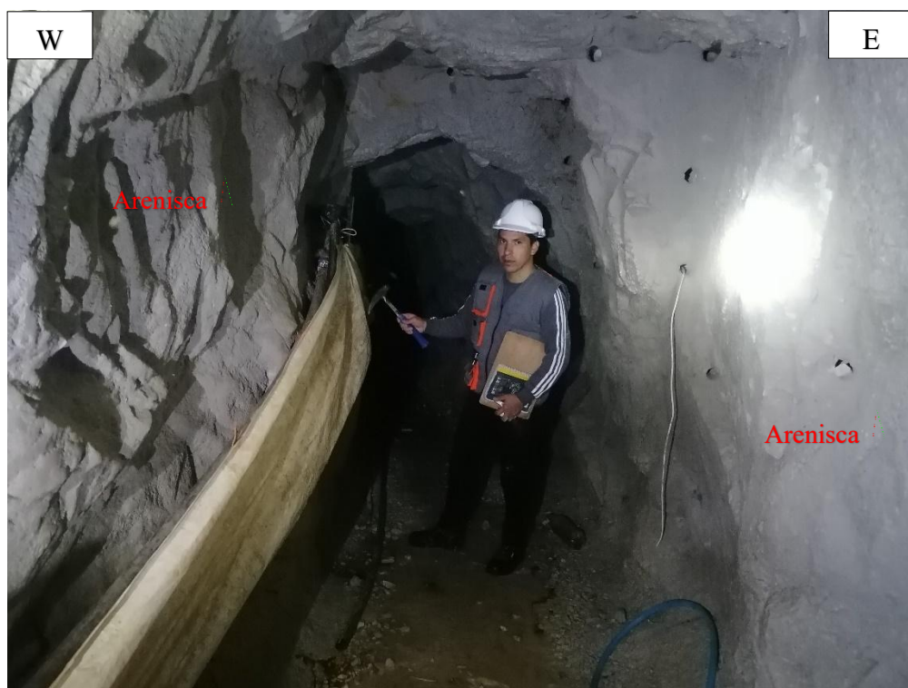
Figura 13. Roca Arenisca de Color Blanquecino de la Formación Chimú ubicada en el Pi+80.50 m. constituyendo la Caja: Techo y Piso del Túnel de la Sección en Forma de Baúl.
