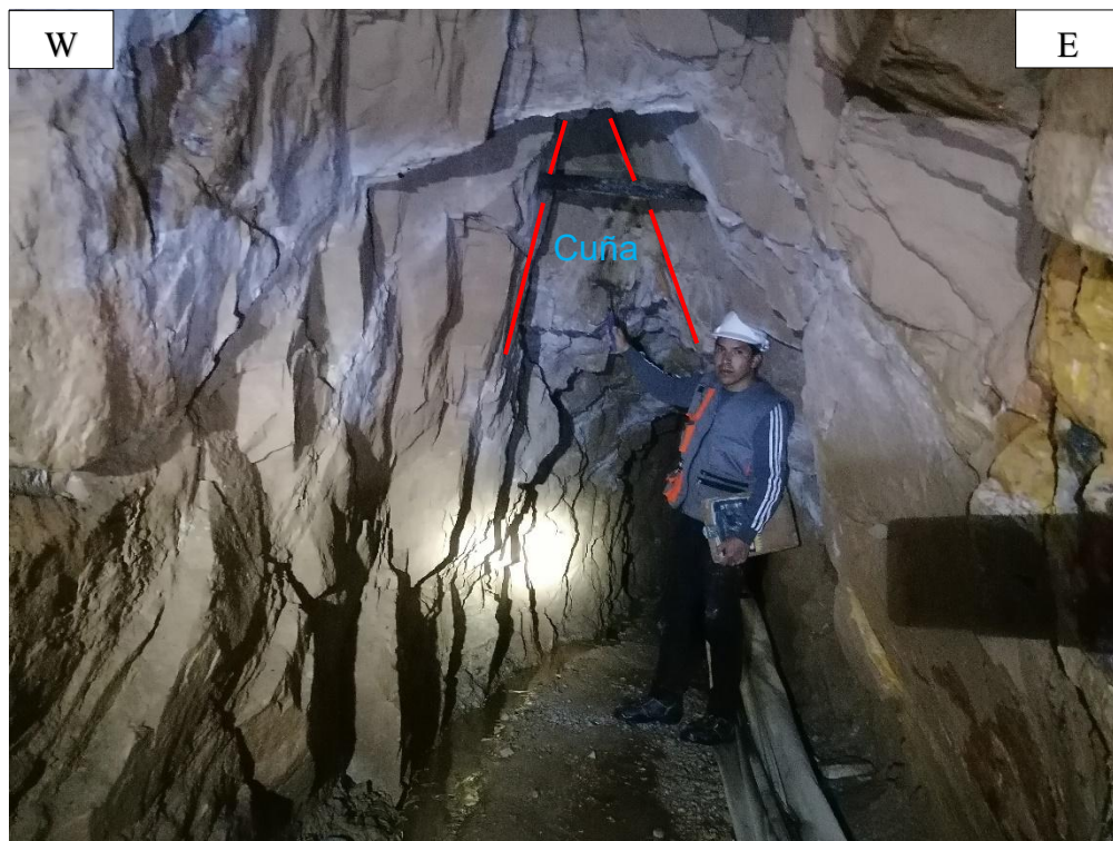
Figura 19. Cuña Tetraédrica ubicada en la Clave del Túnel, delimitada por Tres Familias de Juntas, en el Pi+80.25 m.
