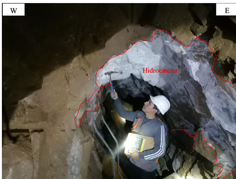
Figura 18. Filtraciones de Agua en la Clave y Hastiales en el Pic+4.38 m.; formándose, por la Constante Humedad, Zonas Blanquecinas de Mineral Hidrocincita de Espesor 5 mm.
