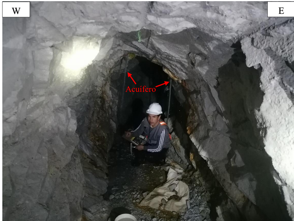
Figura 17. Acuífero de Agua Subterránea filtra en la Clave ubicado en el Pi+116.50 m., en una Apertura de Junta 1.50 cm. a 2.50 cm. con Q = 2.45 Lt/s, manteniendo Flujo Constante de Agua en forma de Chorro.
