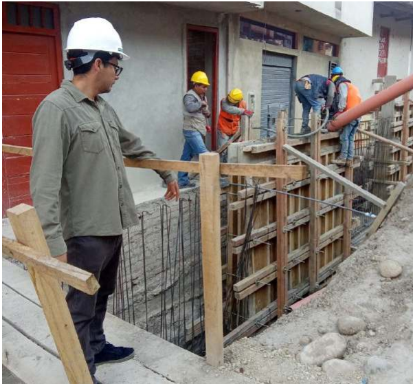
Foto N° 14: Vaciado de concreto f'c=210 \text{ kg/cm}^2 en pantalla de muro de concreto armado
