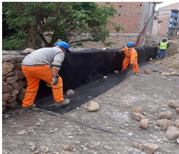
Colocación del geotextil de separación
