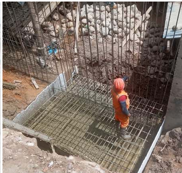
Foto N° 12: Vaciado de concreto en zapata de muro de concreto armado
