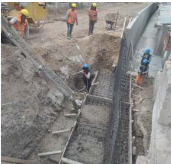
Foto N° 12: Vaciado de concreto en zapata de muro de concreto armado
