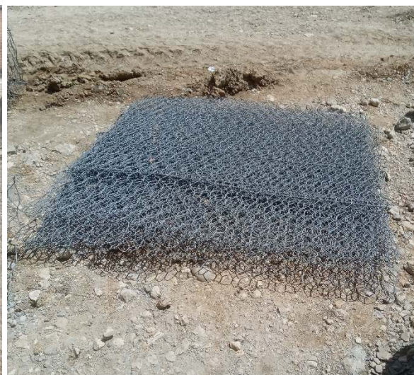
Foto N° 03: Elemento de muro de suelo reforzado
