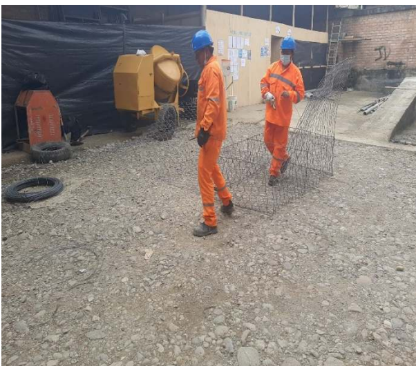
Foto N° 03: Elemento de muro de suelo reforzado
