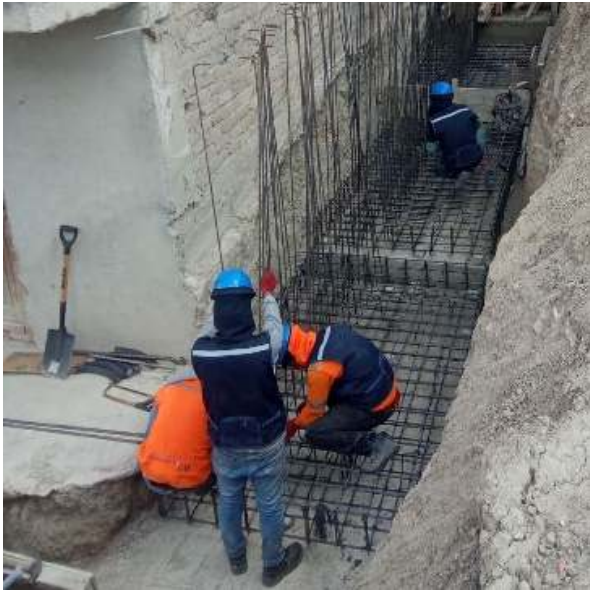
Foto N° 10: Acero de refuerzo en zapata y pantalla
