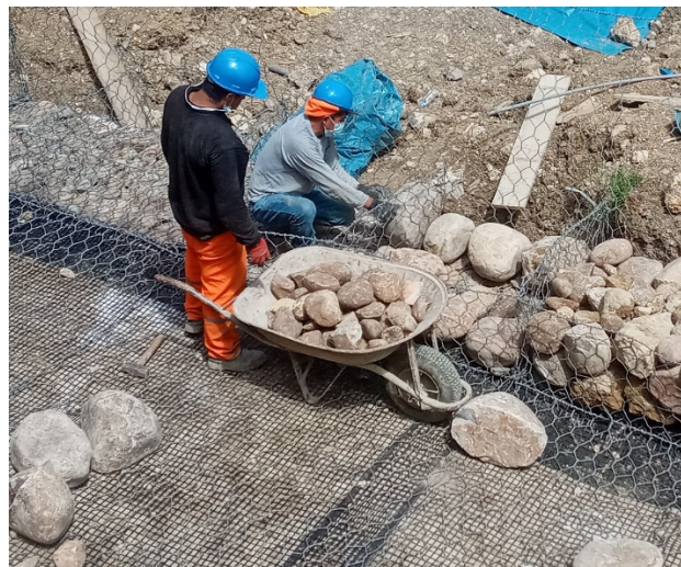
Foto N° 08: Colocación y acomodo de mediana de 6"-10" en elemento terramesh system
