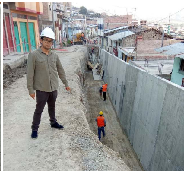
Foto N° 15: Relleno y compactación con material de préstamo
