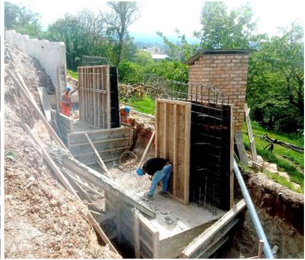
Foto N° 13: Encofrado de muro de concreto armado en voladizo
