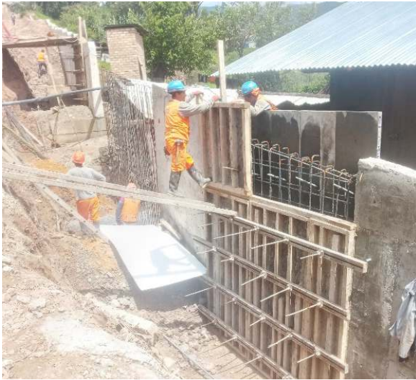
Foto N° 13: Encofrado de muro de concreto armado en voladizo
