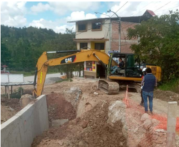
Foto N° 02: Excavación de zanjas
