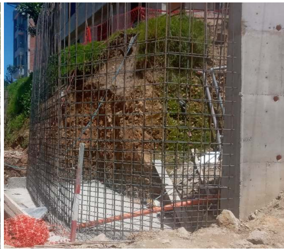
Foto N° 11: Acero de refuerzo en zapata y pantalla
