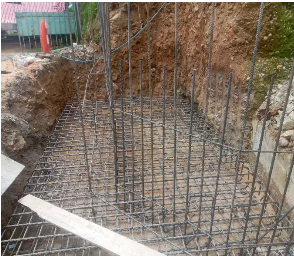
Foto N° 11: Acero de refuerzo en zapata y pantalla
