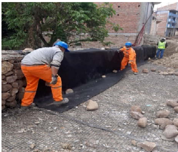
Foto N° 04: Geotextil no tejido clase II y geomalla soldada de poliéster tipo II
