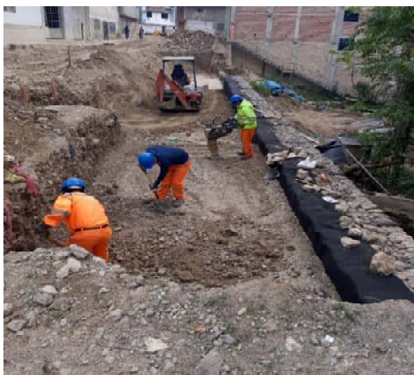
Foto N° 06: Relleno y compactación con material de préstamo
