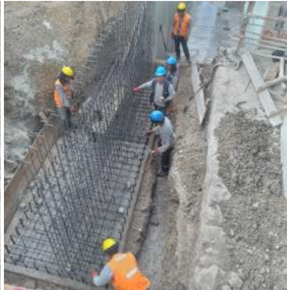
Foto N° 10: Acero de refuerzo en zapata y pantalla
