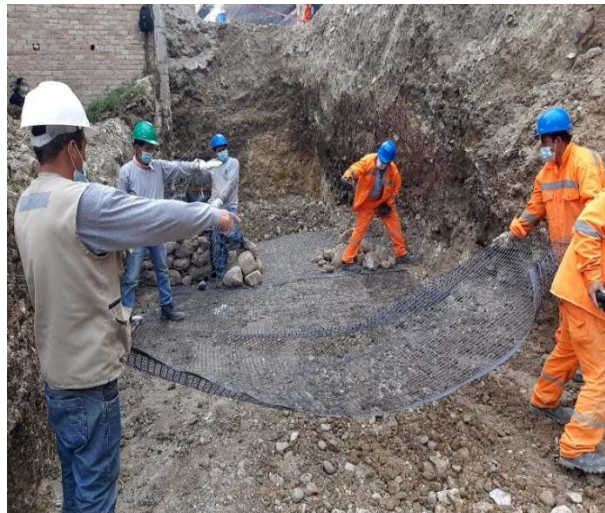
Foto N° 04: Geotextil no tejido clase II y geomalla soldada de poliéster tipo II
