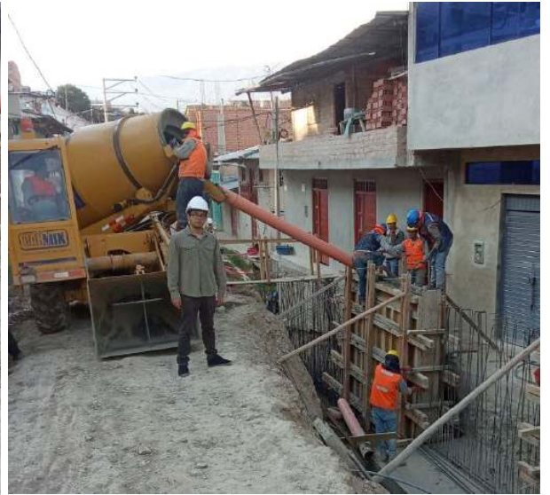
Foto N° 14: Vaciado de concreto f'c=210 \text{ kg/cm}^2 en pantalla de muro de concreto armado
