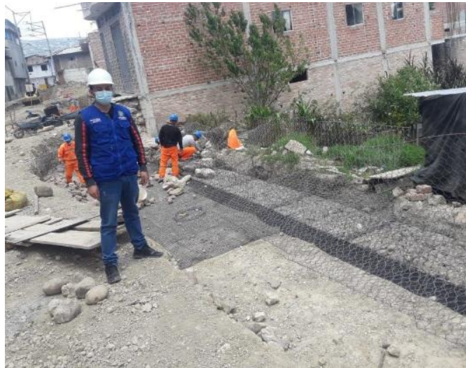
Colocación de elementos terramesh
