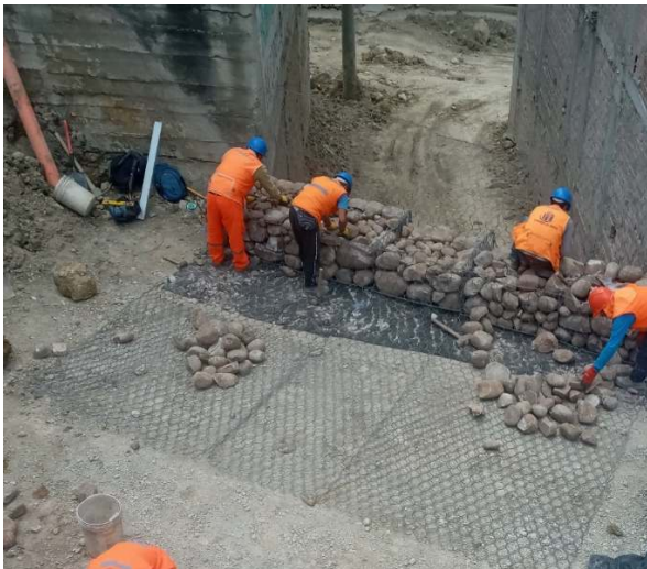
Foto N° 08: Colocación y acomodo de mediana de 6"-10" en elemento terramesh system
