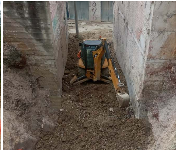
Foto N° 02: Excavación de zanjas
