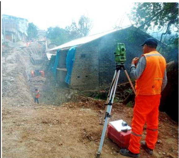
Foto N° 01: Trazo, niveles y replanteo en obra
