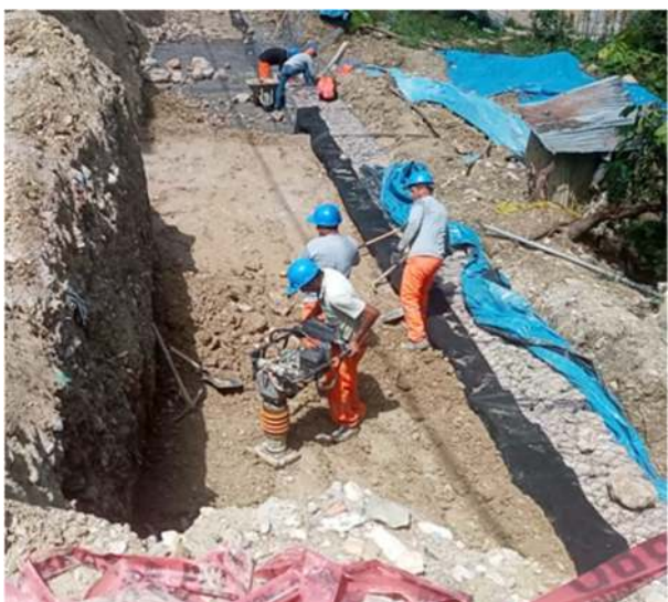
Foto N° 06: Relleno y compactación con material de préstamo
