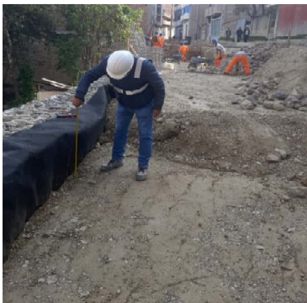
Foto N° 05: Elemento terramesh system de 0.50x1.00x4.00m y 1.00x1.00x4.00m
