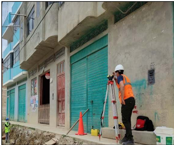
Foto N° 01: Trazo, niveles y replanteo en obra
