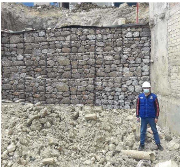
Foto N° 09: Paramento frontal de muro de suelo reforzado
