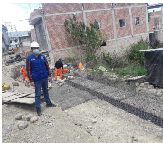
Foto N° 09: Paramento frontal de muro de suelo reforzado
