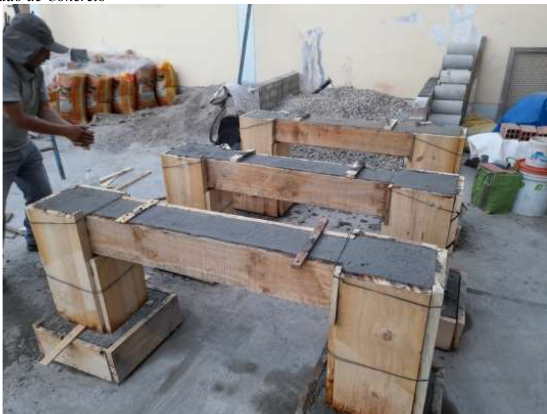
Figura 53. Vaciado de Concreto
