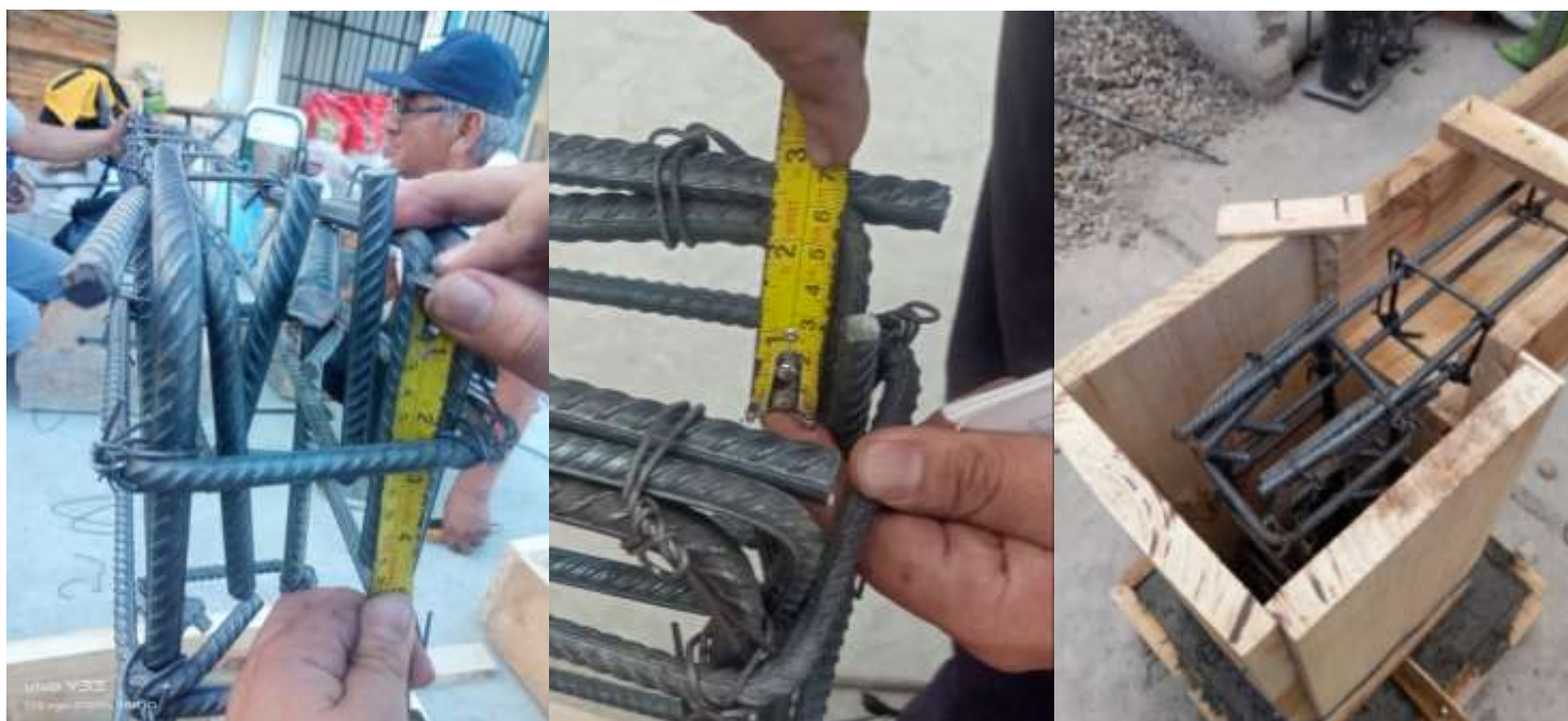
Figura 52. Verificación de las Medidas de los Anclajes
