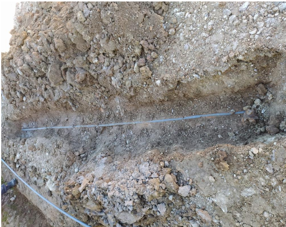
Figura 19. Fuga de la tubería \frac{3}{4} de pulgada (Prolongación San Cayetano).
