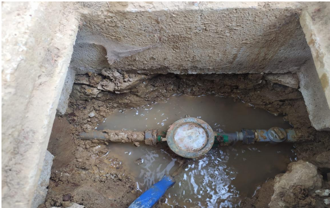
Figura 20. Fuga en caja de registro Código :72784.
