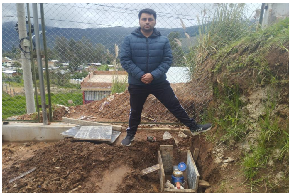
Figura 15. Instalación de macromedidor a la salida del reservorio Bellavista.
