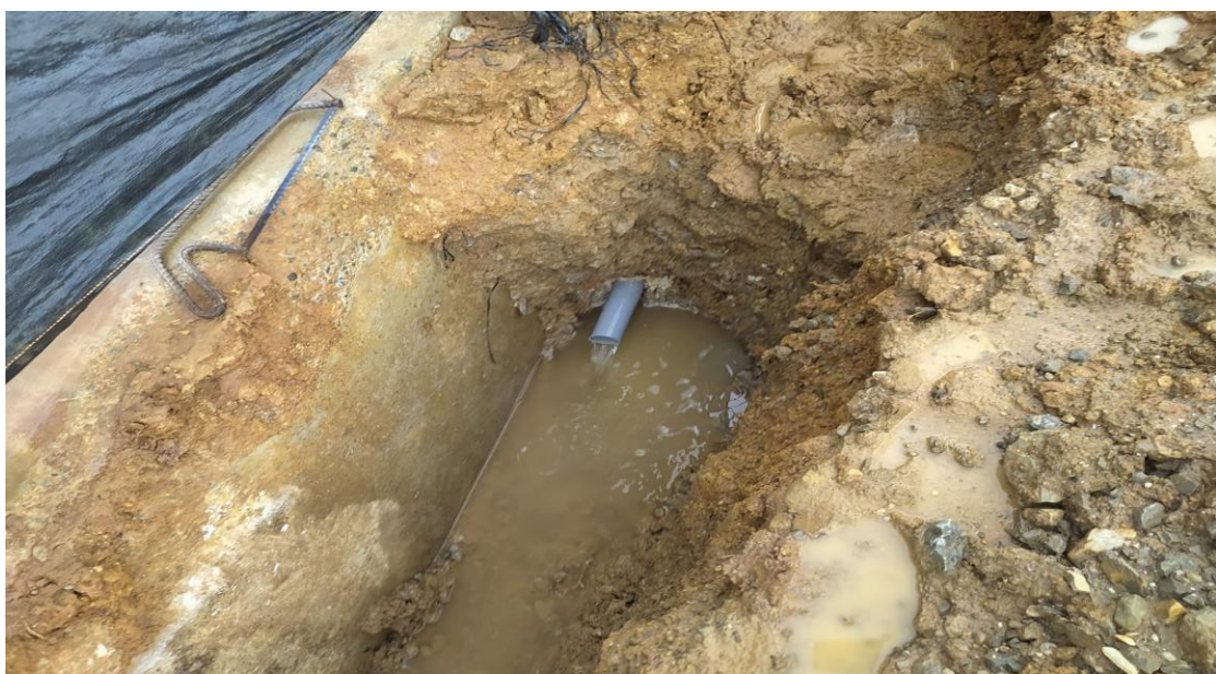
Figura 17. Rotura de tubería matriz Av. Cajamarca.
