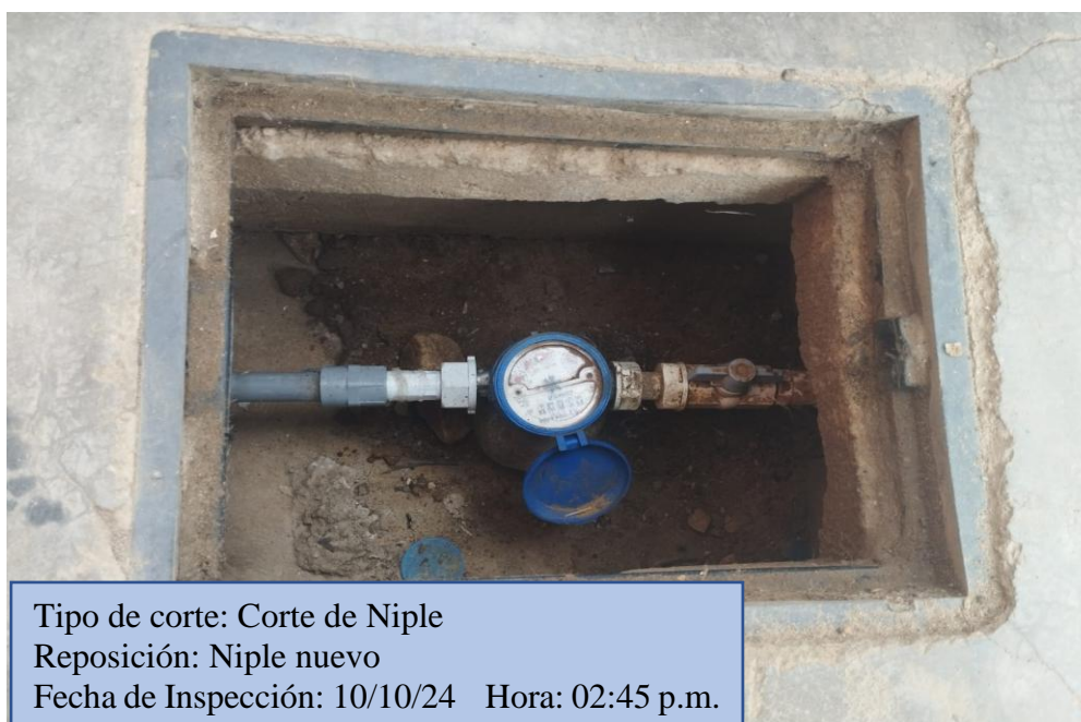
Figura 21. Reposición no autorizada codigo:72815
