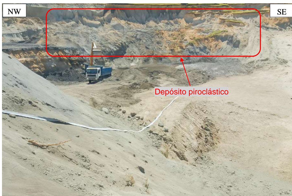
Figura 4.13. Inestabilidades en sector Norte del tajo Mina Vieja de explotación, relacionándose con deslizamiento rotacional compuesto, por las secuencias progresivas de escarpas de asentamiento posteriores de la corona del talud.
