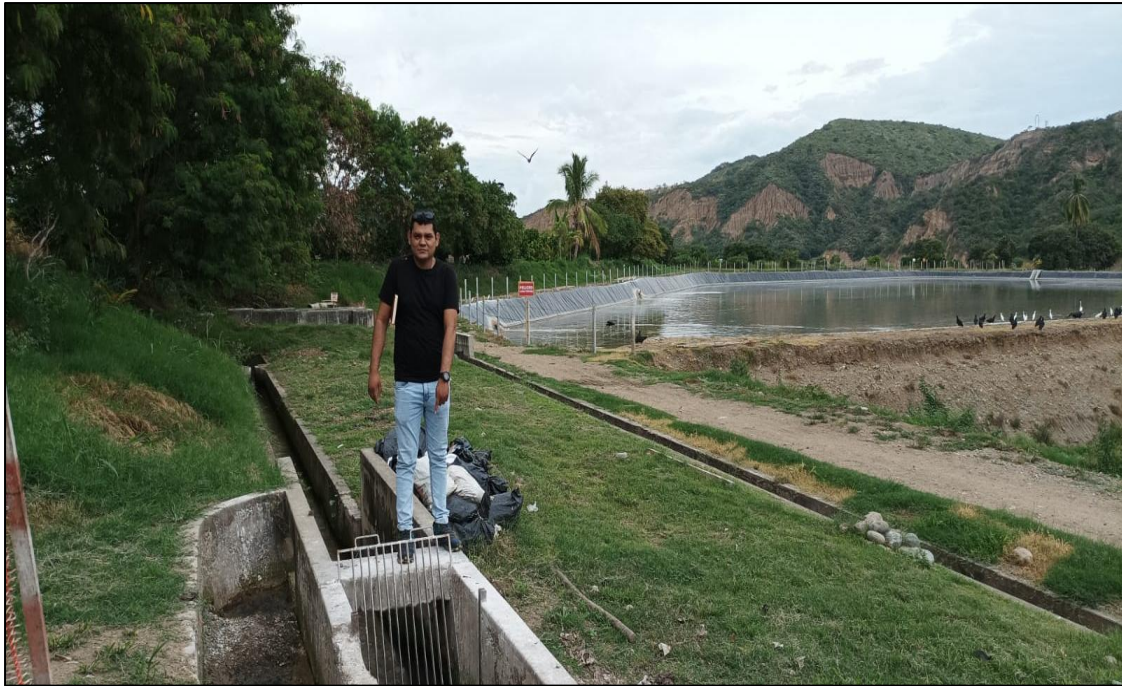
Fotografía 1. Vista de la cámara de rejillas del afluente a la laguna de oxidación.
