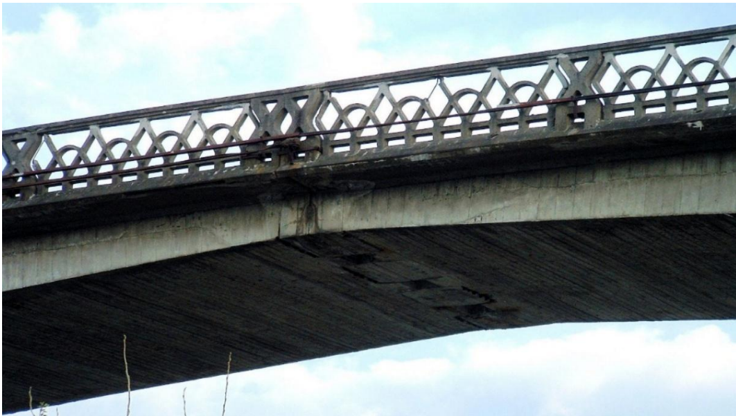
Figura 3. Puente Boutiron. Se observa las cavidades en la clave del arco donde se instalaron los gatos de desencofrado
