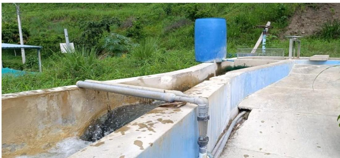
Nota: Su trabajo de los tubos es proporcionar dosificaciones de sulfato de aluminio de 0 a 400 NTU y policloruro de aluminio de 0 a 6000 NTU, siendo su concentración el 2 % lo que equivale a 25 kg por cada 1000 litros de agua, siempre teniendo un margen de 5%.
