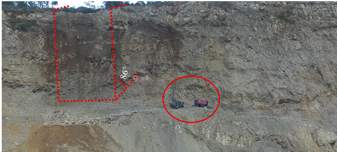
Figura 35. Equipos de Perforación en Talud
