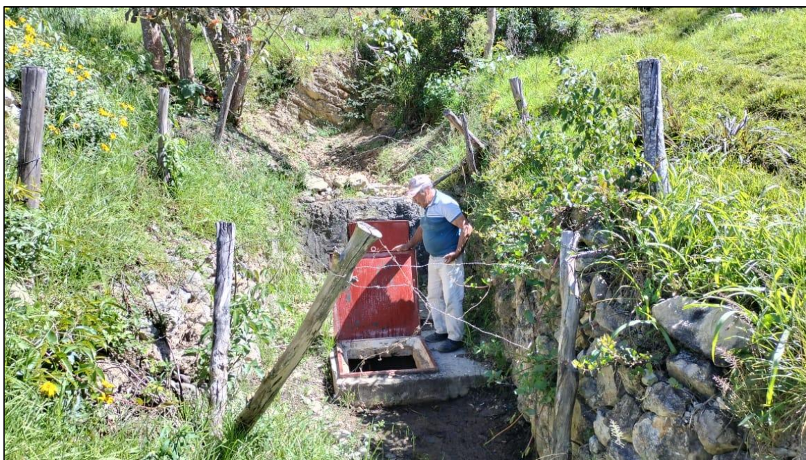
Fotografía 3. Identificación y evaluación de la captación “Peje de Oro”.
