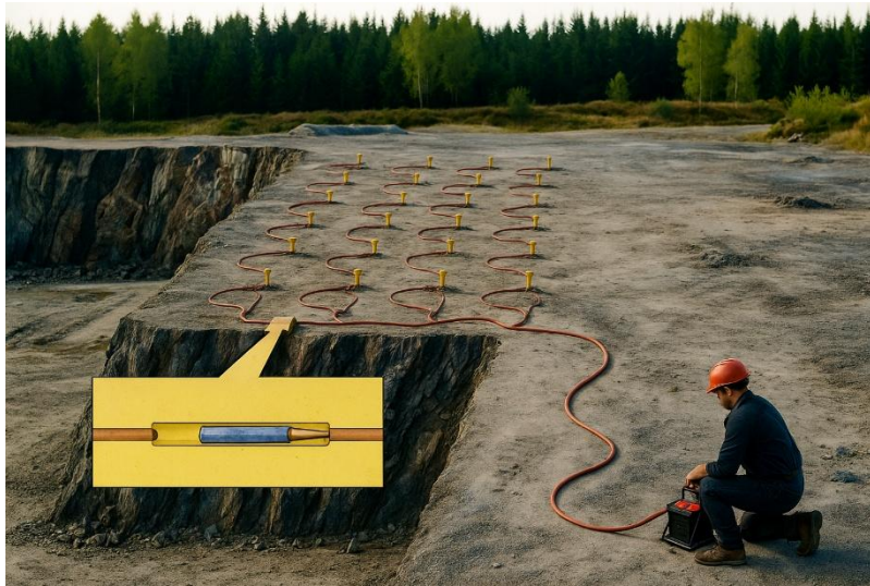
Figura 11. Sistema de iniciación no eléctrica. Fuente: Bernaola, Catilla y Herrera (2013)
