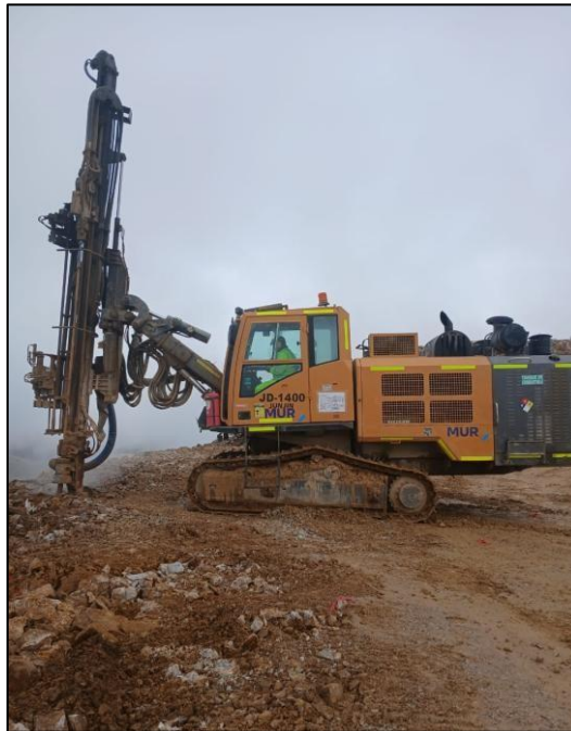
Fotografía 2. Perforadora Rock Drill – Proyecto P3660-112
