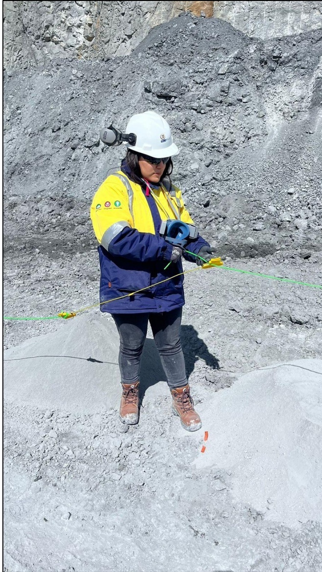
Fotografía 4. Amarre de taladros para voladura - Proyecto P3650-105-GF-C8
