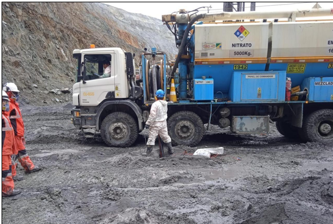
Fotografía 7. Carguío de taladros con Nitrato de Amonio y Emulsion Gasificada - Proyecto P3640-067-GF-C8
