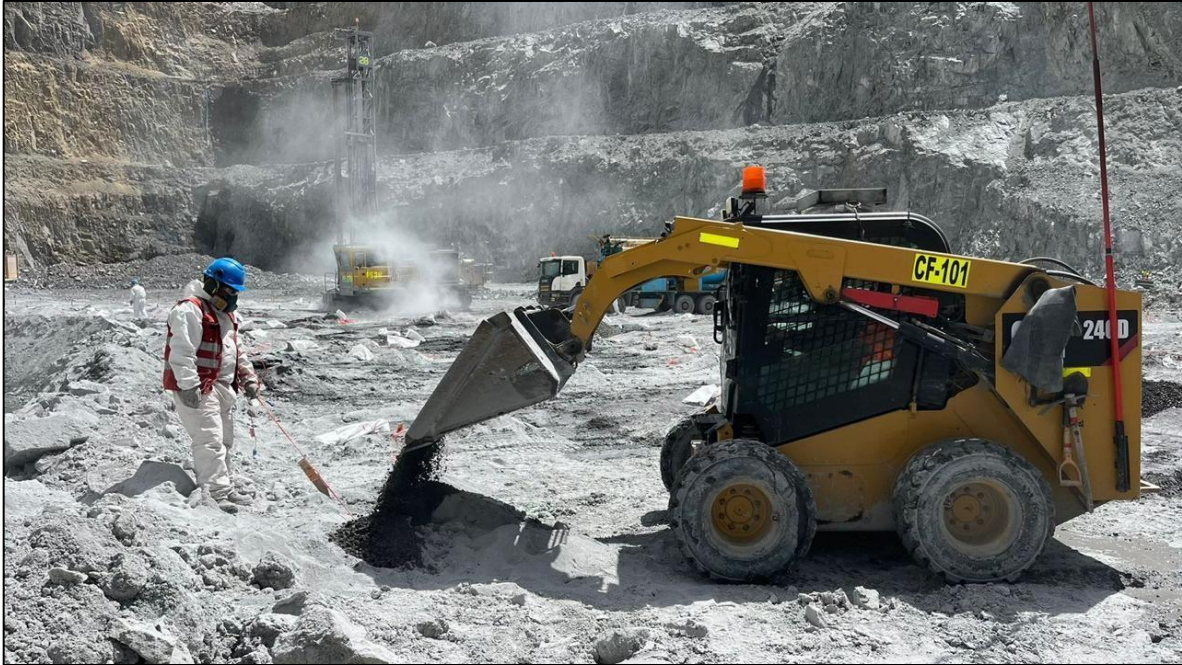
Fotografía 6. Tapado de taladros para que no haya rocas disparadas - Proyecto P3660-112-GF-C8
