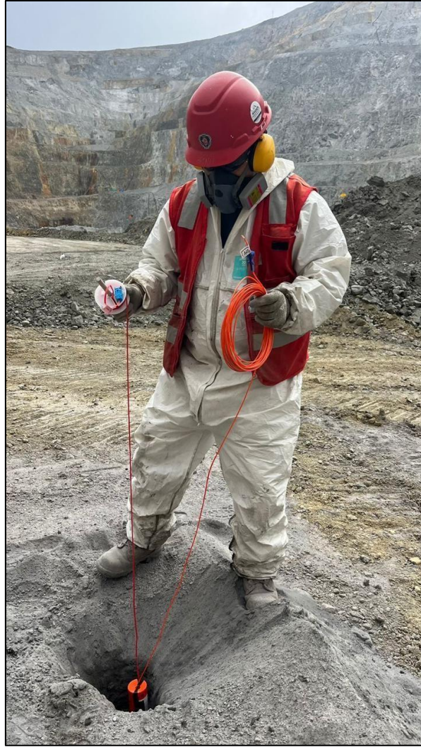
Fotografía 5. Carga de Booster con cable de conexión - Proyecto P3660-112-GF-C8
