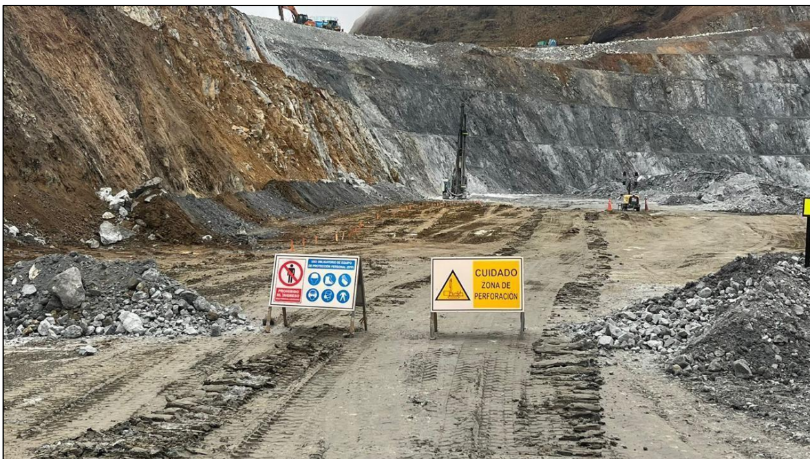
Fotografía 8. Área de perforación y voladura señalizada con letreros de seguridad para prohibir el ingreso del personal no autorizado - Proyecto P3640-067-GF-C8
